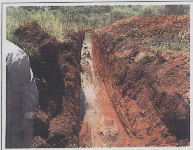
Foto 1 Adutora (inspeção da tubulação)
