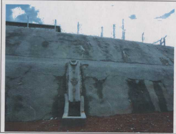
Foto 13 Drenagem superficial para escoamento das águas pluviais do talude
