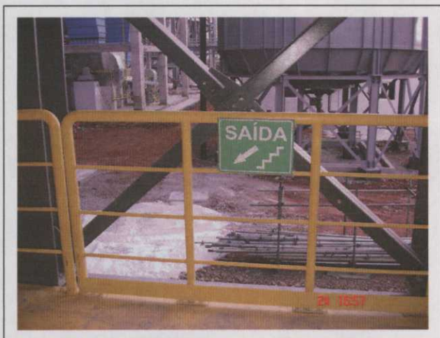
Foto 1 Casa de Máquinas: Placa de sinalização de saída indicativo de descida de escada.
