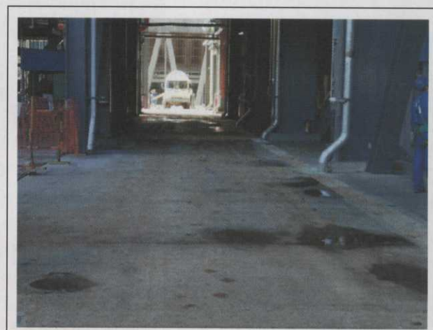
Foto 4 - Via de acesso área dos moinhos de carvão
