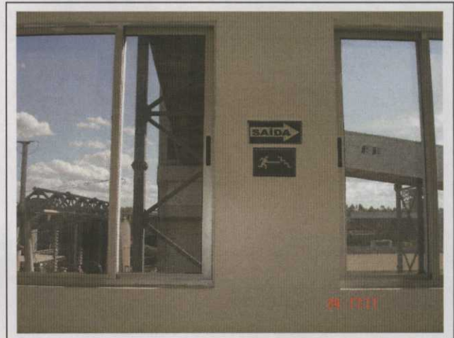
Foto 12 Prédio Central de Controle: Placa de sinalização de saída e descida de escada.
