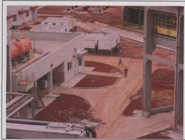
Foto 11 Acesso ao Prédio do Sistema de Desmineralização de Água
