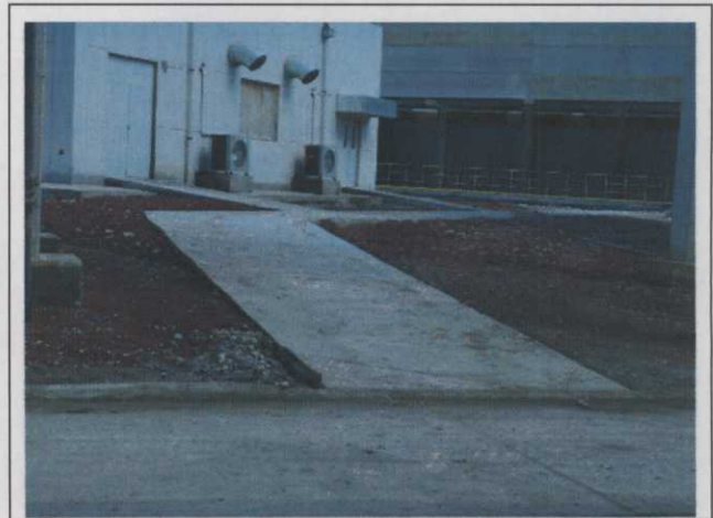
Foto 8 Acesso ao prédio de Painéis Elétricos da Torre de Resfriamento
