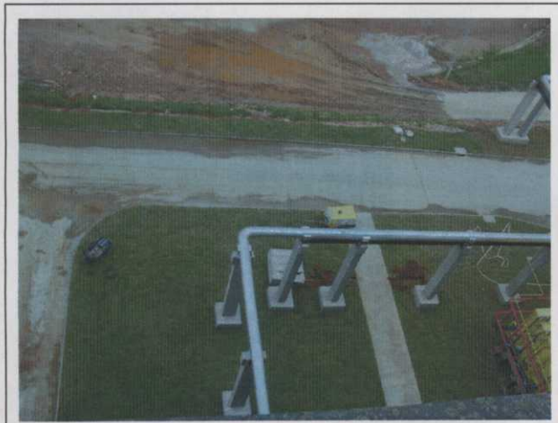
Foto 7 Via de acesso à Casa de Máquinas, já em processo de colocação de grama no canteiro lateral
