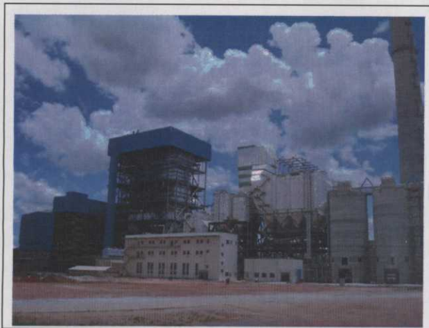
Foto 17 Vista lateral da instalação com as áreas de pré-montagem já desmobilizadas
