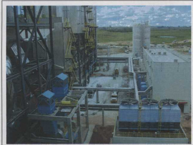
Foto 5 Via de acesso a Área de Abastecimento de Cal
