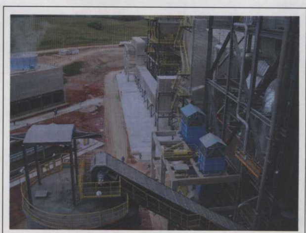
Foto 20 Vista à partir do prédio da caldeira evidenciando a desmobilização das instalações de pré-montagem
