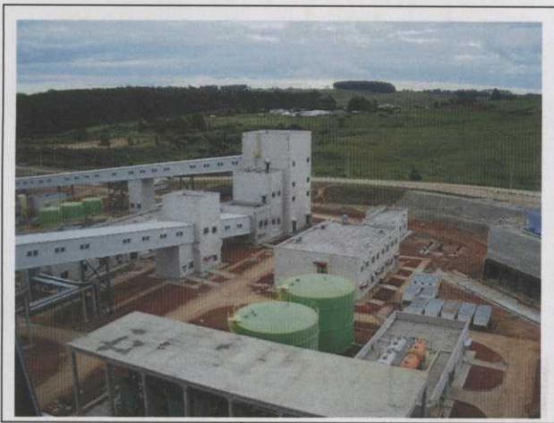
Foto 1 Vias de acesso as Áreas de Abastecimento de produtos químicos
