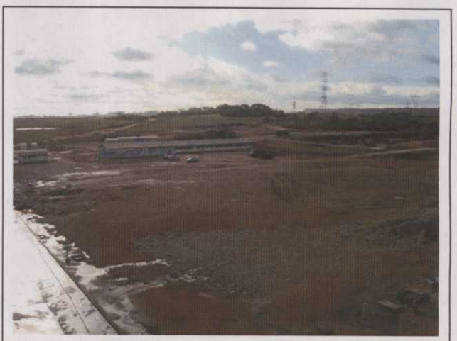
Foto 12 Vista geral do canteiro/desmobilização.
