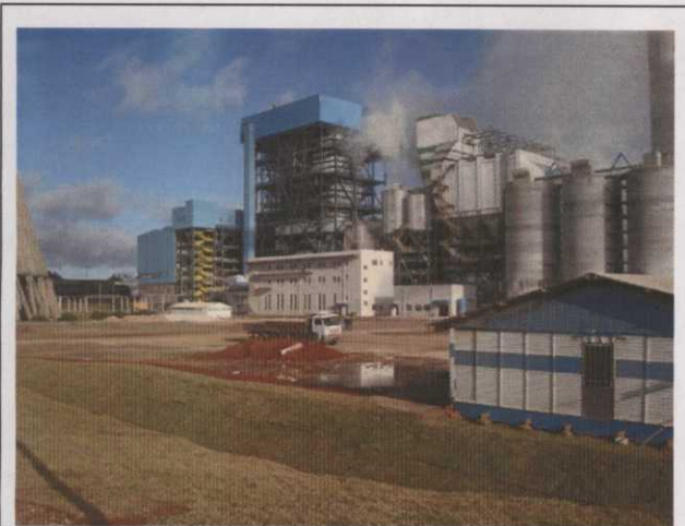
Foto 8 9 Enleivamento de taludes do canal de drenagem pluvial/desmobilização do canteiro
