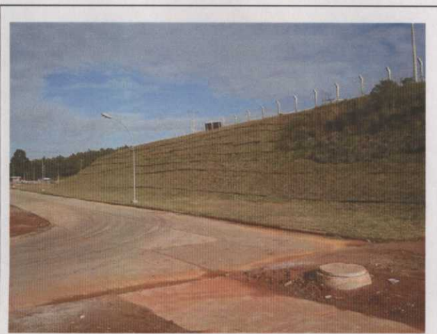
Foto 11 Enleivamento de taludes
