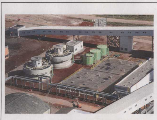
Foto 3 Vista Geral da área do Tratamento de Água
