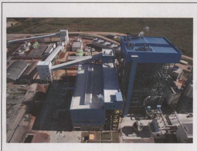
Foto 1 Vista Geral da área da casa de máquinas e caldeira
