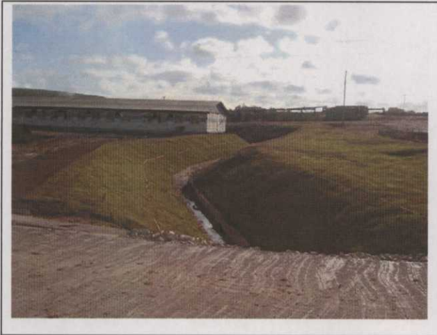
Foto 5 Enleivamento de taludes do canal de drenagem pluvial
