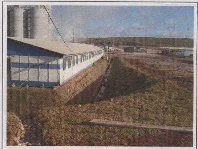
Foto 6 7 Enleivamento de taludes do canal de drenagem pluvial
