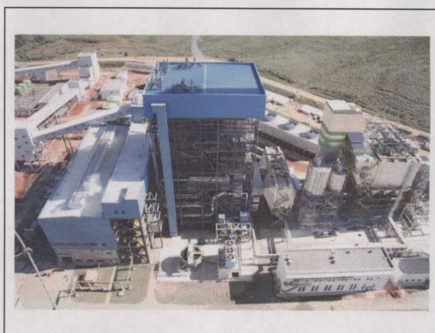
Foto 4 Vissta Geral da Fase C
