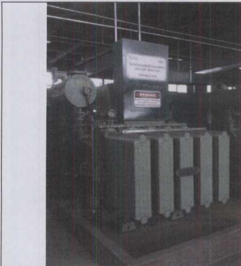
146 - Transformadores com askarel
