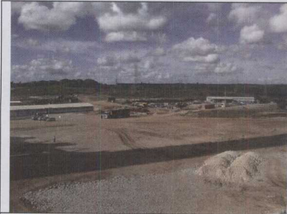
39 - Canteiro de obras
