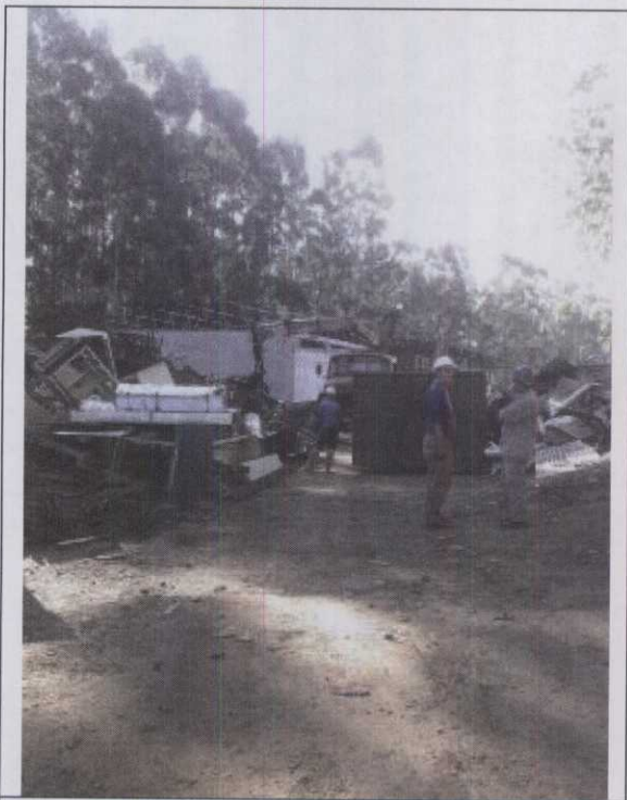
213 - Resíduos Sólidos na Área de Almoxarifado
