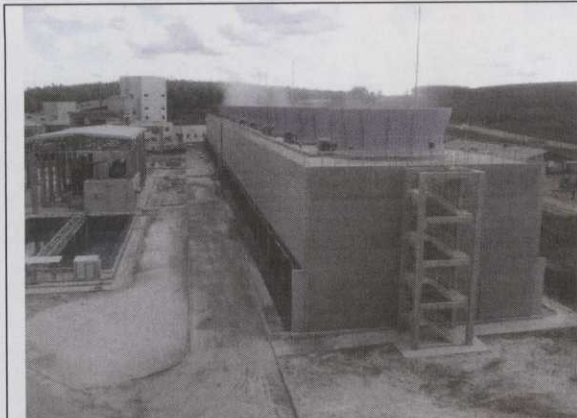
53 - Vazamento das cinzas
