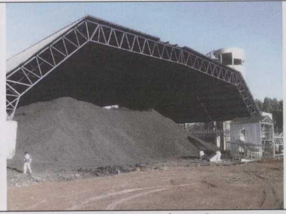
76 - Pátio de armazenamento de carvão
