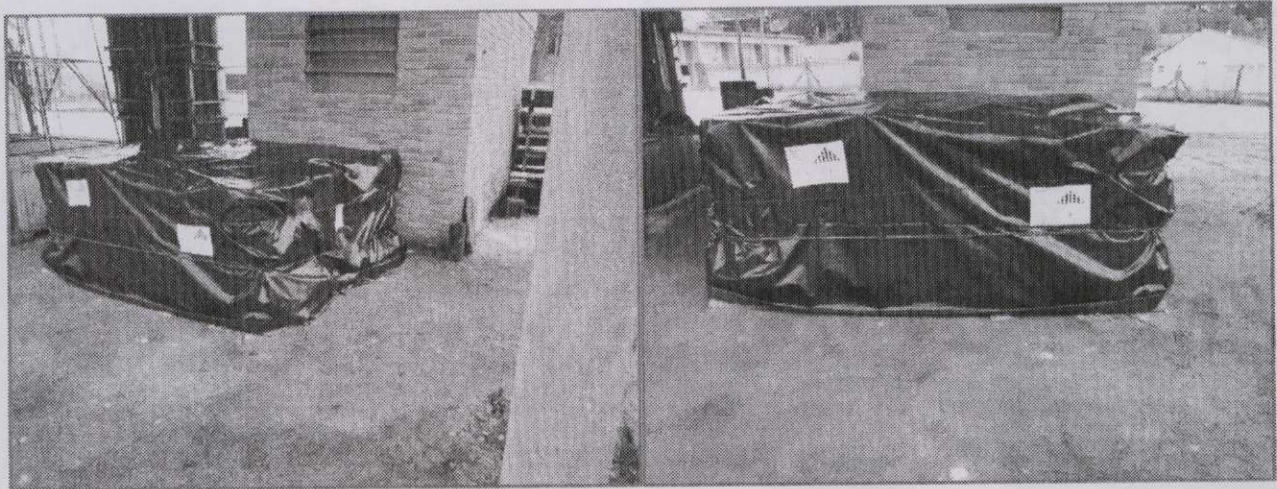
Figura 18 – Acondicionamento e armazenamento temporário de óleo combustível contaminado.
