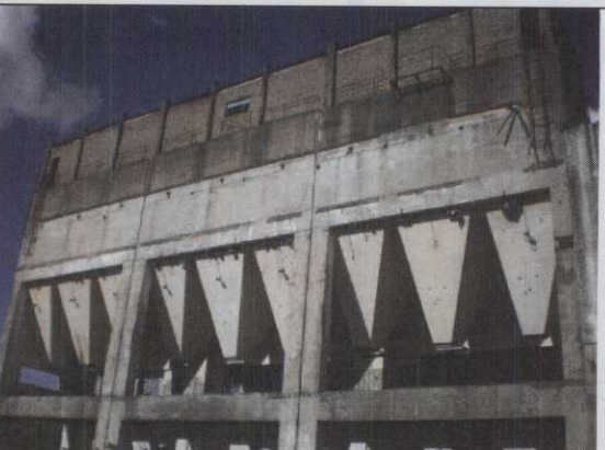
16 – Silos de armazenamento de carvão
