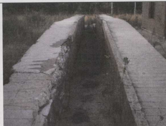
20 - Lavagem de veículos
