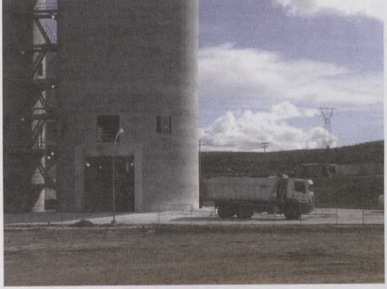
42 - Silos de armazenamento temporário de cinzas de fundo do Dessulfurizador
