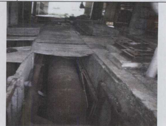
14 – Tubulação abaixo do piso
