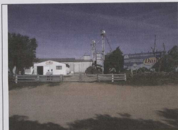
251 - Estação Pedras Altas
