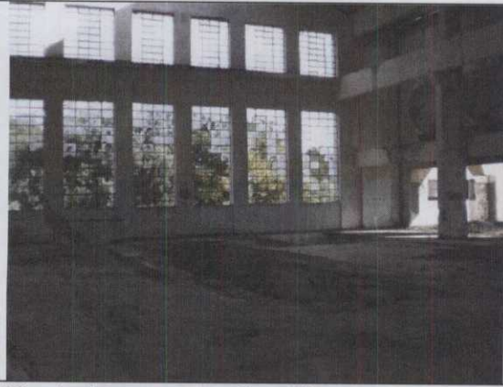
09 – Antigas estruturas do prédio
