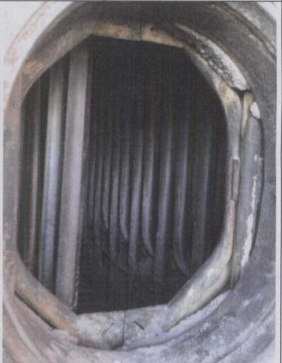
175 – Detalhe da caldeira, com reparo do furo
