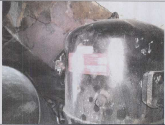
124 - Compressores com fluido R-22
