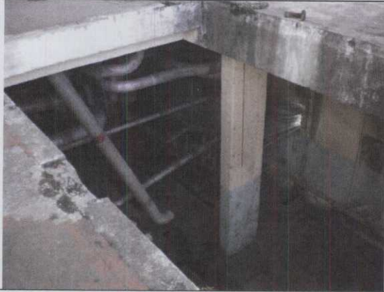
11 – Tubulações da antiga instalação
