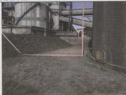
170 e 171 – Detalhe do tanque e o dique
