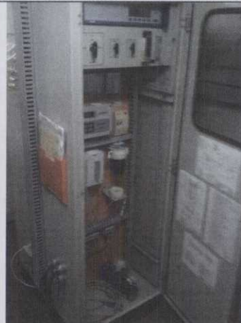
162 – Rack do CEMs contendo analisadores
