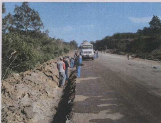
CONSTRUÇÃO DA DRENAGEM - VALAS
