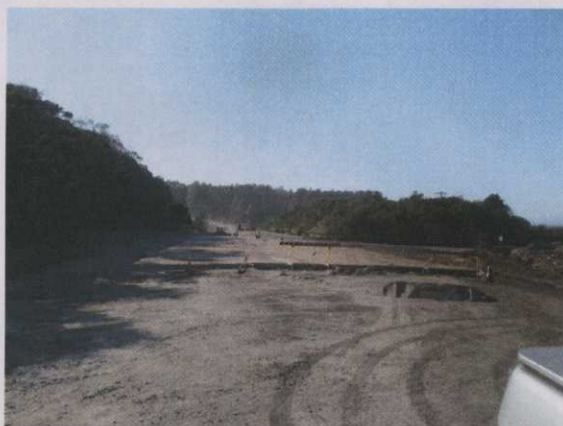
CONSTRUÇÃO DAS PLACAS DE CONCRETO
