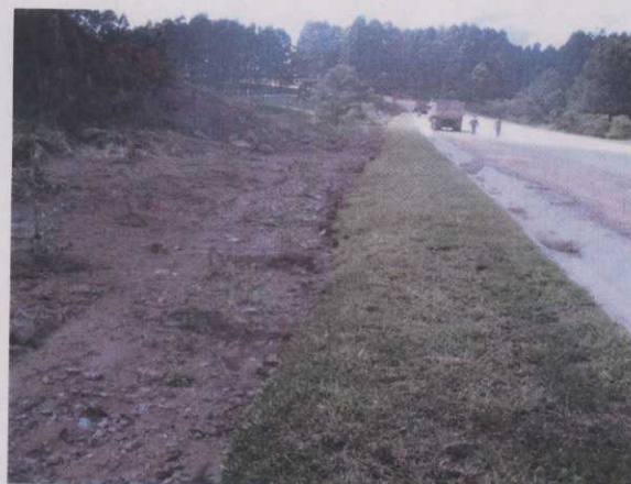
ENLEIVAMENTO DA ESTRADA
