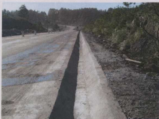
PAVIMENTAÇÃO E VALAS DE DRENAGEM
