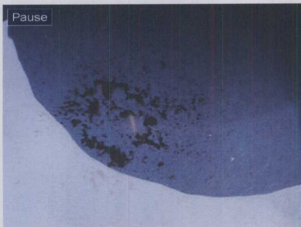
Figura 10: Presença de sedimentos na caixa d'água situado à direita na foto anterior
