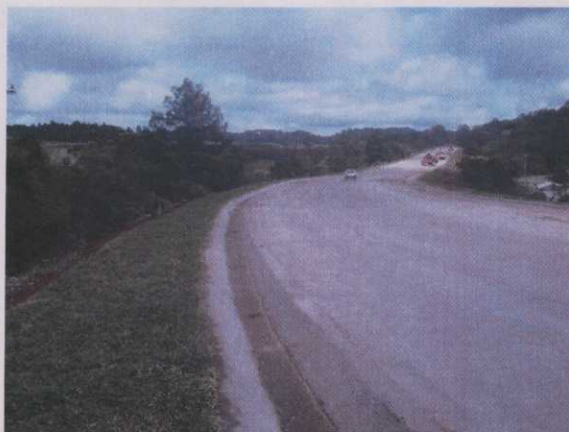
VALAS DE DRENAGEM DA ESTRADA E ENLEIVAMENTO
