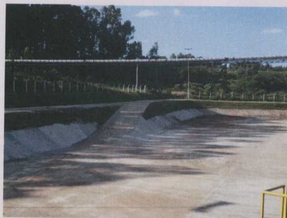
REVESTIMENTO EM CONCRETO DO FUNDO E TALUDES DA BACIA 2
