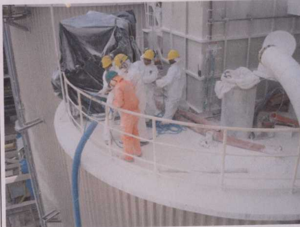
Figura 3 – Trabalhadores posicionando mangote de sucção no topo do silo de cal hidratada
