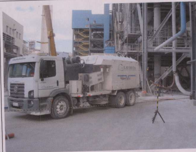
Figura 6 – Posicionamento do caminhão auto-vácuo durante trabalhos diurnos
