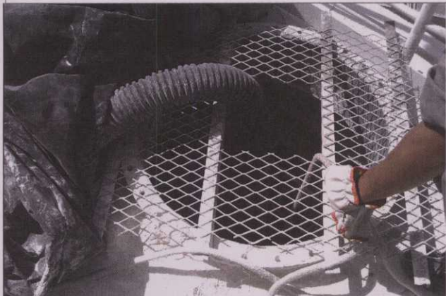
Figura 13: Sucção do silo para limpeza.
