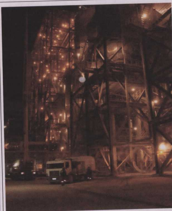
Figura 9 - Caminhão auto-vácuo em operação durante trabalhos noturnos
