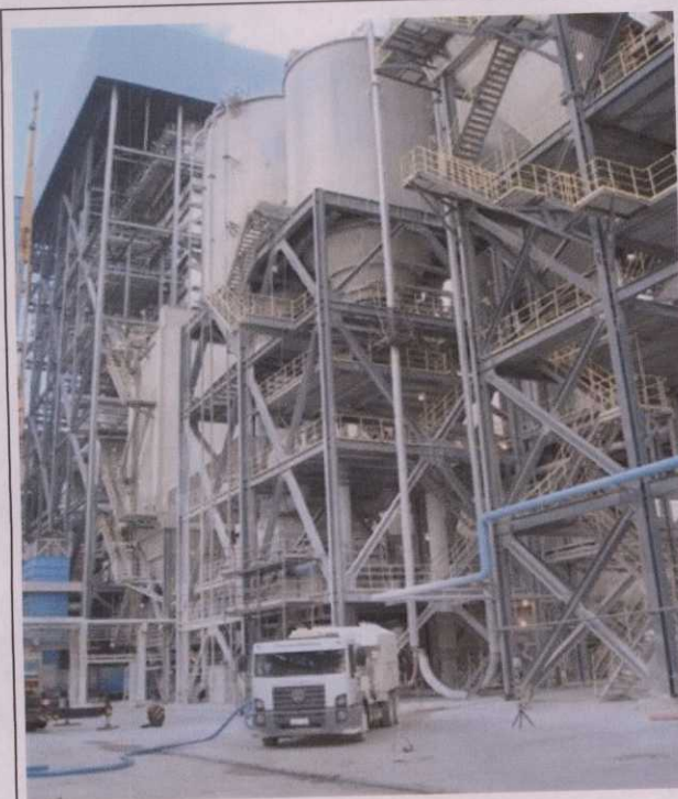
Figura 8 - Caminhão auto-vácuo em operação durante trabalhos diurnos
