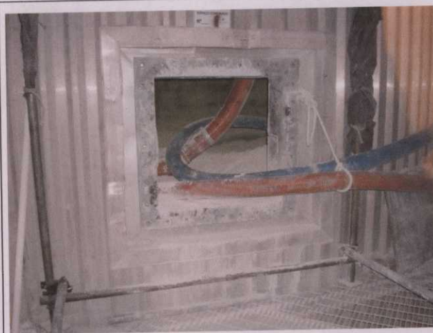
Figura 5 – Mangotes posicionados através da porta de inspeção lateral
