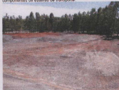
Foto 6: Local de instalação da Planta Piloto, execução da terraplanagem.
