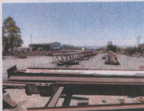
Foto 4: Equipamentos mecânicos em fase de recuperação, componentes da esteiras de transporte.
