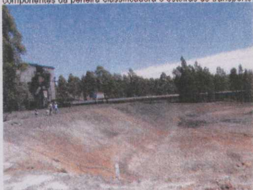
Foto 5: Local de instalação da Planta Piloto, execução da terraplanagem.
