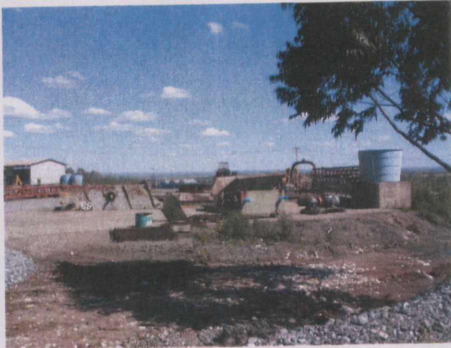
Foto 2: Visão geral dos equipamentos em manutenção, armazenados na área da CRM.
