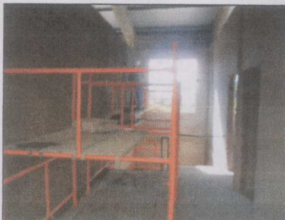
Figura 05 – Imagem do interior do prédio sendo reformado.
