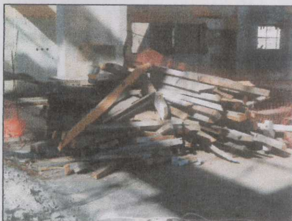
Figura 06 – Restos de madeiras retirados do interior do prédio.
