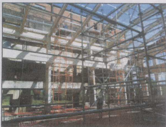
Figura 04 – Imagem do interior do prédio sendo reformado.
