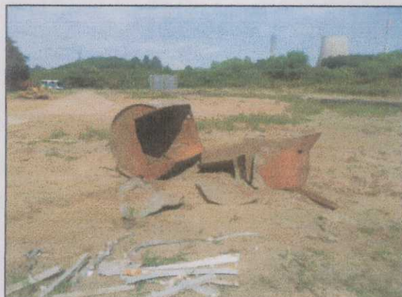
Figura 09 – Estruturas metálicas retiradas do prédio para fins de destinação. Algumas peças como esta serão revitalizadas e mantidas no interior do prédio.
