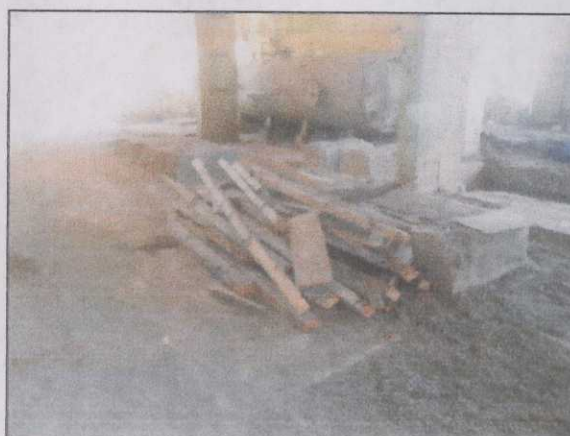
Figura 07 – Madeiras retiradas do prédio para posterior aproveitamento na obra.
