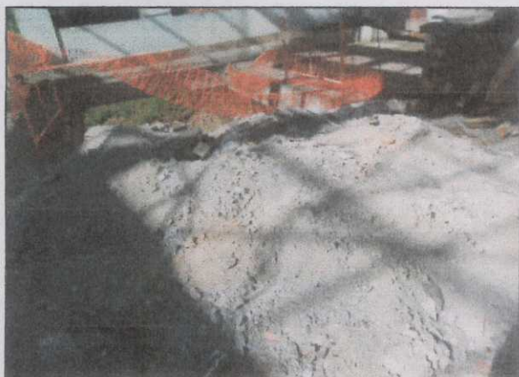
Figura 08 – Cascalho oriundo da remoção de rebocos, restos de argamassa e cimento.
