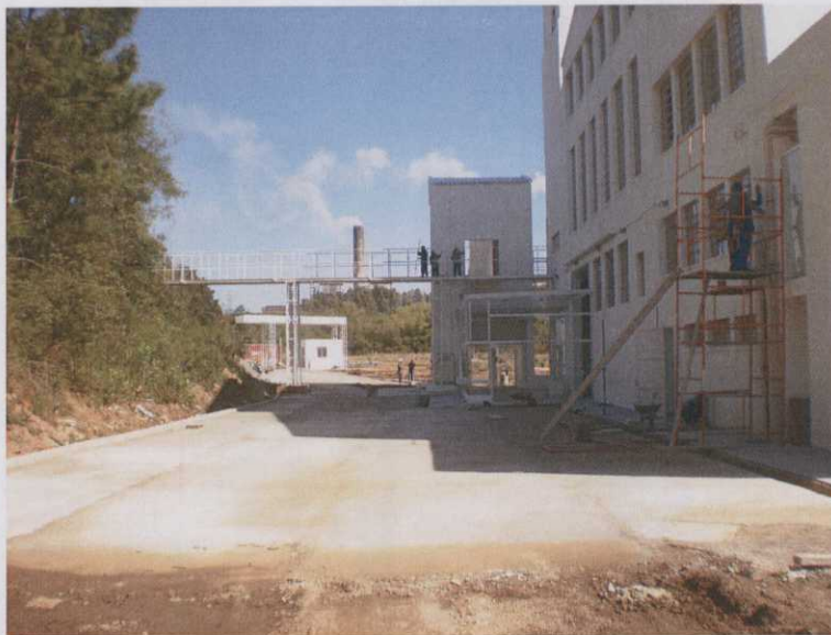
Foto 02 – Vista Externa – Pavimentação de Acessos
