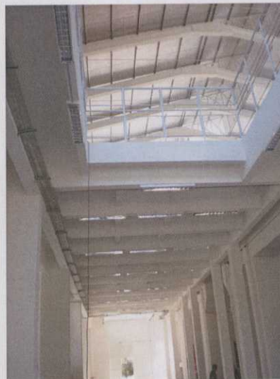
Foto 10 – Vista Interna Geral Nível 0,00 m
