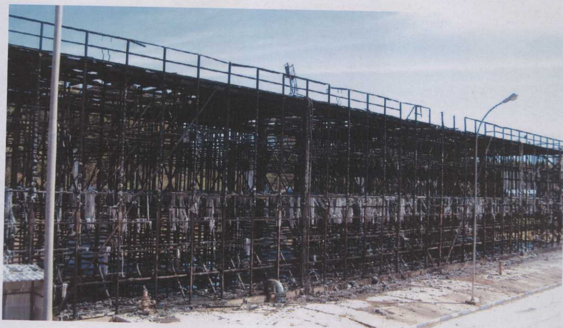
Foto 6: Visão frontal-central da torre.
