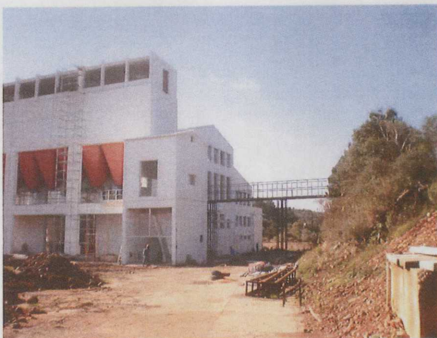
Foto 10 – Vista a partir da Guarita de acesso
