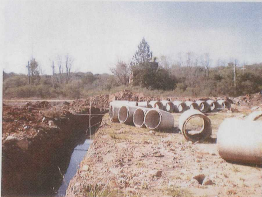
Foto 12 – Vista da área externa com tubos e escavações da Prefeitura Municipal
