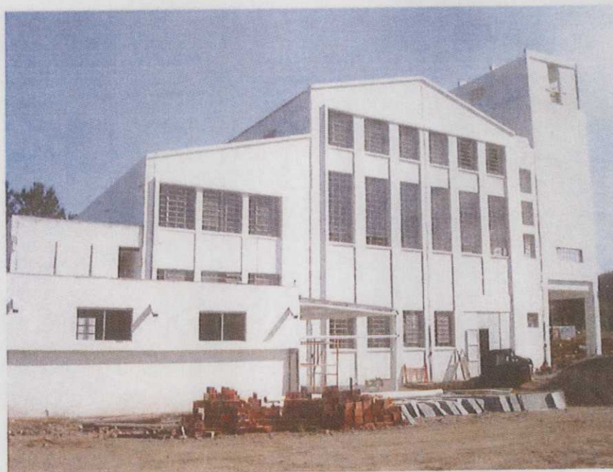
Foto 6 – Fachada Nordeste c/ acesso coberto Biblioteca
