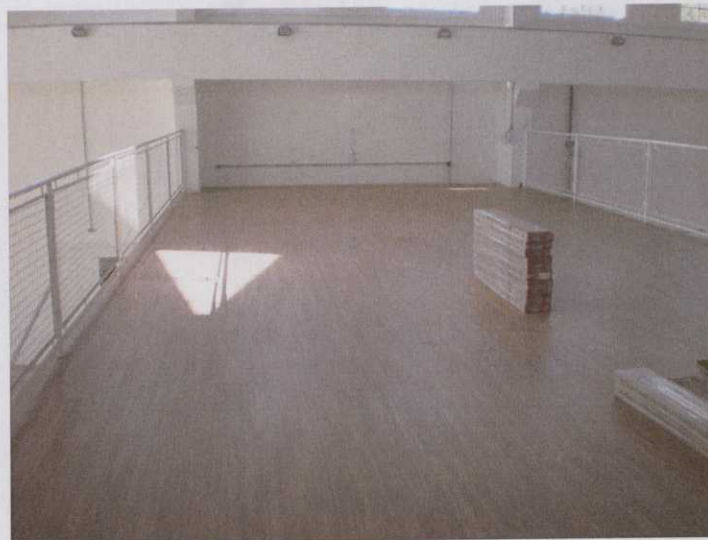
Foto 08 – Pisos Laminados Compartimentos Internos
