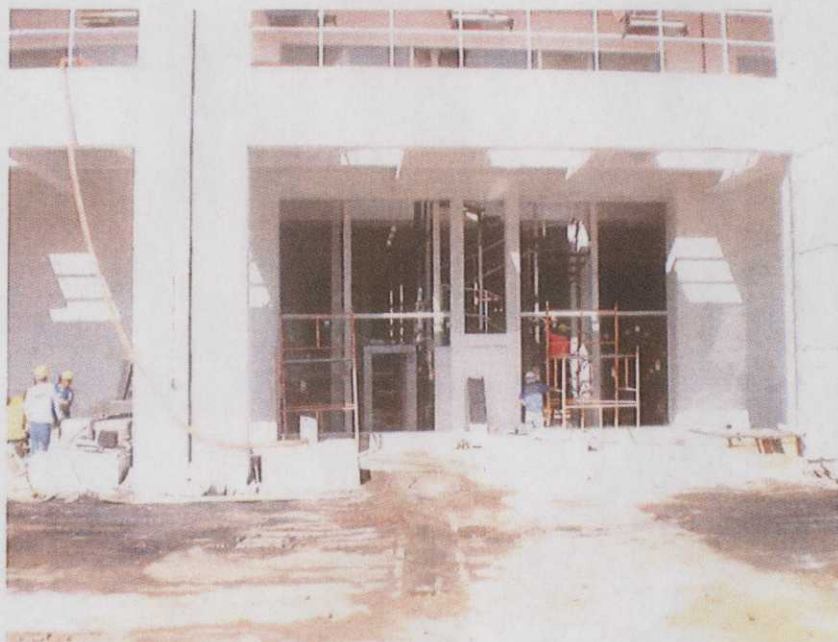
Foto 14 – Vista Externa com Elevador Panorâmico
