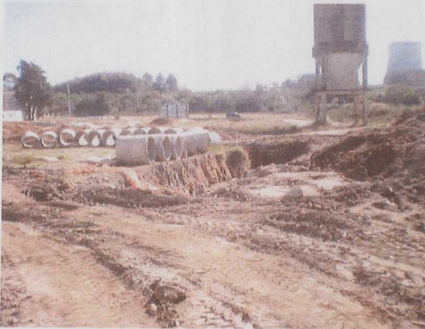
Foto 11 – Vista da área externa com tubos e escavações da prefeitura Municipal
