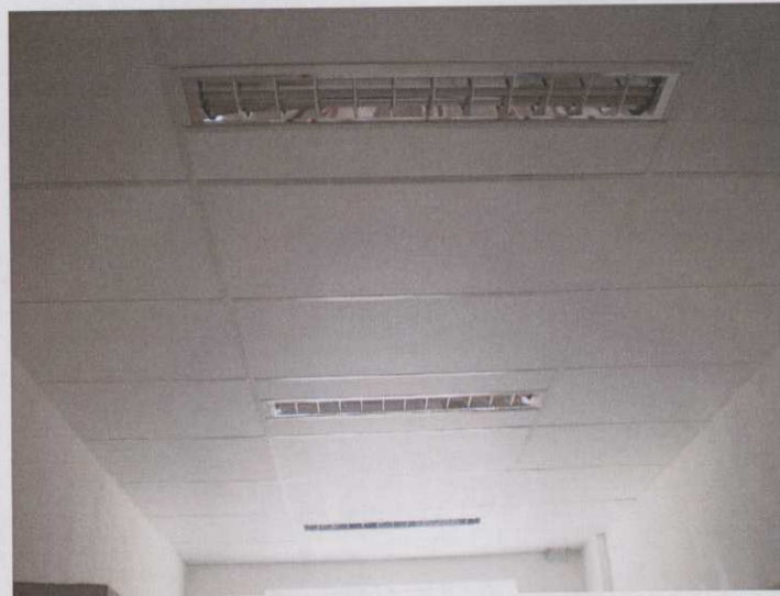
Foto 07 – Forro Gesso Compartimentos Internos
