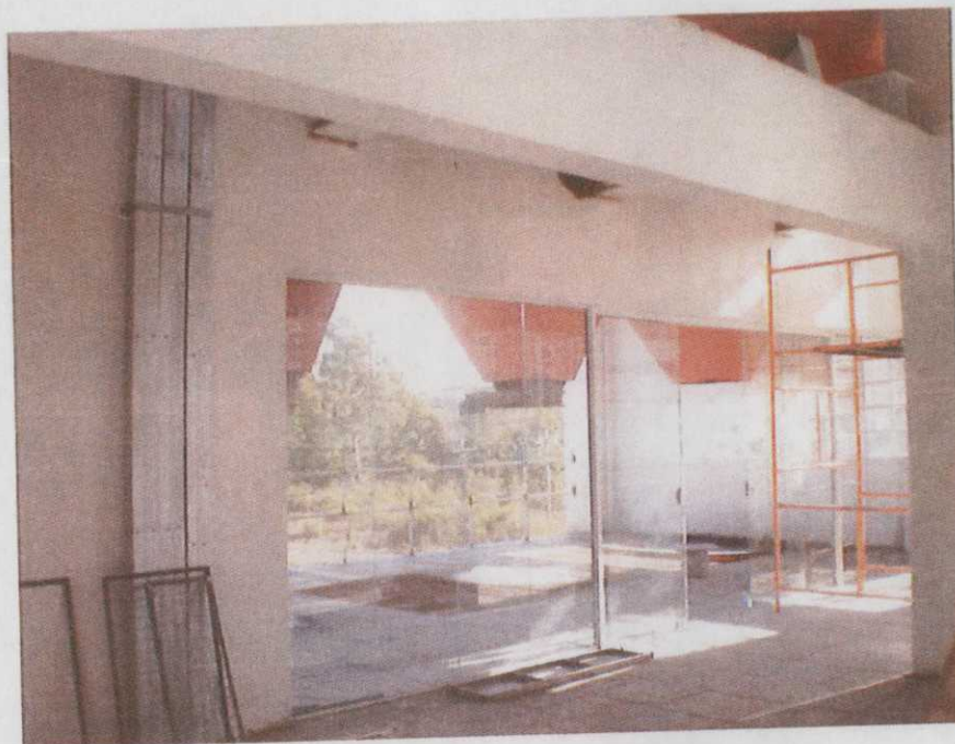
Foto 2 – Vista do acesso ao Pátio dos Silos
