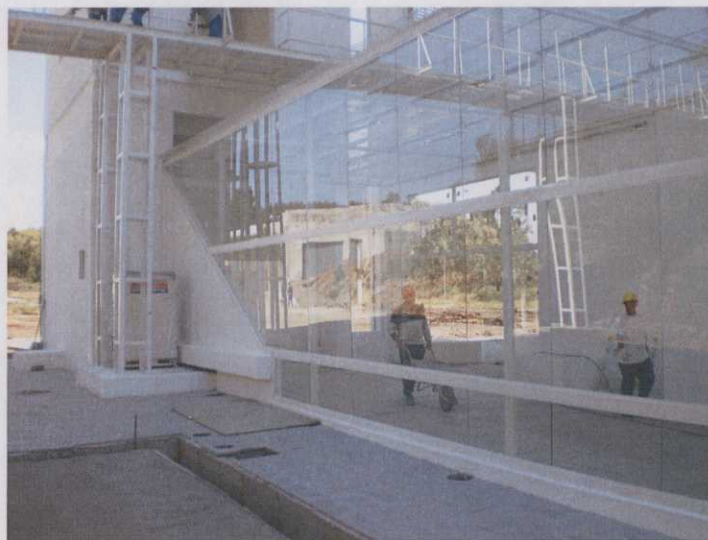
Foto 03 – Vista Externa Acesso Principal
