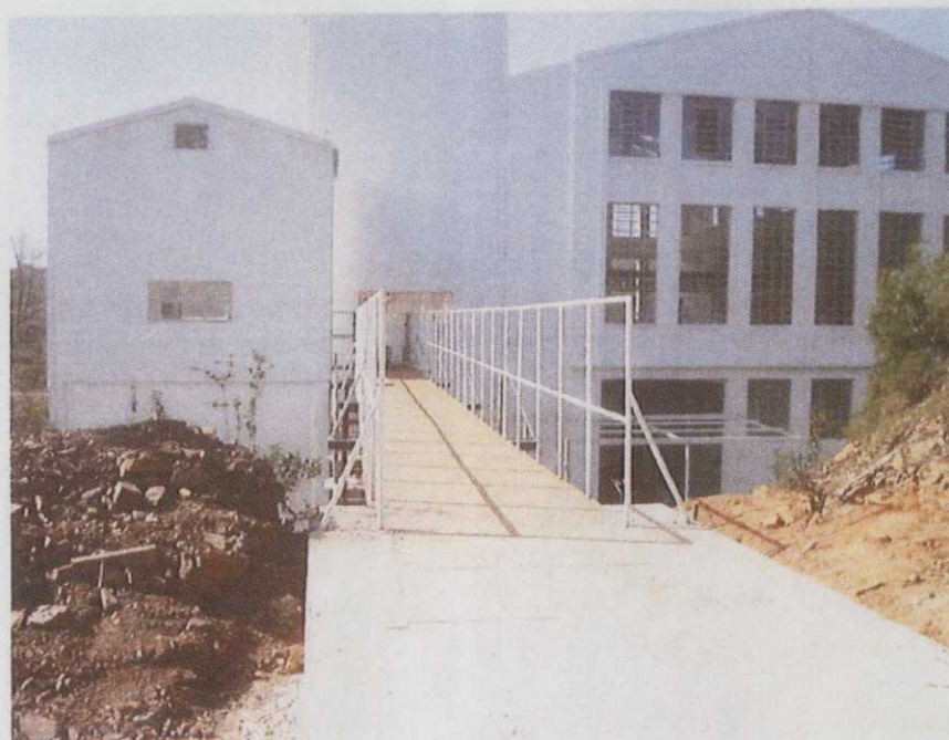
Foto 8 – Fachada Sudoeste- Detalhe Passarela de acesso
