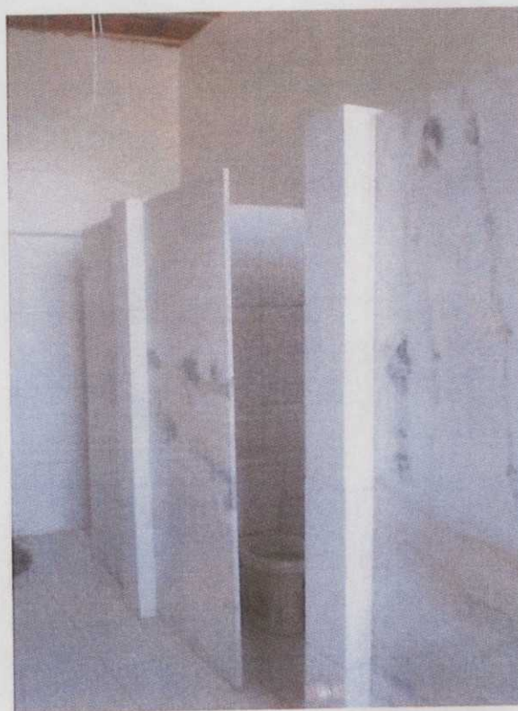
Foto 4 – Vista Interna Sanitários
