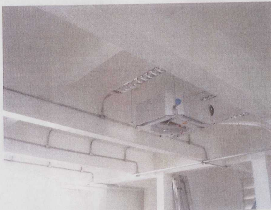
Foto 3 – Detalhe da instalação de sistemas de climatização
