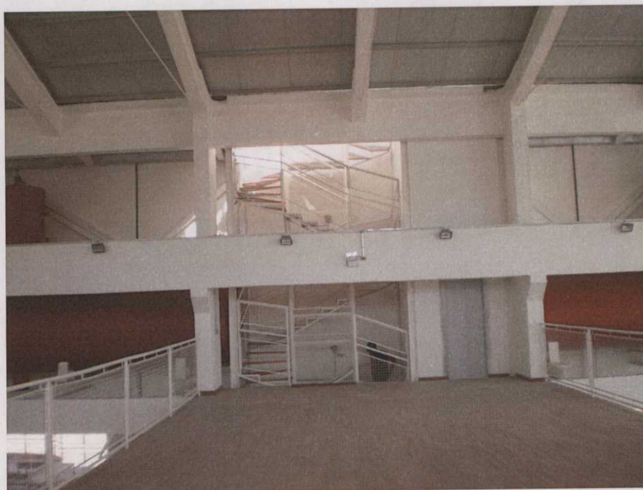
Foto 24 – Vista Mezzanino nível + 9,70 m
