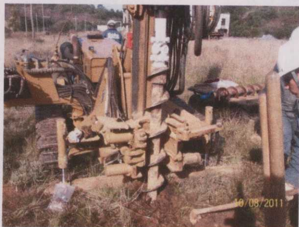
Figura 9. Instalação do poço de monitoramento PMC4.
