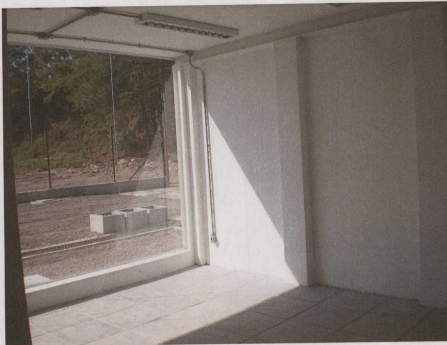
Foto 17 – Sala de Aula – nível 0,00 m
