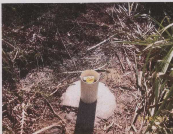
Figura 16. Vista do poço PMC5.
