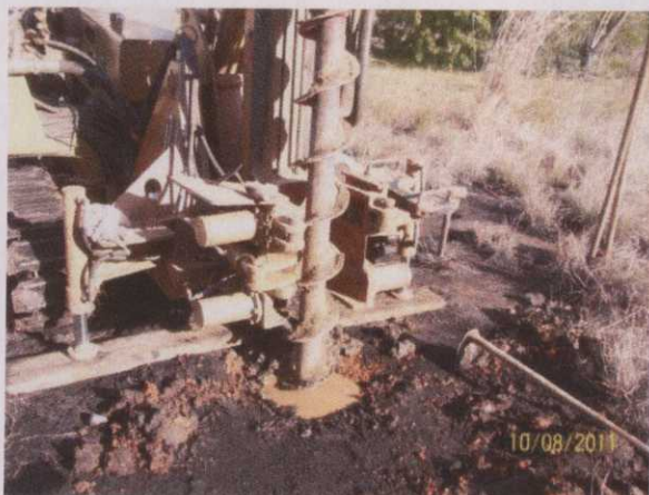
Figura 7. Execução da perfuração do poço de monitoramento PMC3.
