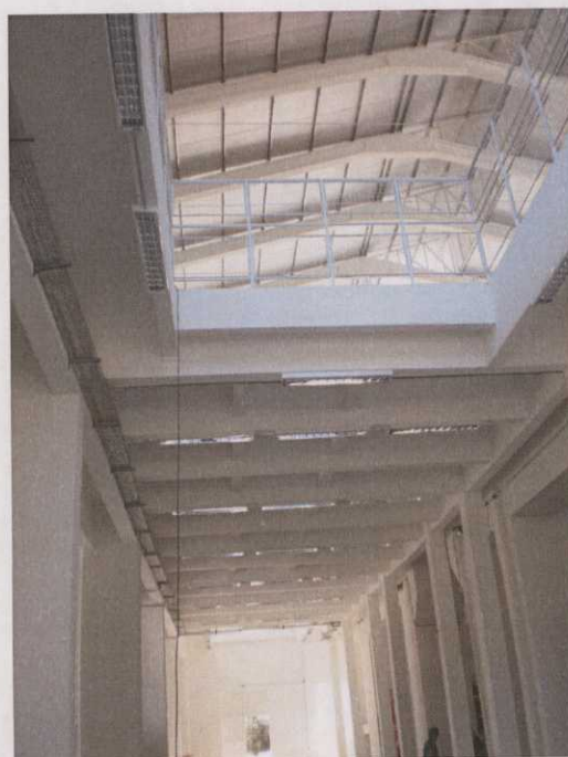
Foto 12 – Vista Interna Geral Nível 0,00 m
