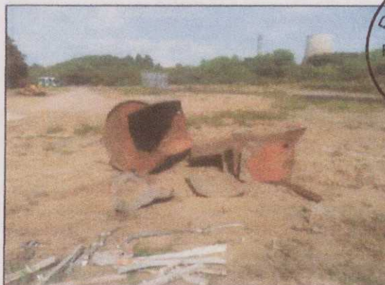
Figura 09 – Estruturas metálicas retiradas do prédio para fins de destinação. Algumas peças como esta serão revitalizadas e mantidas no interior do prédio.
