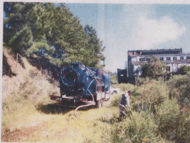
Foto 2: Desobstrução do Sistema de Escoamento e Esgoto Cloacal utilizando Caminhão Multitarefa.
