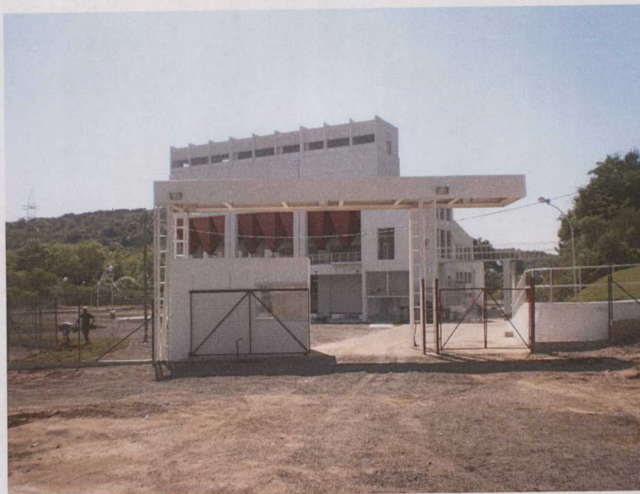
Foto 05 – Vista Externa Guarita de Acesso - Fachada Noroeste
