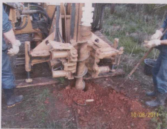
Figura 5. Execução da perfuração do poço de monitoramento PMC2.
