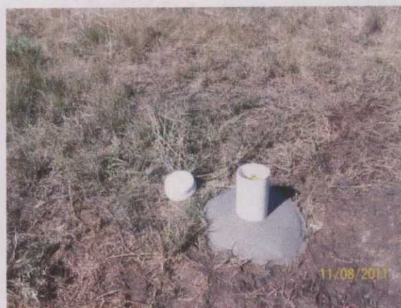
Figura 15. Vista do poço PMC4.
