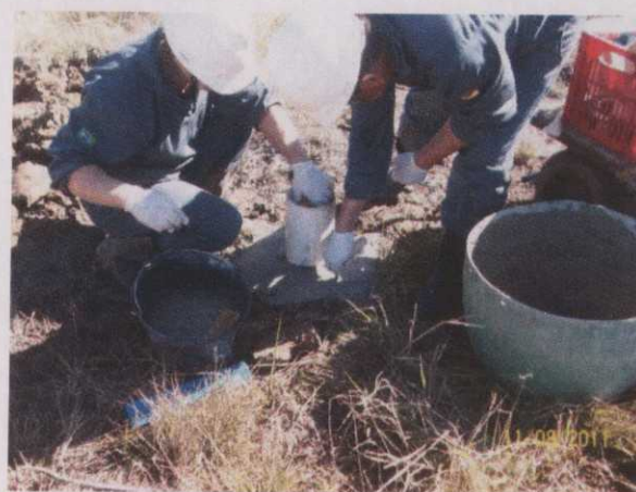
Figura 6. Vista da execução do selamento e acabamento final do poço PMC2.
