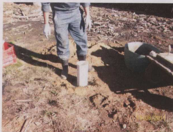
Figura 4. Execução do selamento e acabamento final do poço PMC1.
