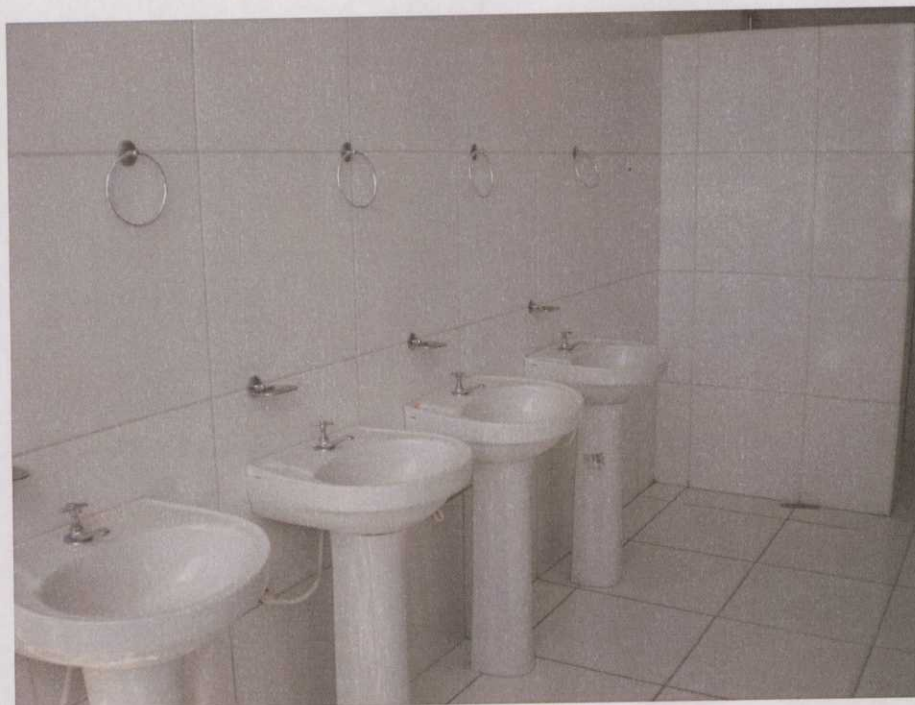
Foto 31 - Vista Interna Sanitários
