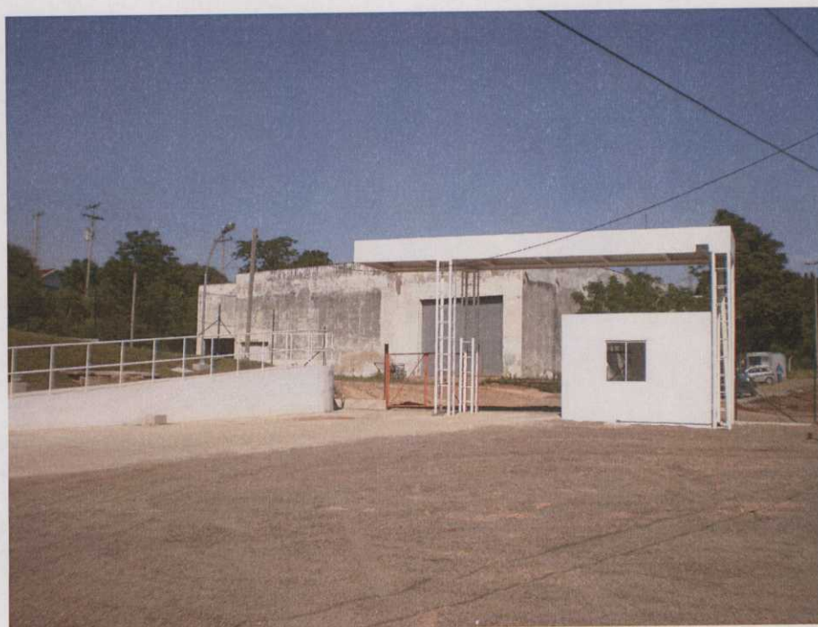
Foto 04 – Vista Guarita/Rampa de Acesso
