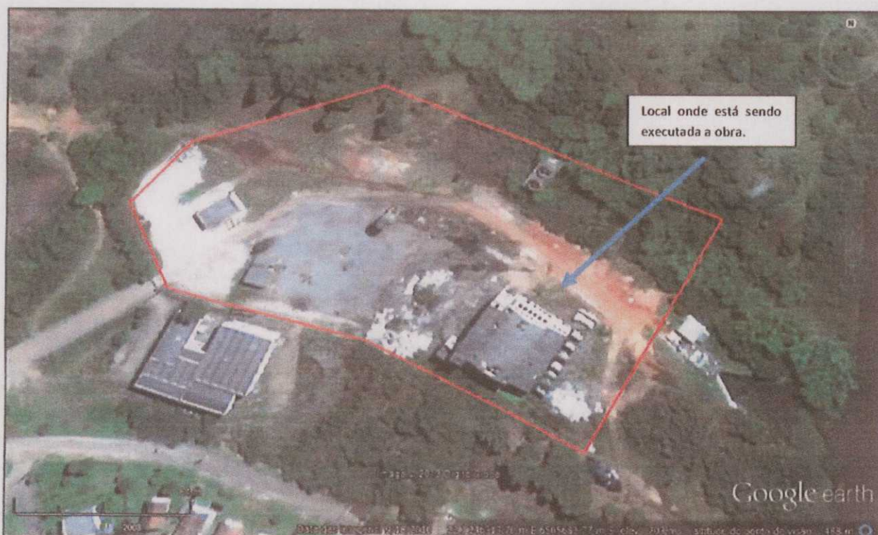
Figura 01 – Imagem mostrando o perímetro da área circundado em vermelho e indicação do local onde está sendo realizada a obra de reforma.
