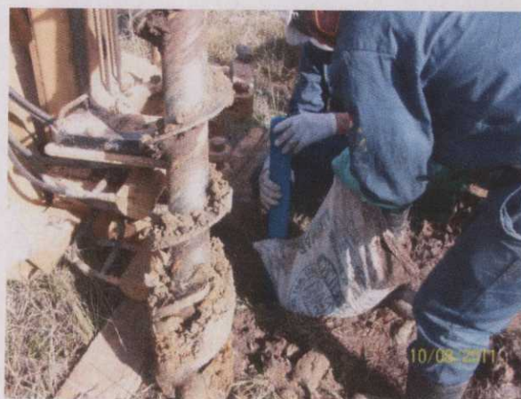
Figura 10. Instalação do poço de monitoramento PMC4.
