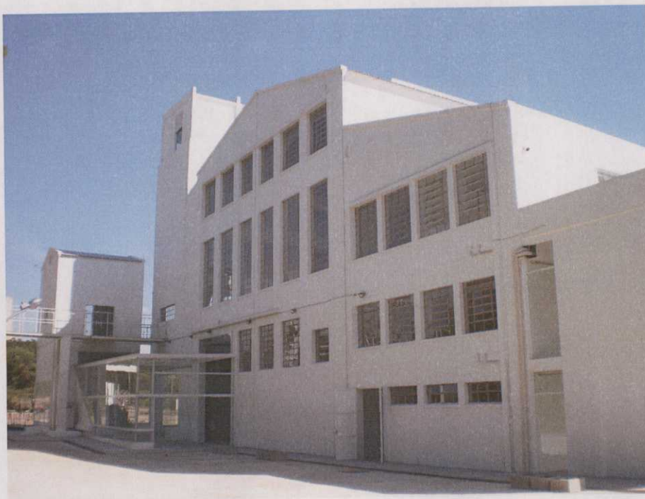
Foto 03 – Vista Externa Fachada Sudoeste
