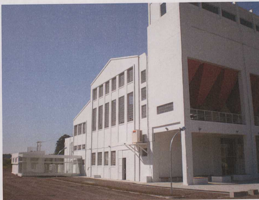
Foto 01 – Vista Externa Fachada Nordeste
