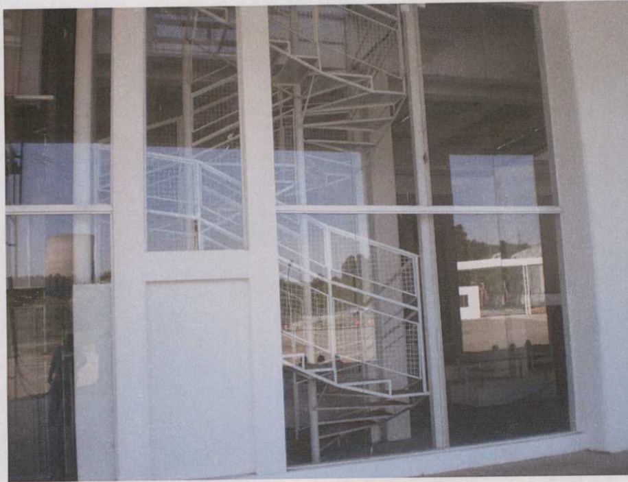
Foto 09 – Vista Externa Circulação Vertical/Elevador Panorâmico Nível 0,00 m
