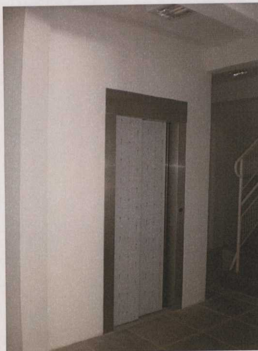
Foto 13 – Elevador Serviço nível 0,00 m
