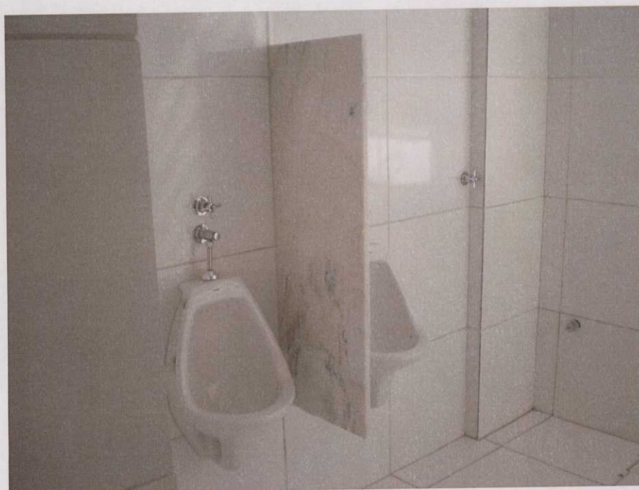
Foto 32 - Vista Interna Sanitários
