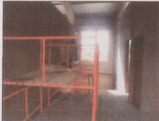
Figura 05 – Imagem do interior do prédio sendo reformado.
