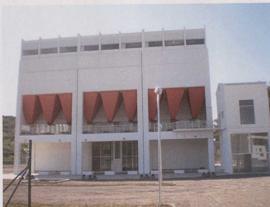
Foto 02 – Vista Externa Fachada Noroeste
