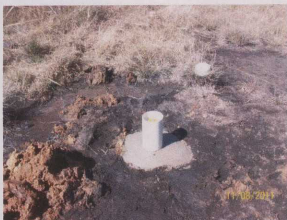
Figura 14. Vista do poço PMC3.
