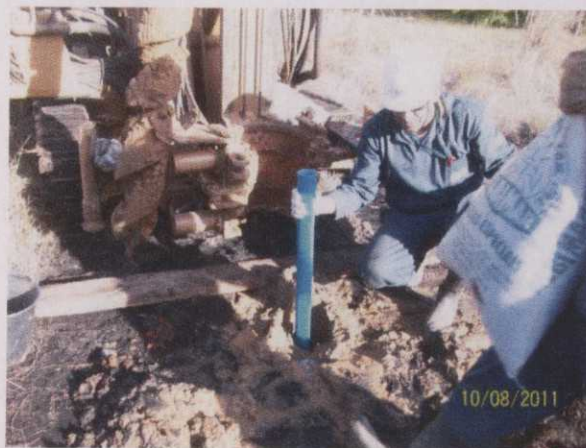
Figura 8. Instalação do poço de monitoramento PMC3.
