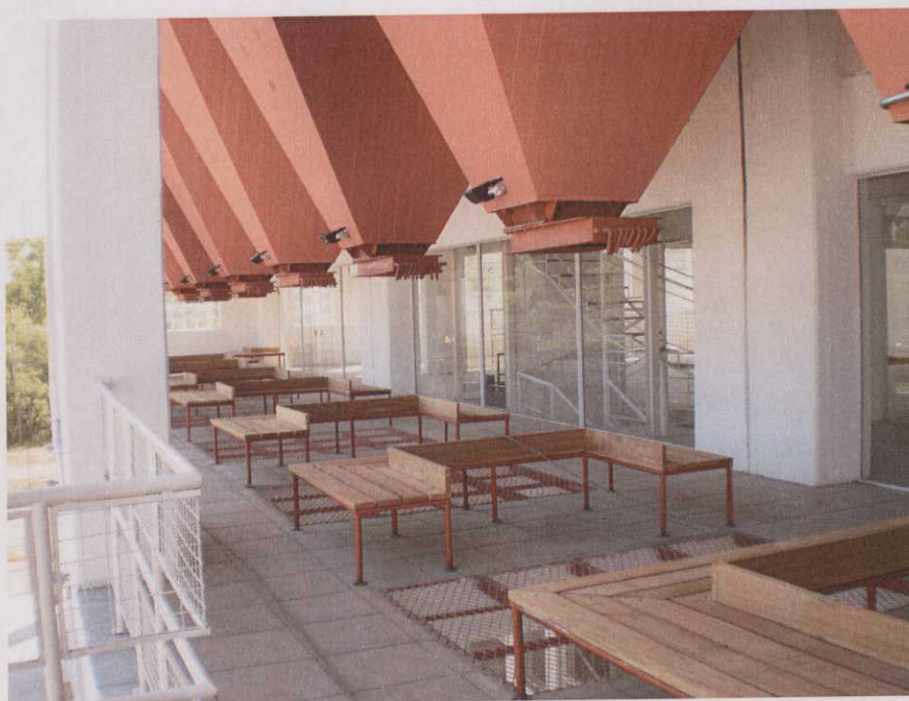
Foto 22 – Pátio dos Silos – nível + 6,30 m
