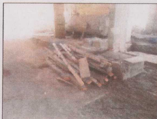
Figura 07 – Madeiras retiradas do prédio para posterior aproveitamento na obra.
