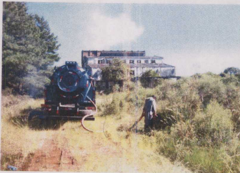
Foto 1: Desobstrução do Sistema de Escoamento e Esgoto Cloacal utilizando Caminhão Multitarefa.
