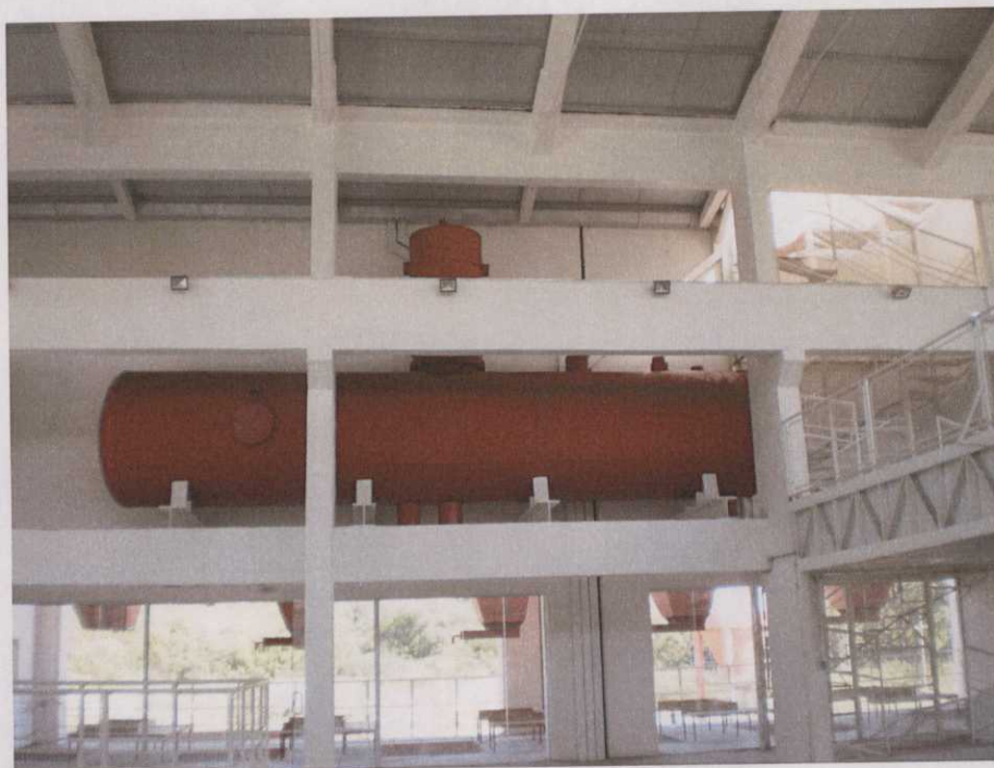
Foto 21 – Vista nível + 6,30 m
