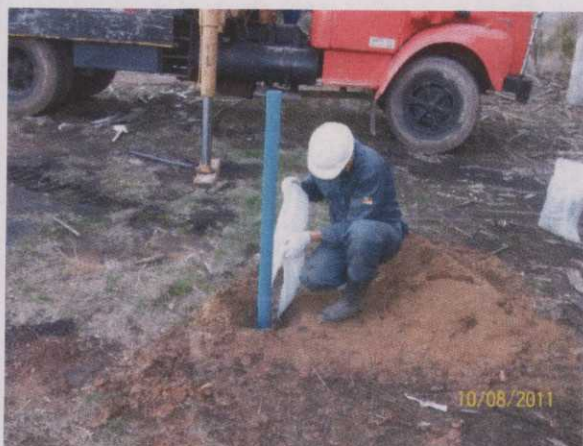
Figura 3. Instalação do poço de monitoramento PMC1.
