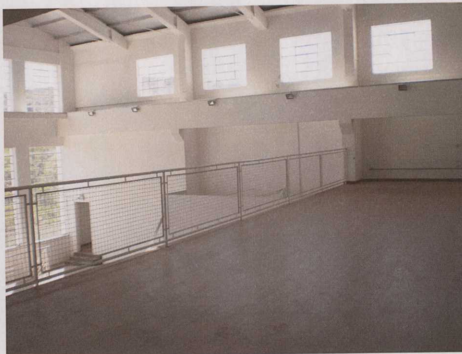
Foto 23 – Vista Mezzanino nível + 9,70 m
