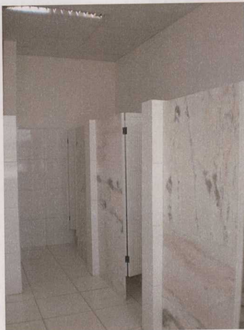
Foto 30 – Vista Interna Sanitários
