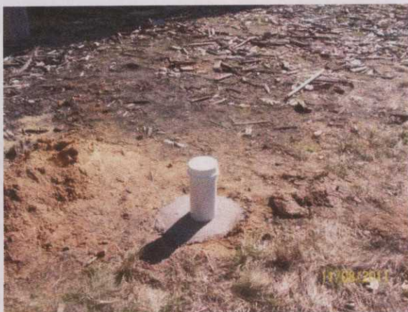
Figura 12. Vista do poço PMC1.
