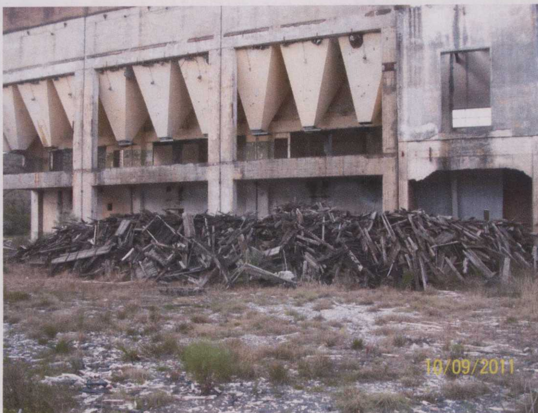
Figura 29. Disposição de madeira tratada junto à edificação da Usina Candiota I.
