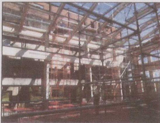
Figura 04 – Imagem do interior do prédio sendo reformado.
