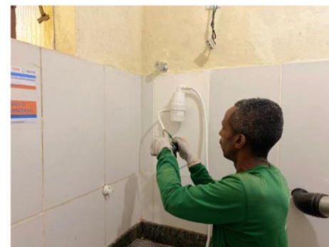
Manutenção da ducha na sala de banho dos cães
