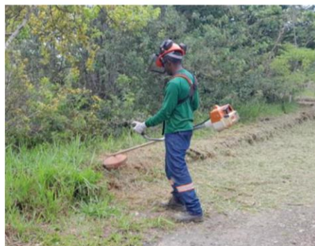
Roçada da área externa
