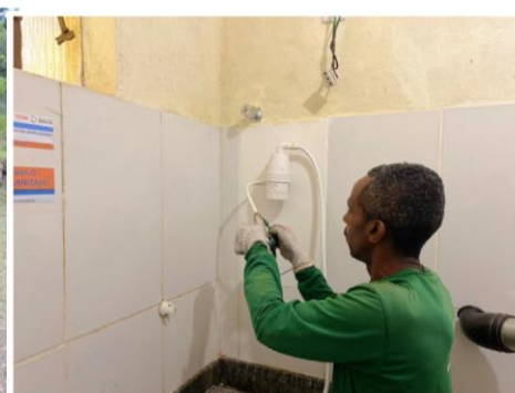
Manutenção da ducha na sala de banho dos cães
