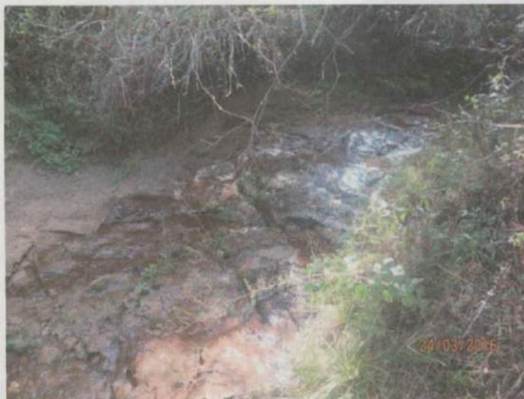
Foto 6: Vista interna do canal de drenagem com presença de fio d'água.
