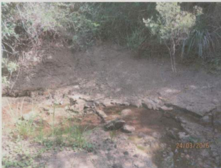
Foto 5: Vista interna do canal de drenagem com presença de fio d'água.
