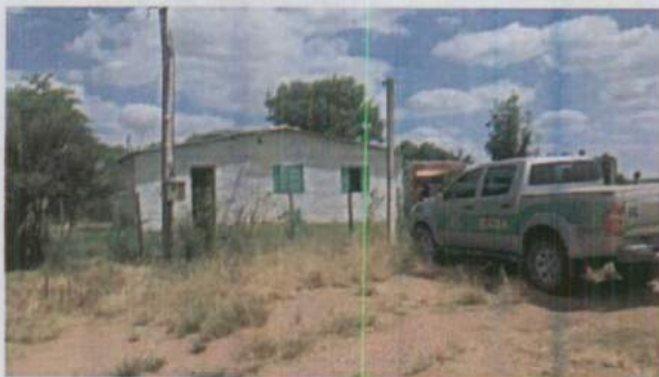
Ilustração 26: Residência do proprietário da área 02
