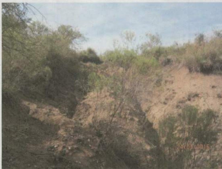
Foto 4: Vista interna do canal de drenagem.
