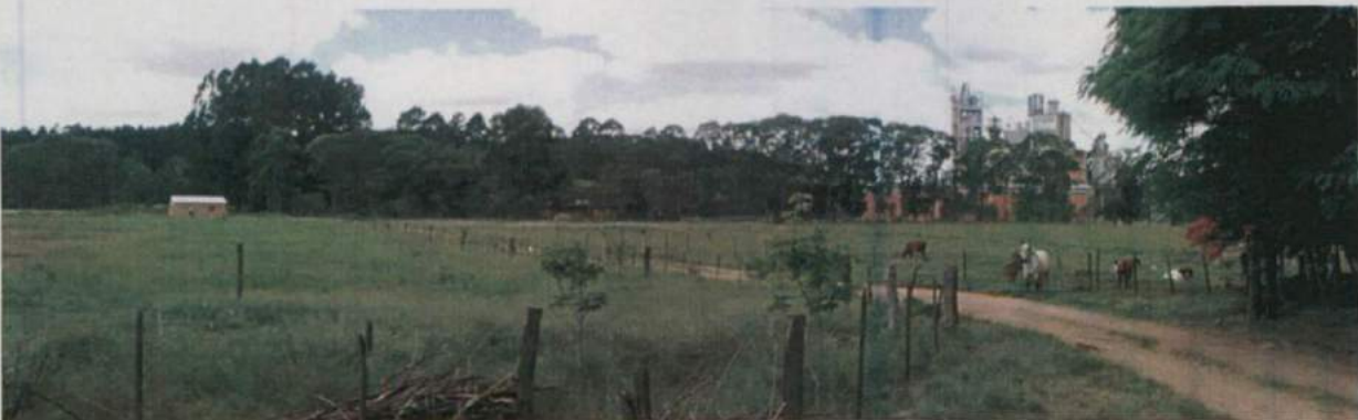
Ilustração 24: (Propriedade 1A) A esquerda, construção afetada pela linha de transmissão; a direita, a cimenteira.
