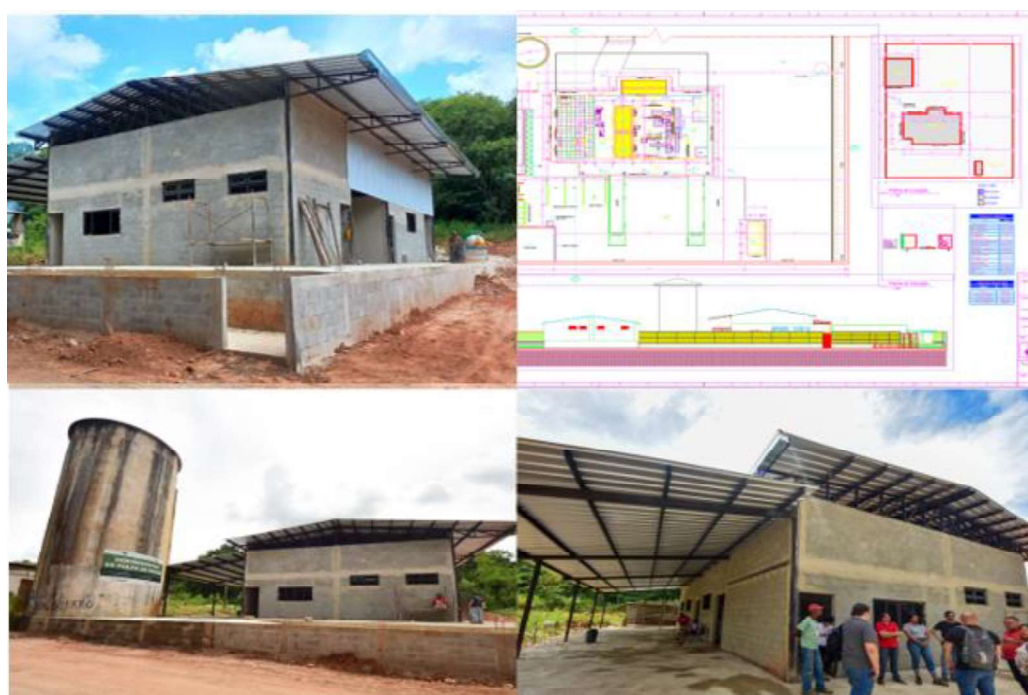
Figura 7 Etapas da obra
