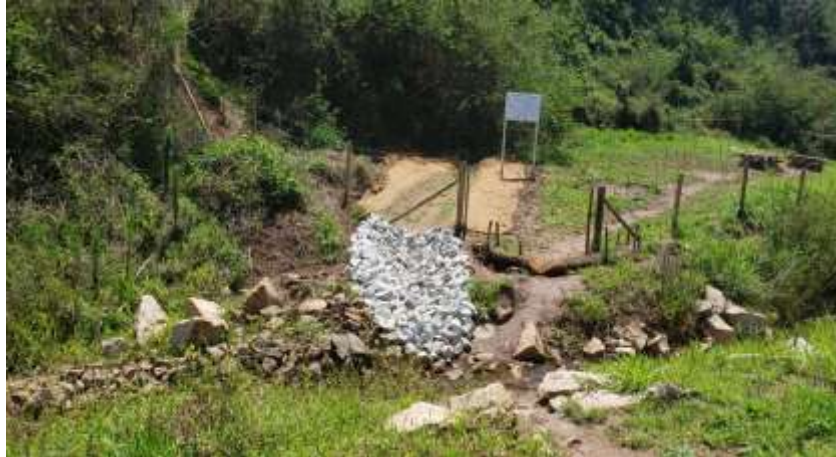
Execução de drenagens e saídas de água do tributário TG06.
