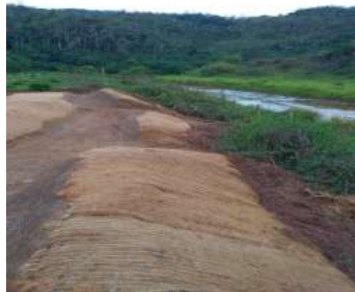
Execução de retentores nas margens do rio Gualaxo no Trecho 6
