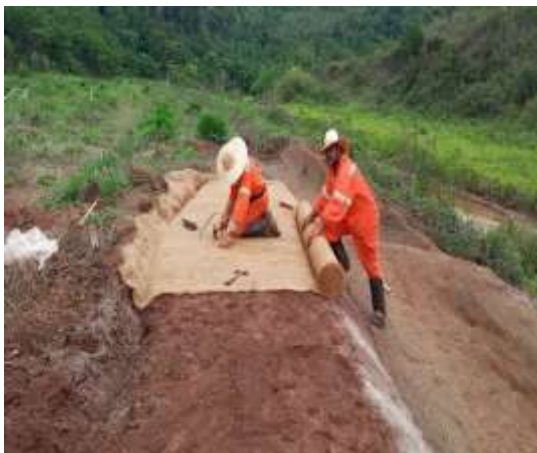
Execução de retentores nas margens do rio Gualaxo no Trecho 6
