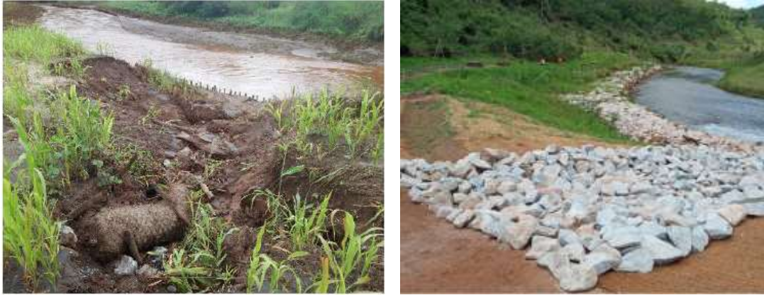
Execução de saída de drenagem – Trecho 6 (antes e depois)
