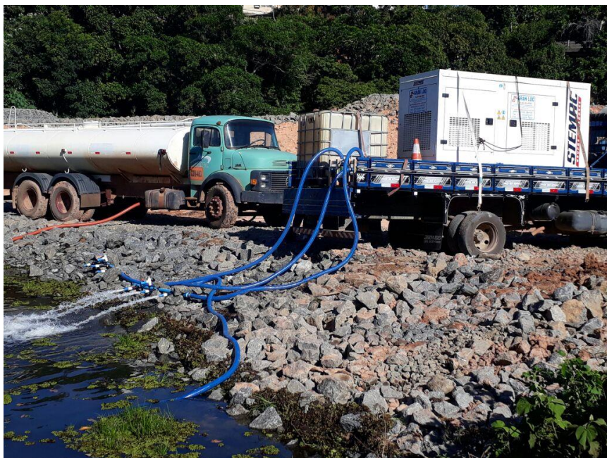
Acompanhamento da instalação dos aeradores no rio Pequeno. Janeiro/2018. Linhares, ES.
