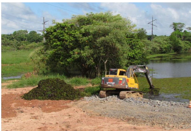
Acompanhamento de campo no momento da retirada de macrófitas do rio Pequeno. Janeiro/2018. Linhares, ES.
