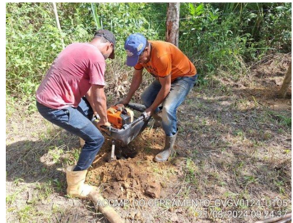
Figura 9 - Acompanhamento do cercamento. Fonte: Acervo Fundação Renova.
