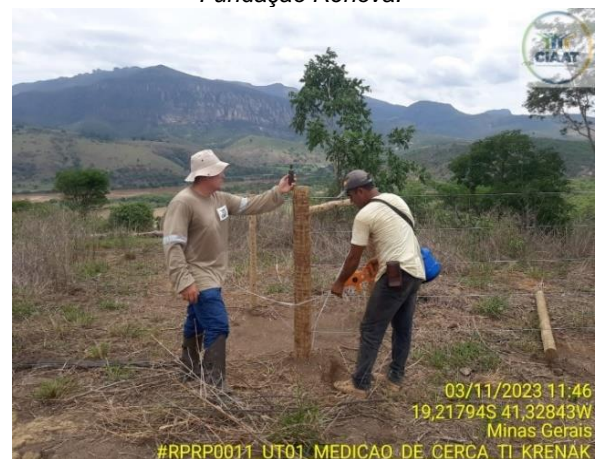
Figura 17 - Acompanhamento de cercamento. Fonte: Acervo Fundação Renova.
