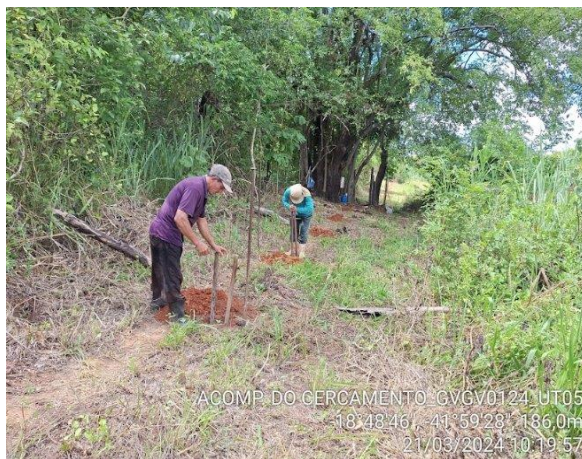
Figura 10 - Acompanhamento de cercamento. Fonte: Acervo Fundação Renova.
