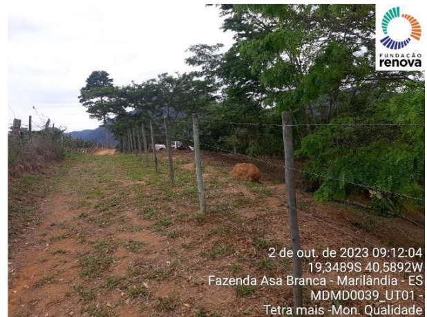
Figura 137 - Detalhe da ausência de aceiro. Fonte: Acervo Fundação Renova.
