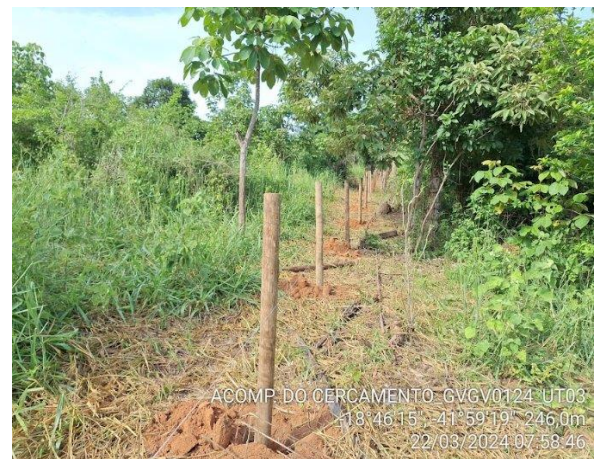
Figura 11 - Acompanhamento de cercamento. Fonte: Acervo Fundação Renova.
