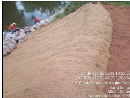
Aplicação de biomanta no talude reconformado
