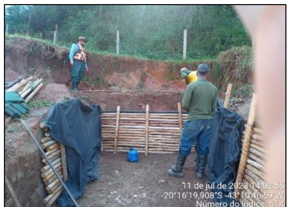
Paliçadas em execução.
