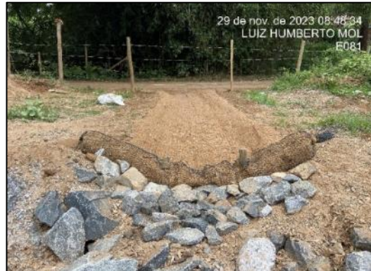
Proteção de talude com enrocamento
