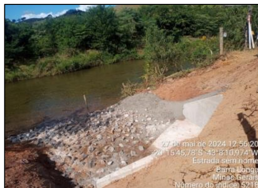
Dissipador de energia argamassada.
