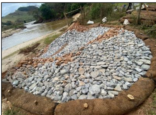
Descida d’água com pedra de mão e retentores.
