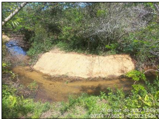
Retaludamento, adubação, semeio e cobertura com biomanta
