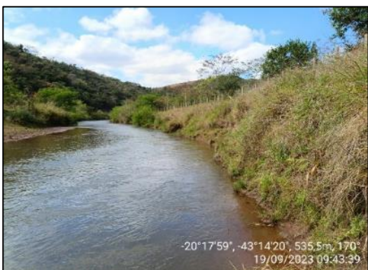
Local a ser executado.
