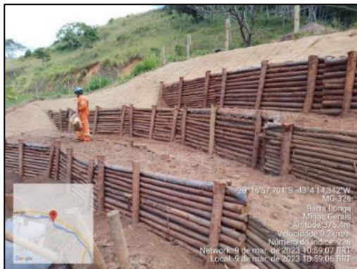
Instalação de paliçadas
