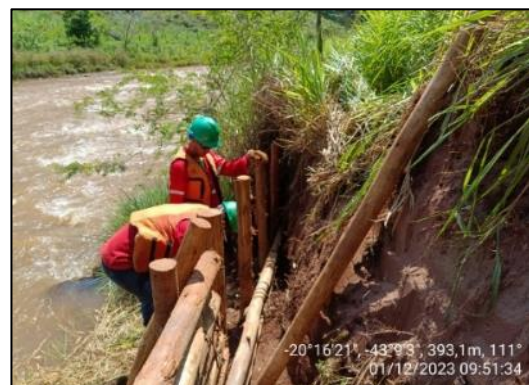
Paliçadas em andamento.
