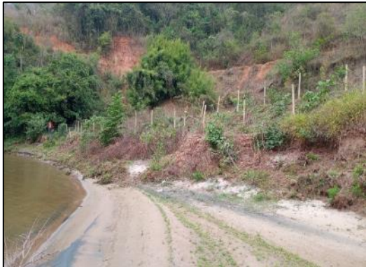
Local a ser executado.
