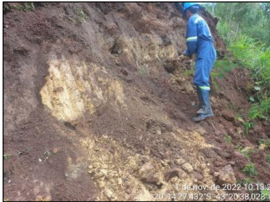
Regularização manual em andamento.
