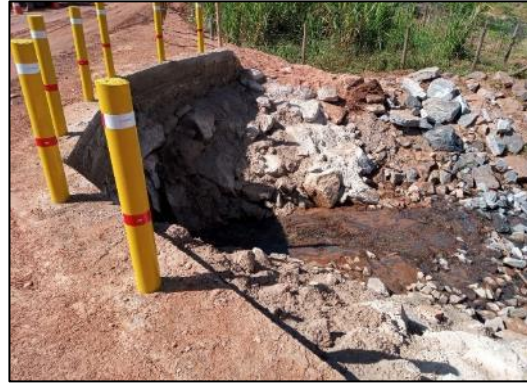
Bueiro com proteção
