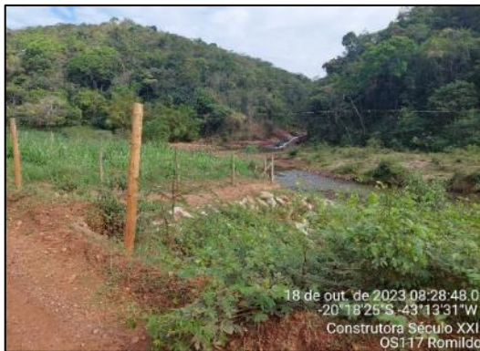
Local de intervenção.
