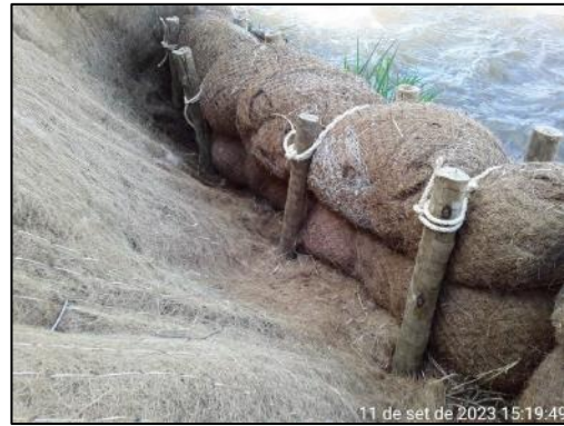
Biomanta e bioretentores concluídos.
