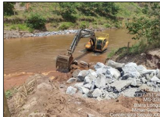
Enrocamento em execução.
