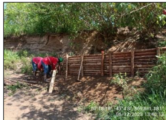
Paliçadas em execução.
