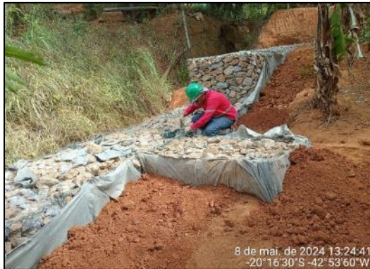
Gabião em andamento
