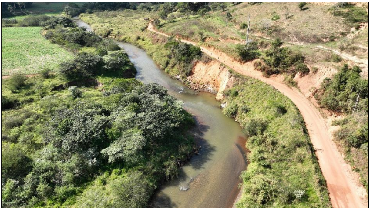
Erosão instalada na margem direita do rio Gualaxo do Norte, propriedade E031.
