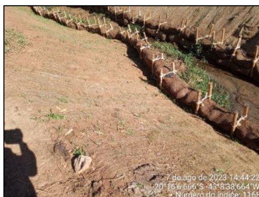
Aplicação de biorretentor de fibra de coco.
