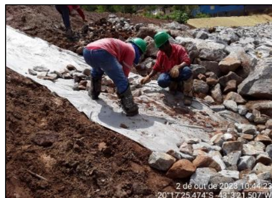
Canal de descida d'água enrocada
