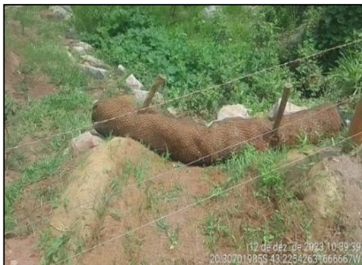
Retentor de sedimento instalado.
