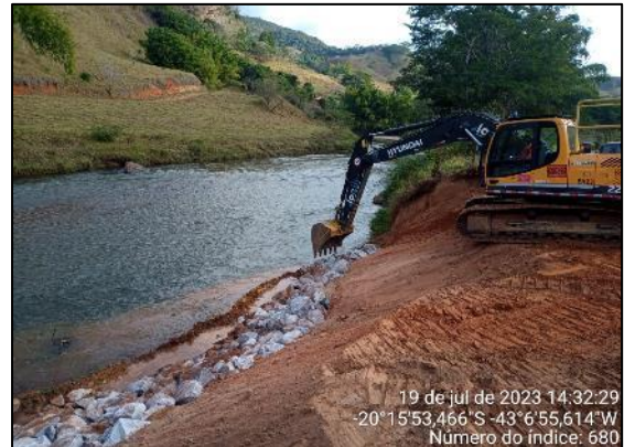
Enrocamento e reconformação do talude.
