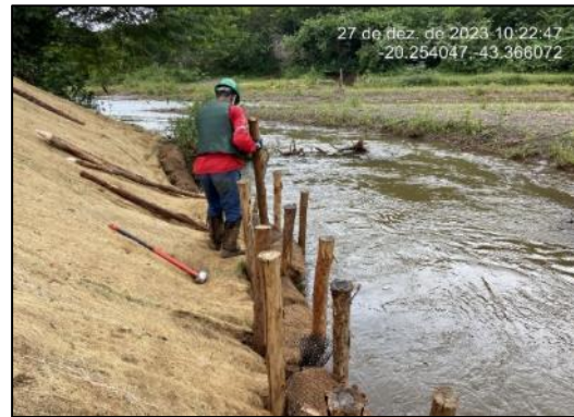
Instalação retentor de fibra de coco prensada
