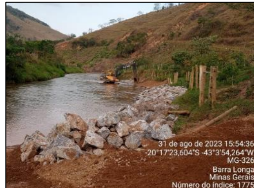
Enrocamento em andamento
