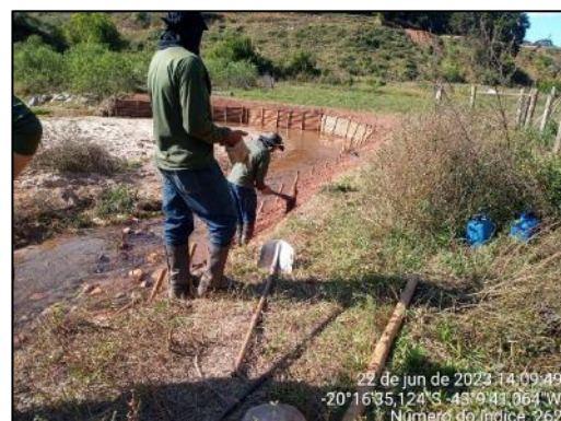
Instalação paliçadas e reconformação do talude.
