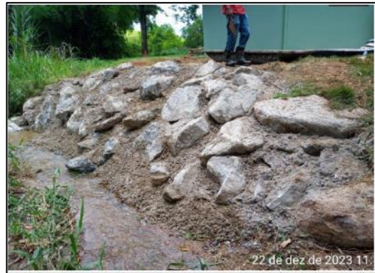
Contenção erosão c/ pedra argamassada.
