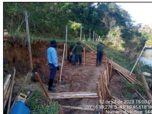
Paliçadas e regularização em execução.
