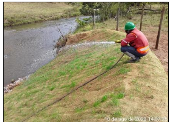
Reconformação e semente de mix de sementes finalizado.
