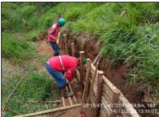
Execução da paliçada
