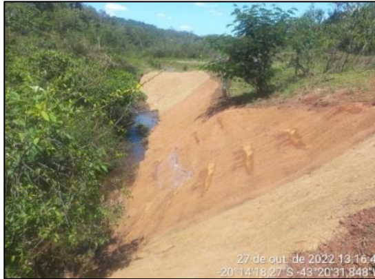
Retaludamento, adubação, semeio e cobertura com biomanta
