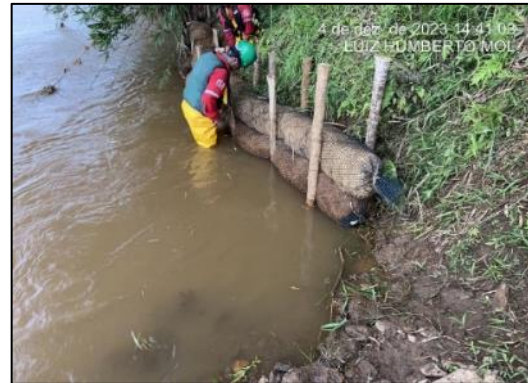
Instalação retentor de sedimentos de fibra de coco.
