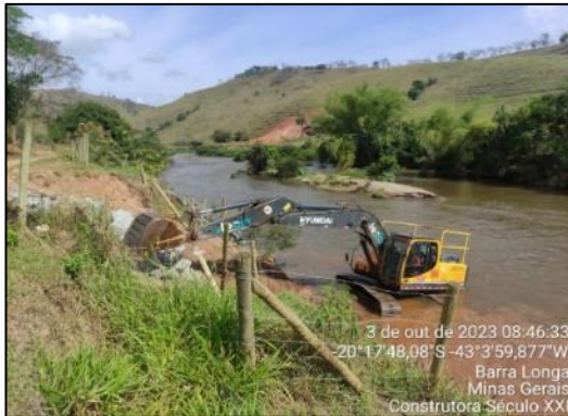
Execução do enrocamento.
