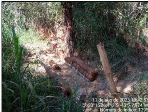
Bioretentores instalados.
