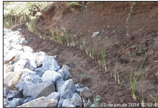
Barreira de capim vetiver.
