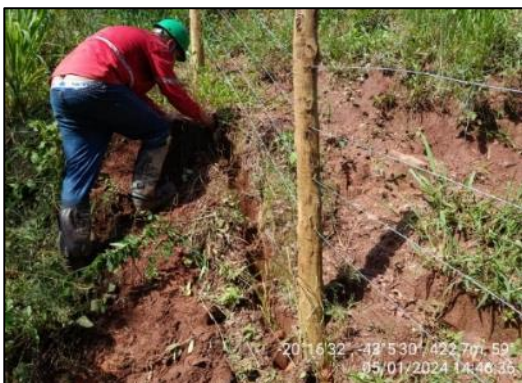
Barreira de capim Vetiver.
