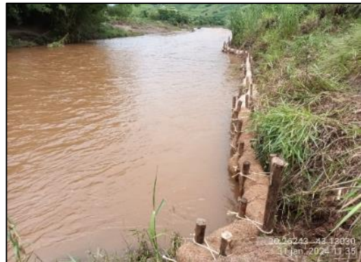
Instalação dos biorretentores concluído
