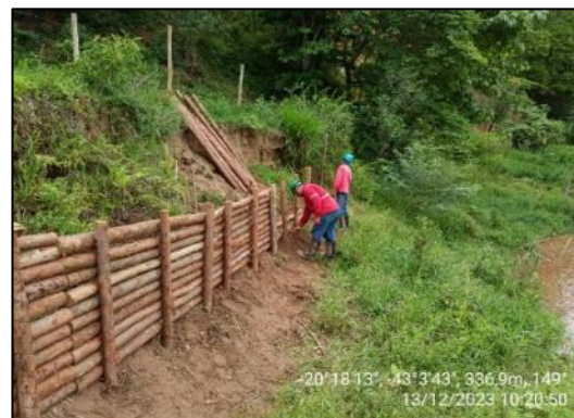
Paliçadas em execução.
