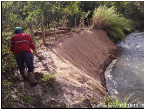
Aplicação de biomanta concluído.
