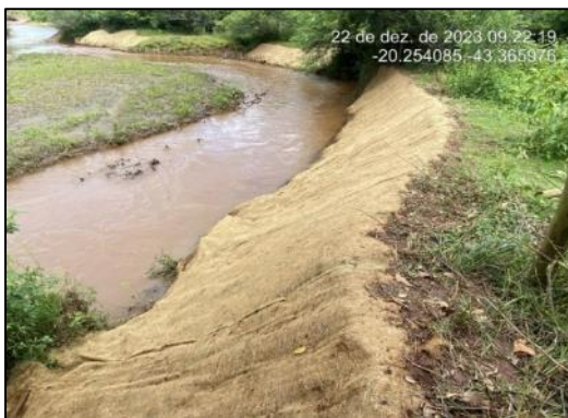
Aplicação de biomanta bidimensional
