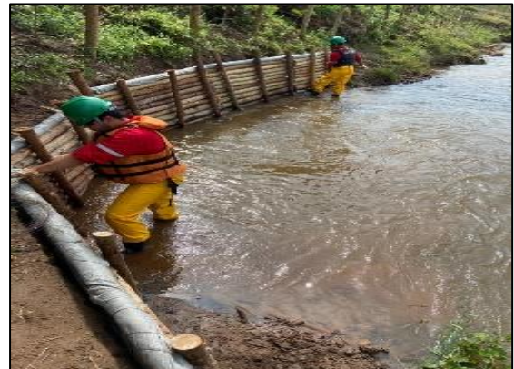
Instalação das paliçadas
