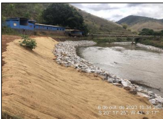
Bioamanta e enrocamento
