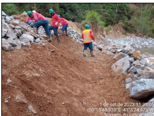
Regularização da descida d'água com pedra de mão.
