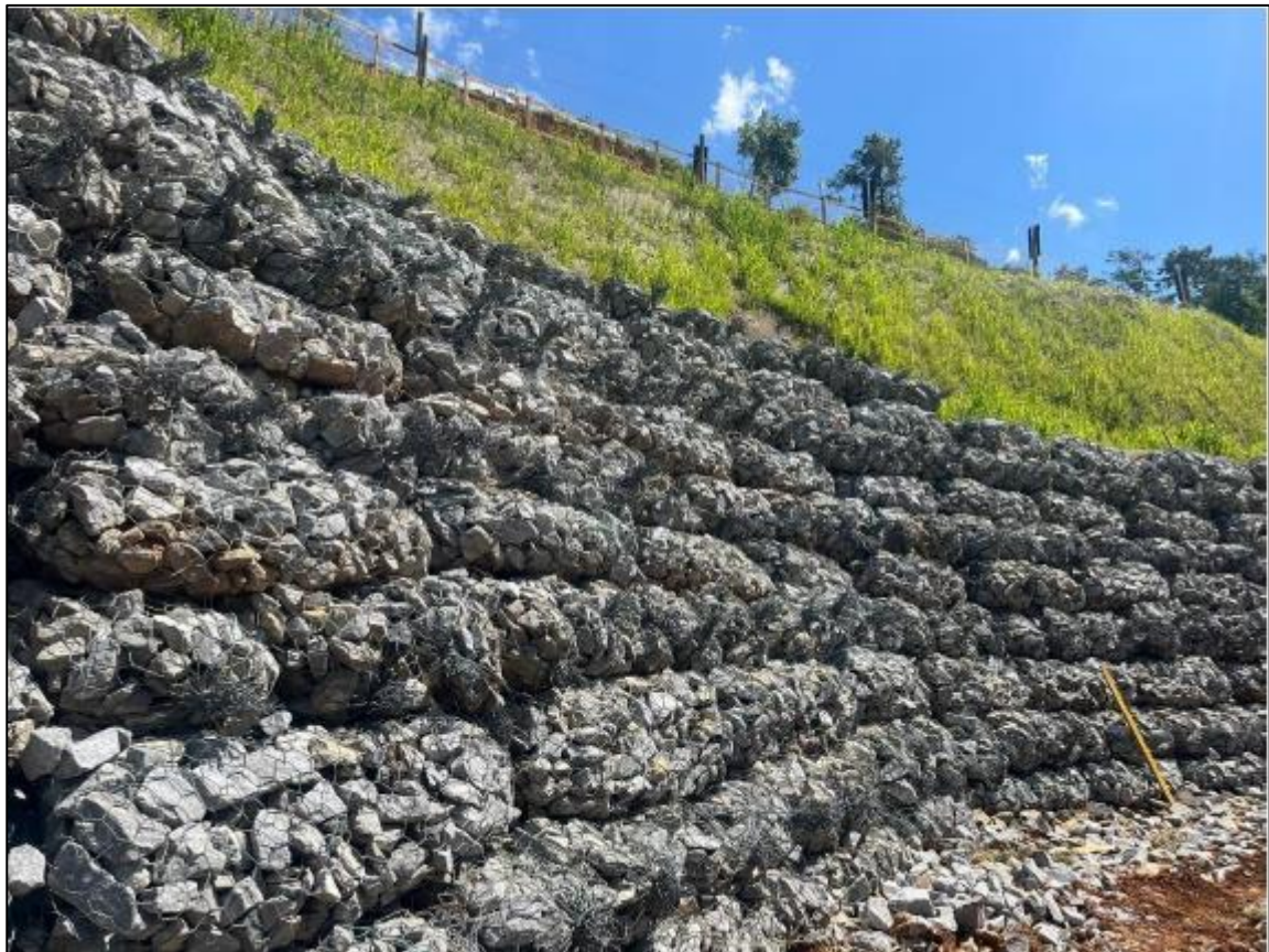
Execução do gabião em saco.
