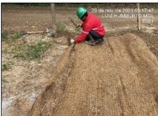
Proteção de talude com enrocamento
