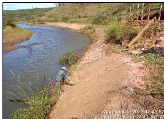
Instalação de biomanta bidimensional.
