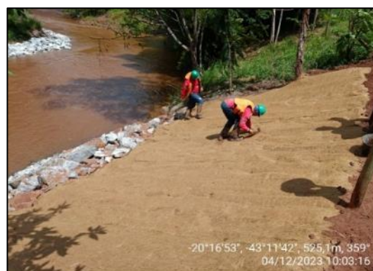
Instalação biomanta.
