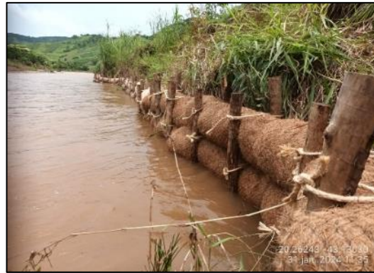
Instalação dos biorretentores
