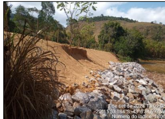
Enrocamento e biomanta
