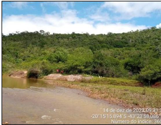
Proteção de talude com enrocamento
