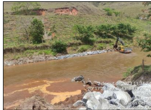
Enrocamento em execução.
