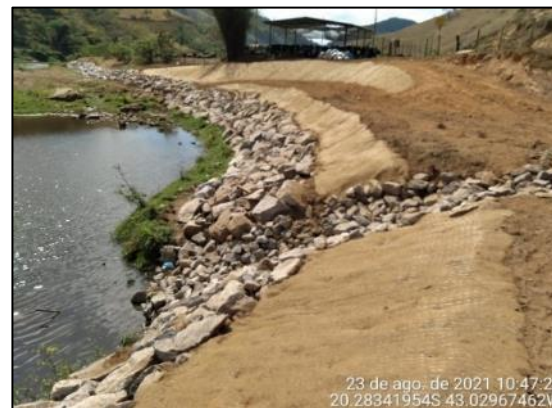
Retaludamento, enrocamento, instalação de cerca, adubação, semeio, cobertura com biomanta e descida d'água.
