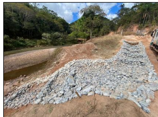
Regularização de erosão finalizada
