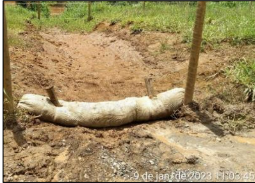
Biorretentor e manta bidimensional em andamento.
