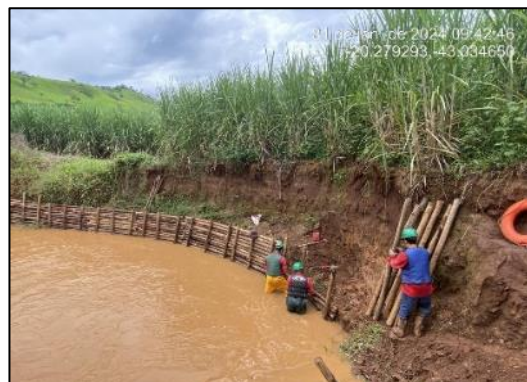
Paliçada em execução.
