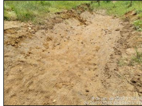
Biomanta bidimensional em andamento.
