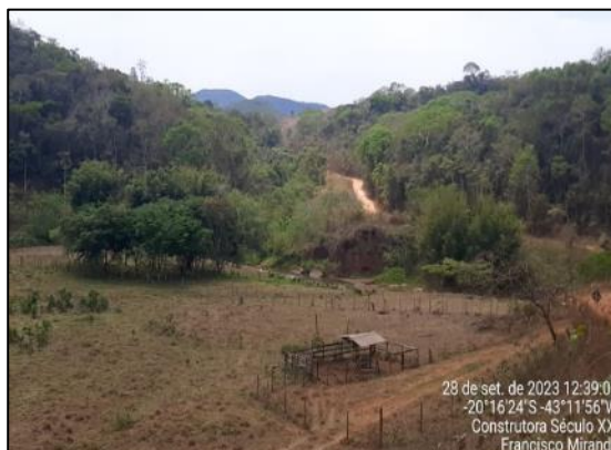
Local a ser executado enrocamento.
