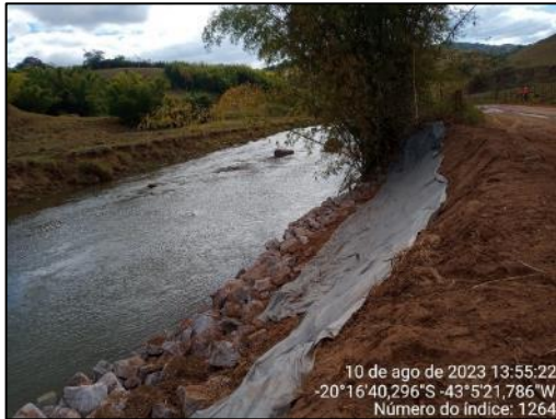
Enrocamento em execução.
