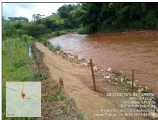
Reconformação do talude da calha do rio com adubação, semeio e cobertura com biomanta bidimensional de fibra de coco.
