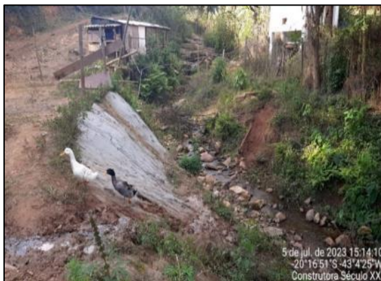
Local de intervenção.
