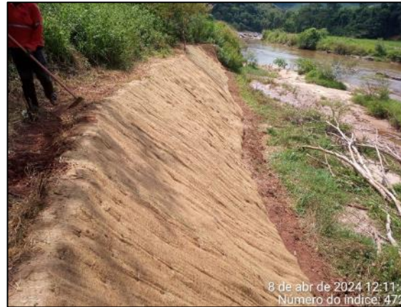
Instalação de biomanta em andamento
