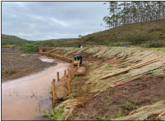
Instalação de bioretentor em andamento.
