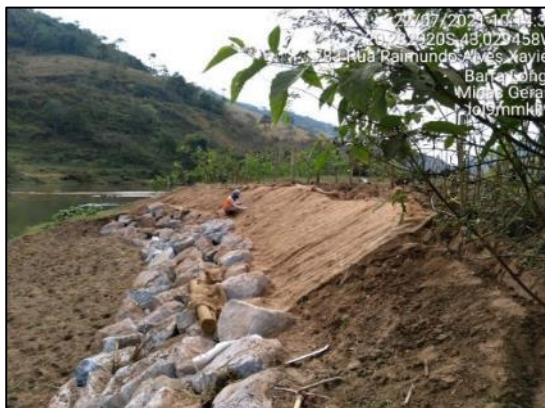
Retaludamento, enrocamento, instalação de cerca, adubação, semeio, cobertura com biomanta e descida d'água.
