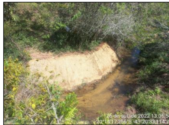
Retaludamento, adubação, semeio e cobertura com biomanta
