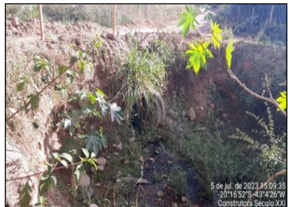
Local de intervenção.
