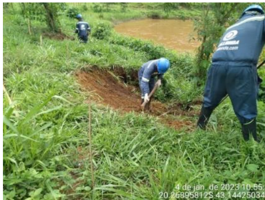
Manutenção de descida d'água em canaleta verde.
