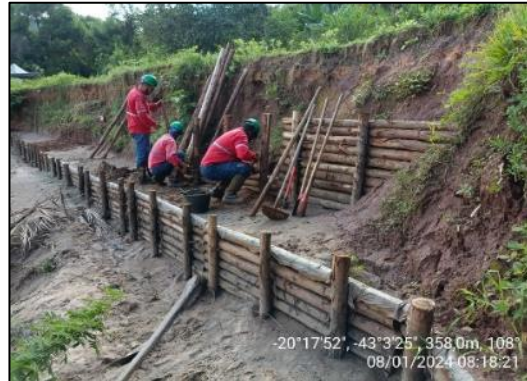
Paliçada em execução.
