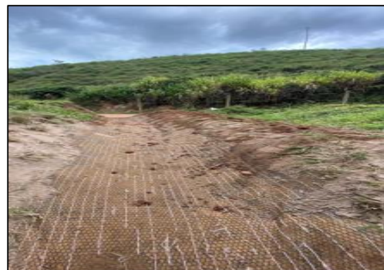
Implantação de descida d'água em canaleta verde
