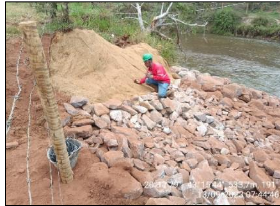
Instalação biomanta e descida d'água enrocada.
