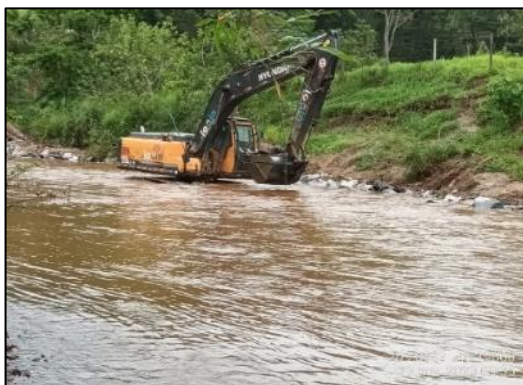
Execução enrocamento.
