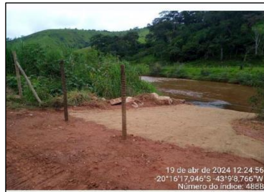
Proteção de talude com enrocamento
