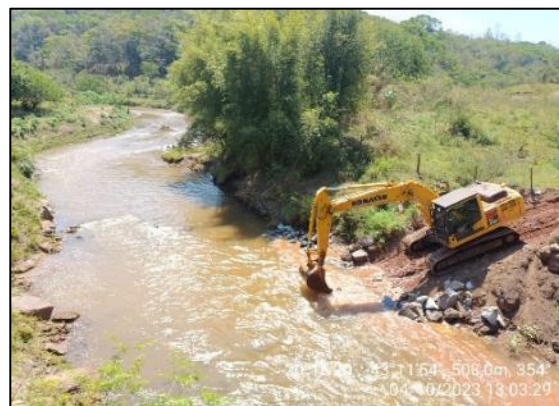
Enrocamento em execução.
