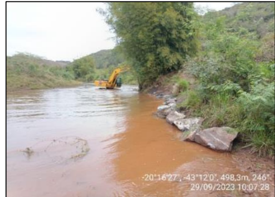
Enrocamento em execução.
