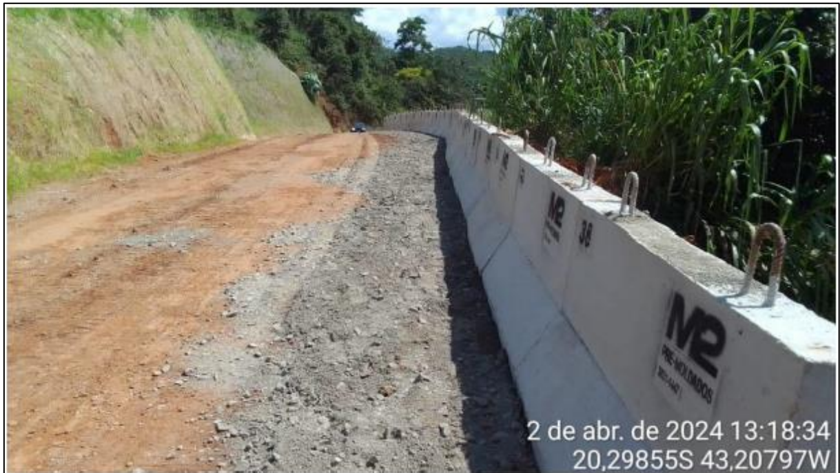
Recomposição do acesso da via não pavimentada e instalação das barreiras New Jersey.
