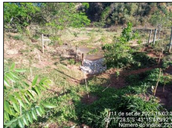
Descida d'água finalizada
