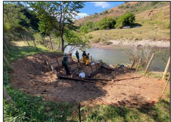
Paliçada em finalização.
