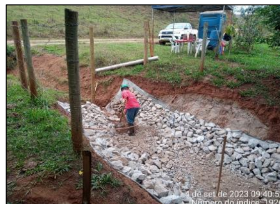
Regularização de descida d'água com pedra de mão.
