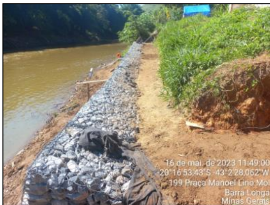
Implantação de muro de gabião
