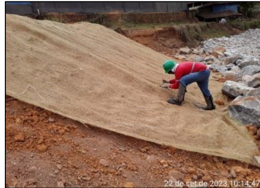
Instalação biomanta antierosiva
