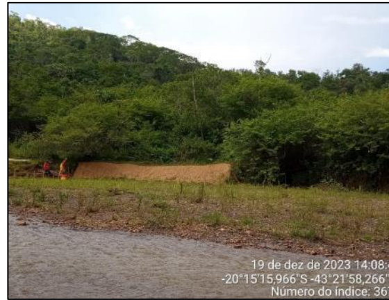
Proteção de talude com enrocamento
