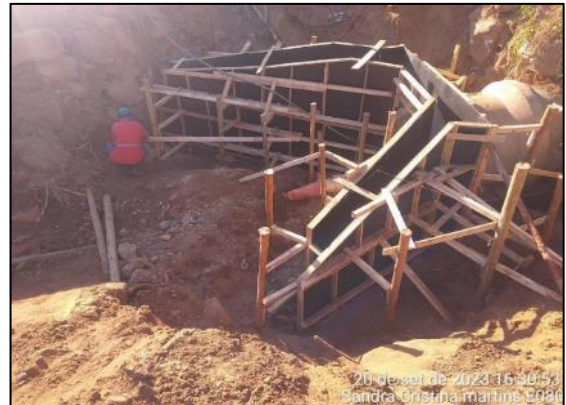
Concretagem da ala.
