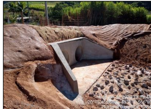
Bueiro finalizado com biomanta instalada.
