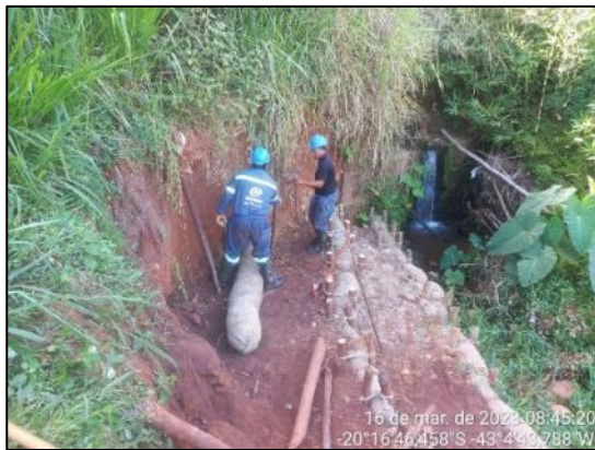
Instalação de paliçadas de retedores
