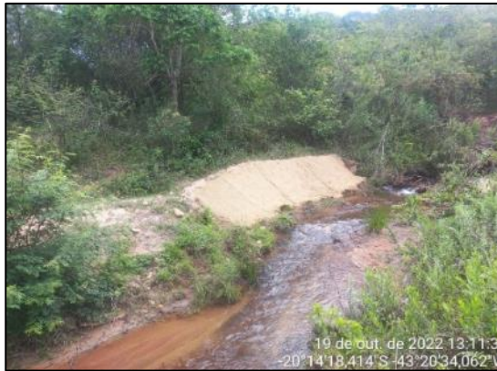
Retaludamento, adubação, semeio e cobertura com biomanta
