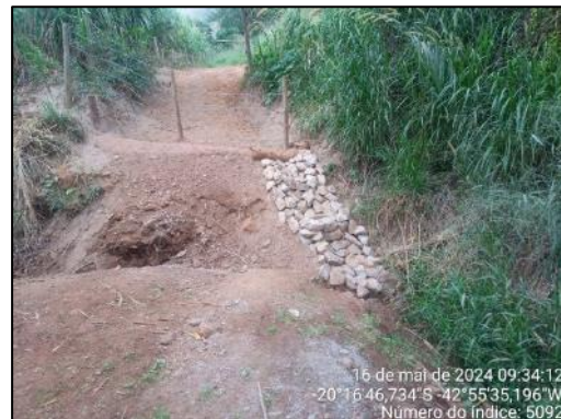
Descida d'água enrocada.
