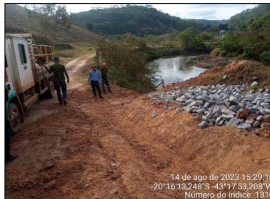
Regularização de erosão em andamento.
