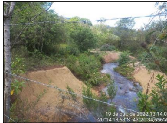
Retaludamento, adubação, semeio e cobertura com biomanta
