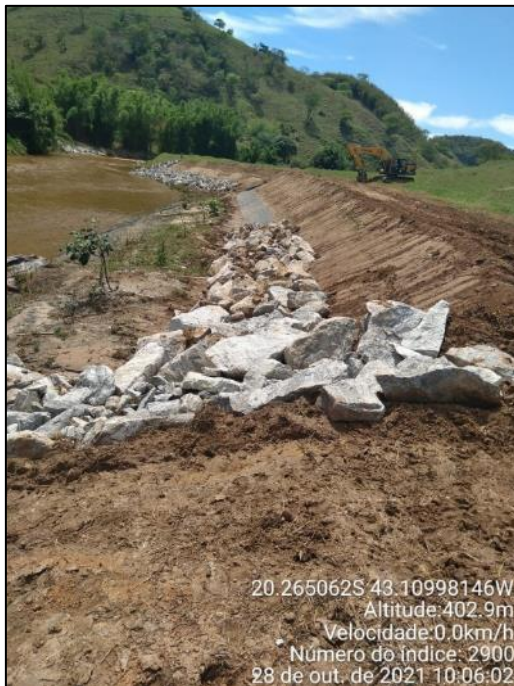
Retaludamento e enrocamento.
