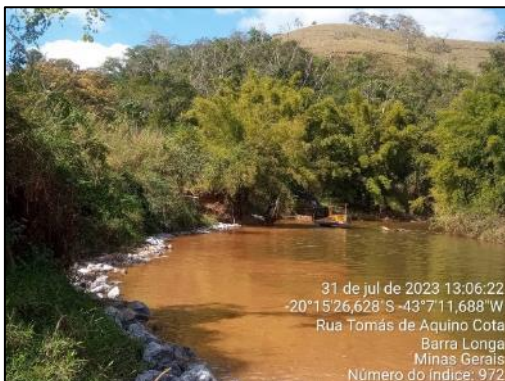
Enrocamento em andamento
