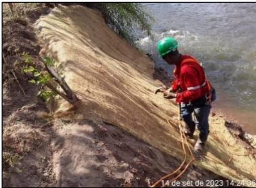
Aplicação de biomanta na face do talude
