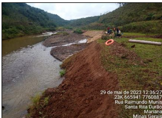
Regularização manual do talude.
