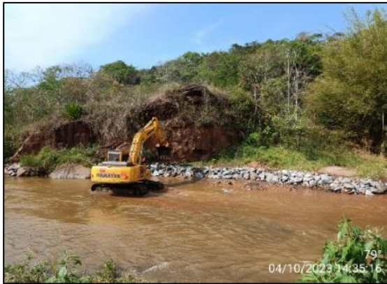
Enrocamento em execução.
