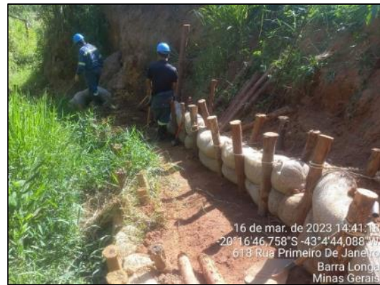
Instalação de paliçadas de retedores
