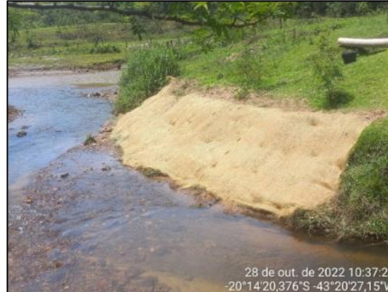
Retaludamento, adubação, semeio e cobertura com biomanta
