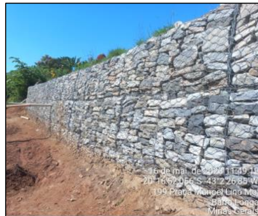
Implantação de muro de gabião
