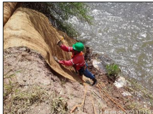
Aplicação de biomanta em andamento.
