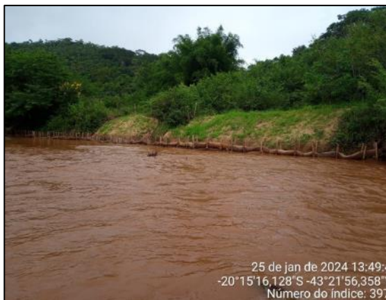
Proteção de talude com enrocamento
