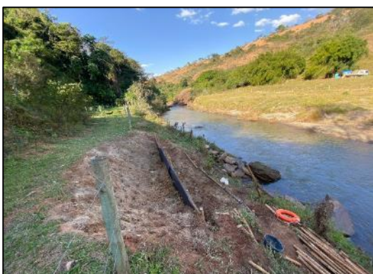
Paliçada em execução
