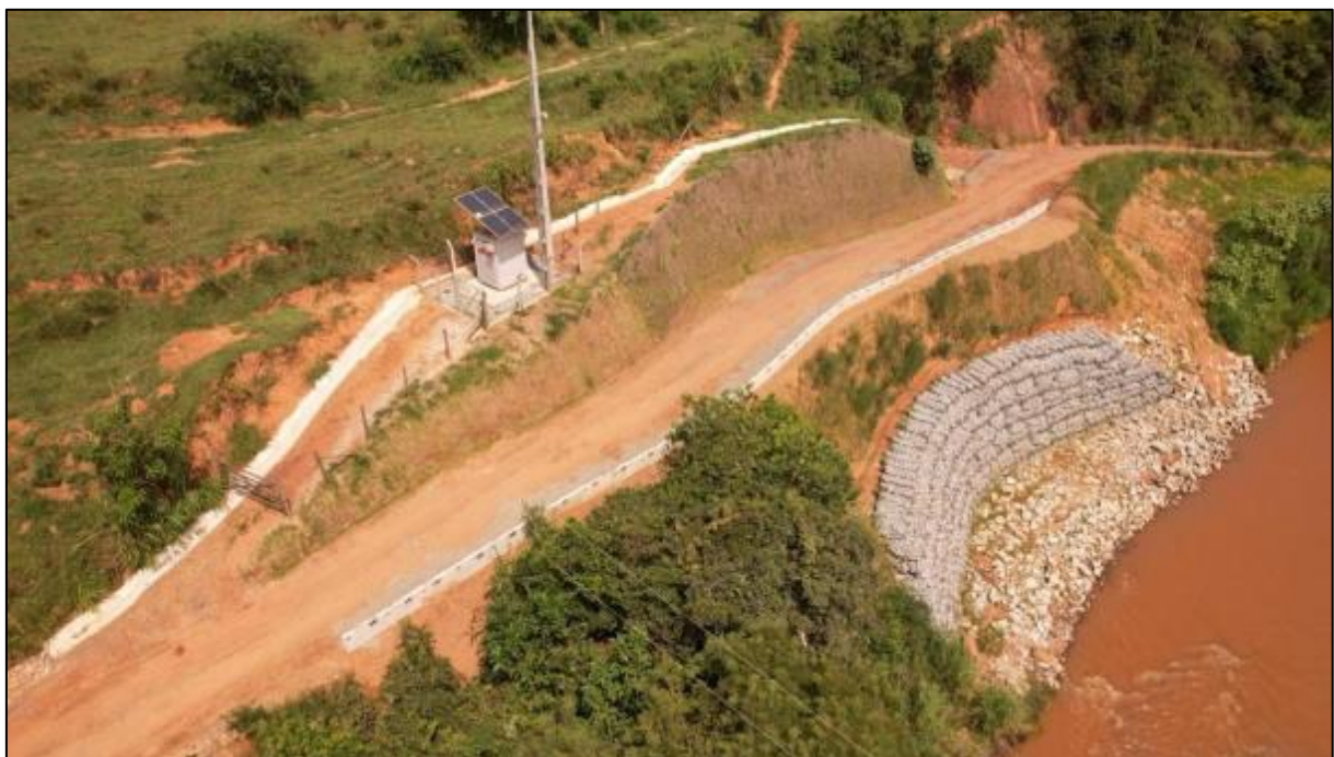
Vista aérea da obra concluída.
