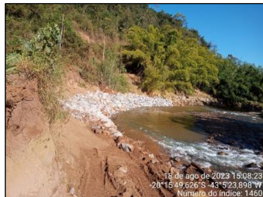
Enrocamento em andamento
