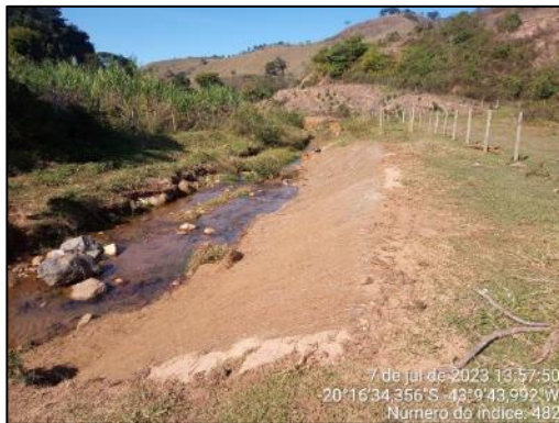
Instalação biomanta e semeio do mix de sementes
