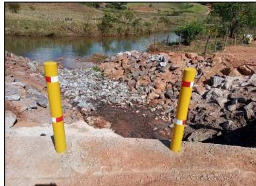
Bueiro finalizado com dissipador de energia.
