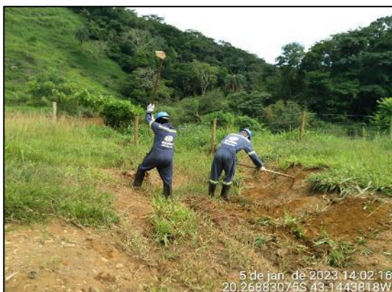
Implantação de descida d'água em canaleta verde
