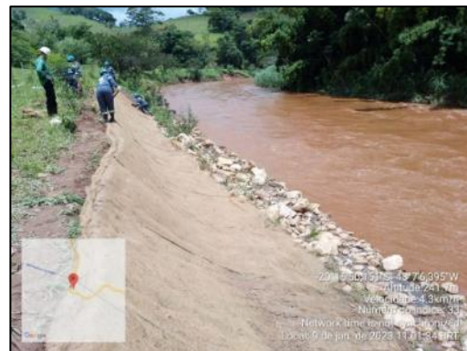
Reconformação do talude da calha do rio com adubação, semeio e cobertura com biomanta bidimensional de fibra de coco.
