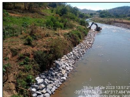
Enrocamento em execução.
