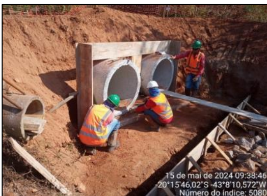
Bueiro com ala concretada em execução
