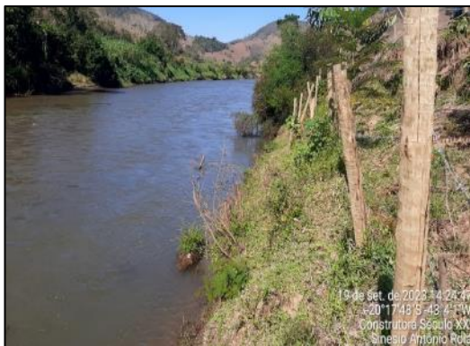
Local de instalação.
