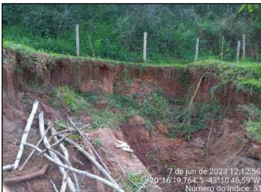
Local de intervenção.
