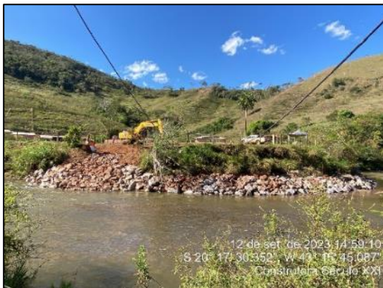
Enrocamento em andamento.
