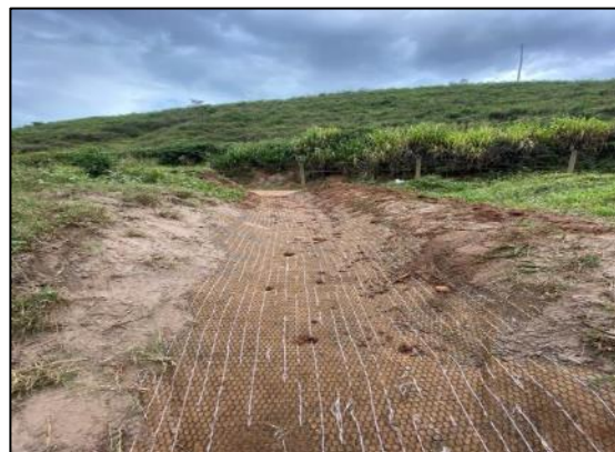
Finalizado com instalação de biomanta tridimensional.
