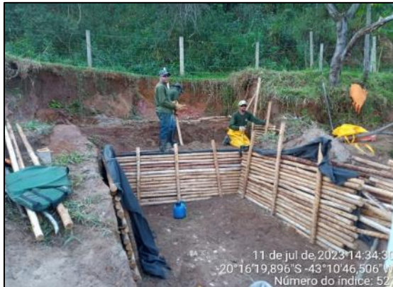
Paliçadas em execução.
