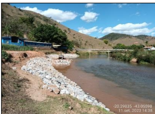
Enrocamento em andamento.
