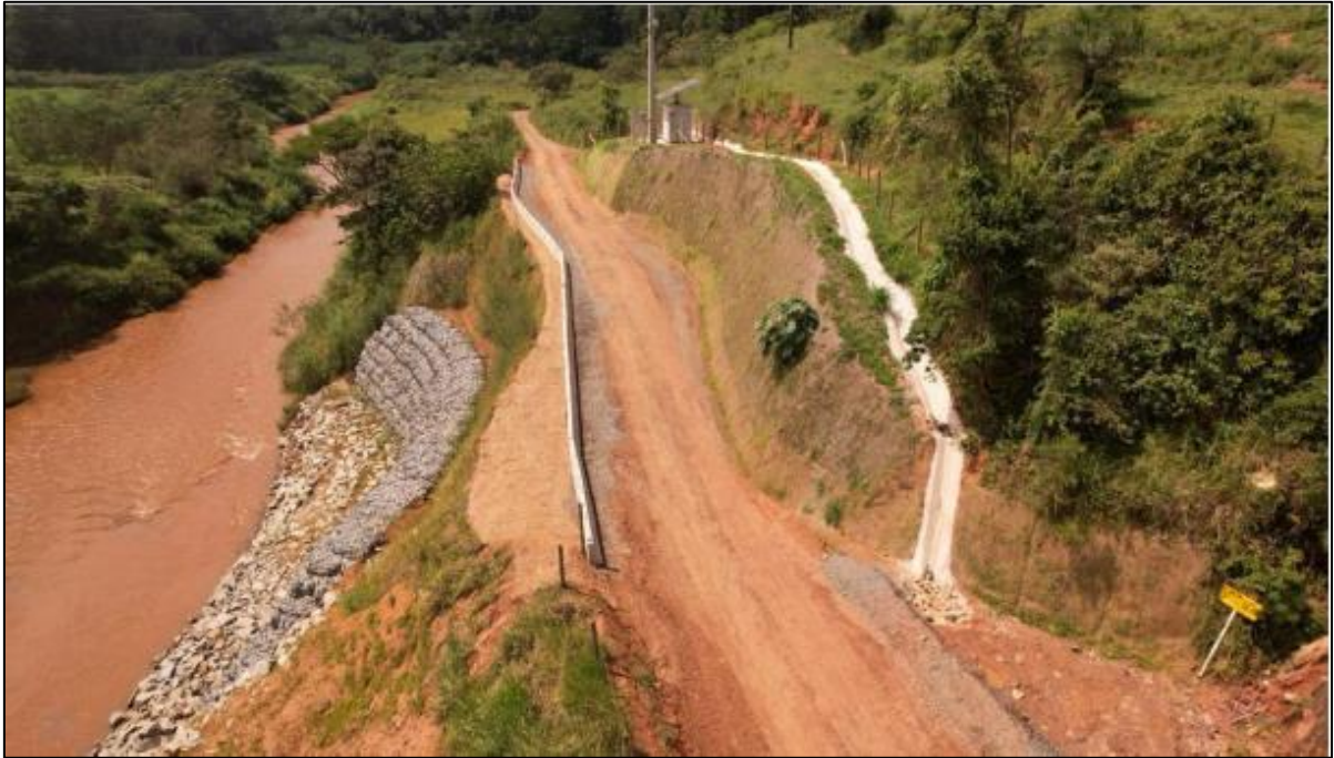
Vista aérea da obra concluída
