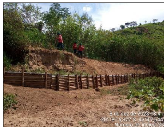
Paliçadas e reconformação talude em andamento
