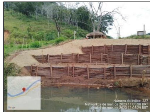
Instalação de paliçadas
