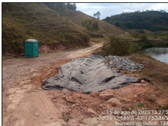
Regularização de erosão em andamento.
