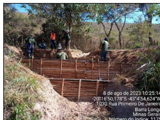
Instalação de paliçadas.
