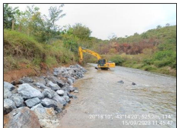
Enrocamento em execução.
