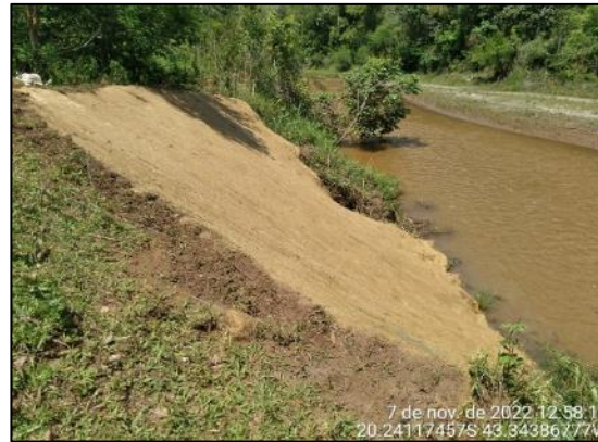
Aplicação biomanta bidimensional.
