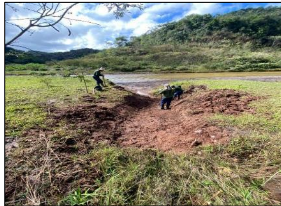
Regularização da descida d'água em andamento.
