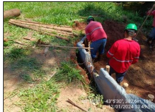
Paliçadas em execução.
