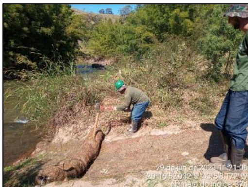
Instalação de biomanta e retentor.
