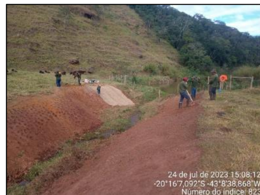
Andamento da aplicação de biomanta.
