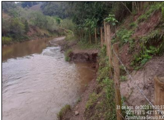
Local de intervenção.
