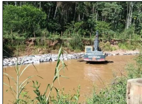
Enrocamento em execução.
