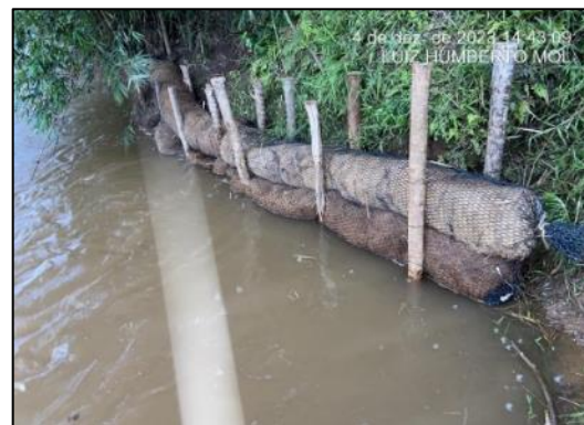
Retentor de sedimentos de fibra de coco finalizado.
