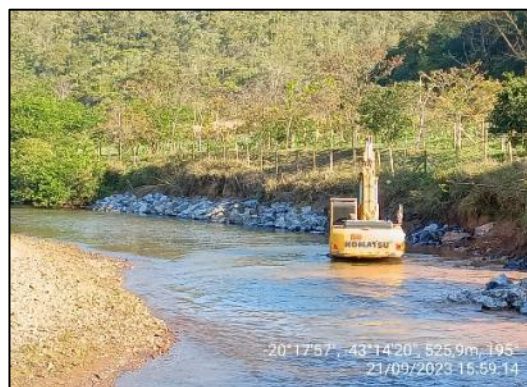
Enrocamento em andamento.
