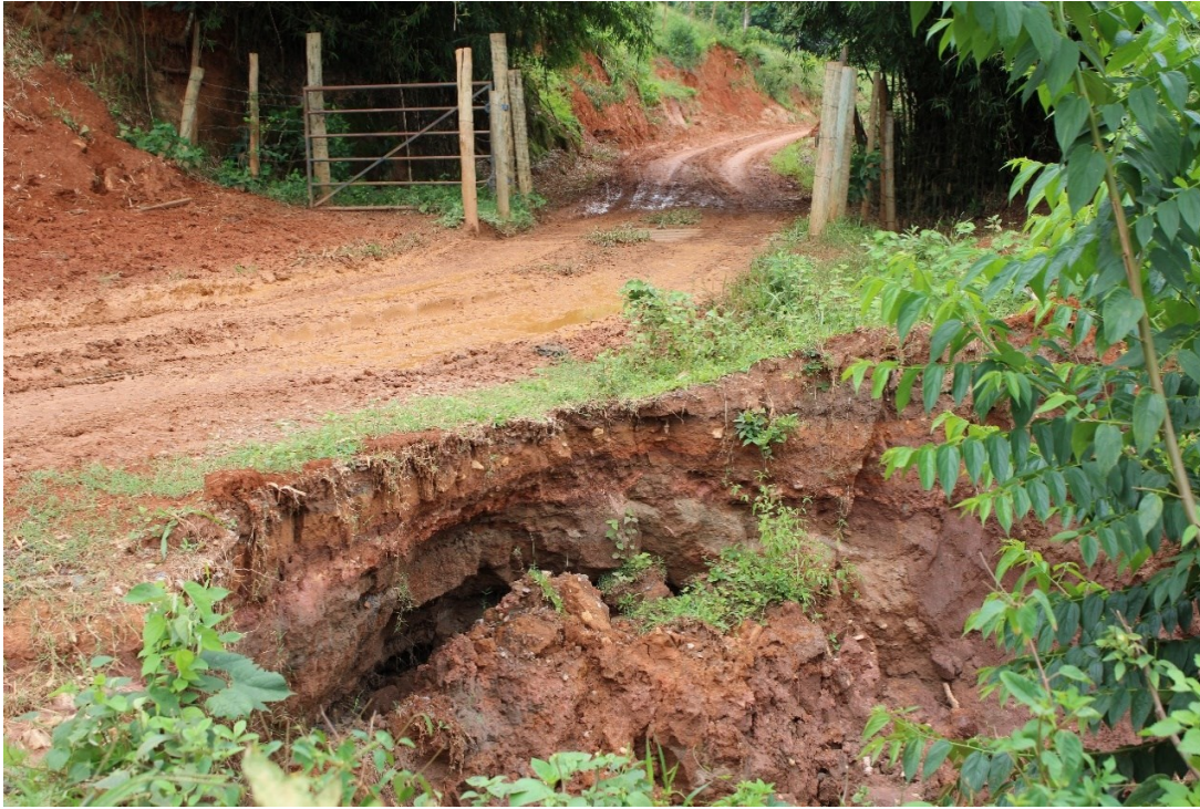
Margens do rio Carmo (enrocamento)
