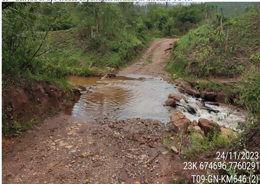
Figura 10 – Barreira do tipo estrada de passagem molhada no tributário TG-16.
