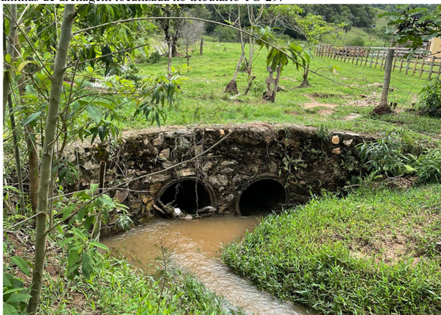
Figura 13 – Manilhas de drenagem localizada no tributário TG-29.
