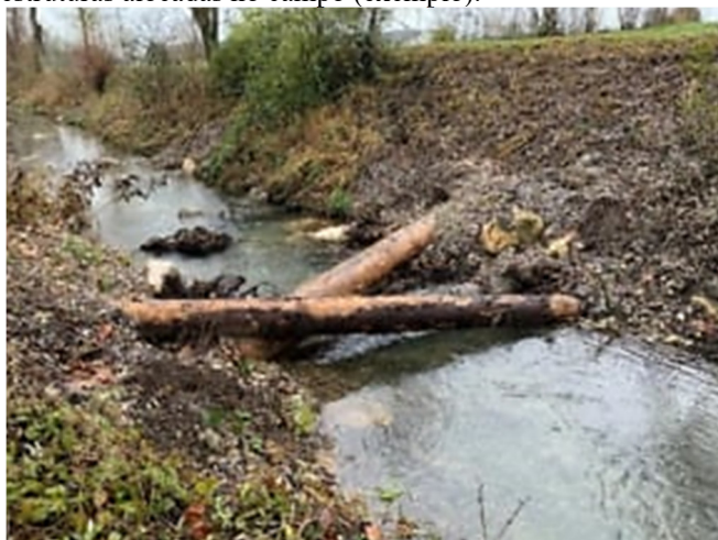
Figura 14 - TTX com as estruturas alocadas no campo (exemplo).
