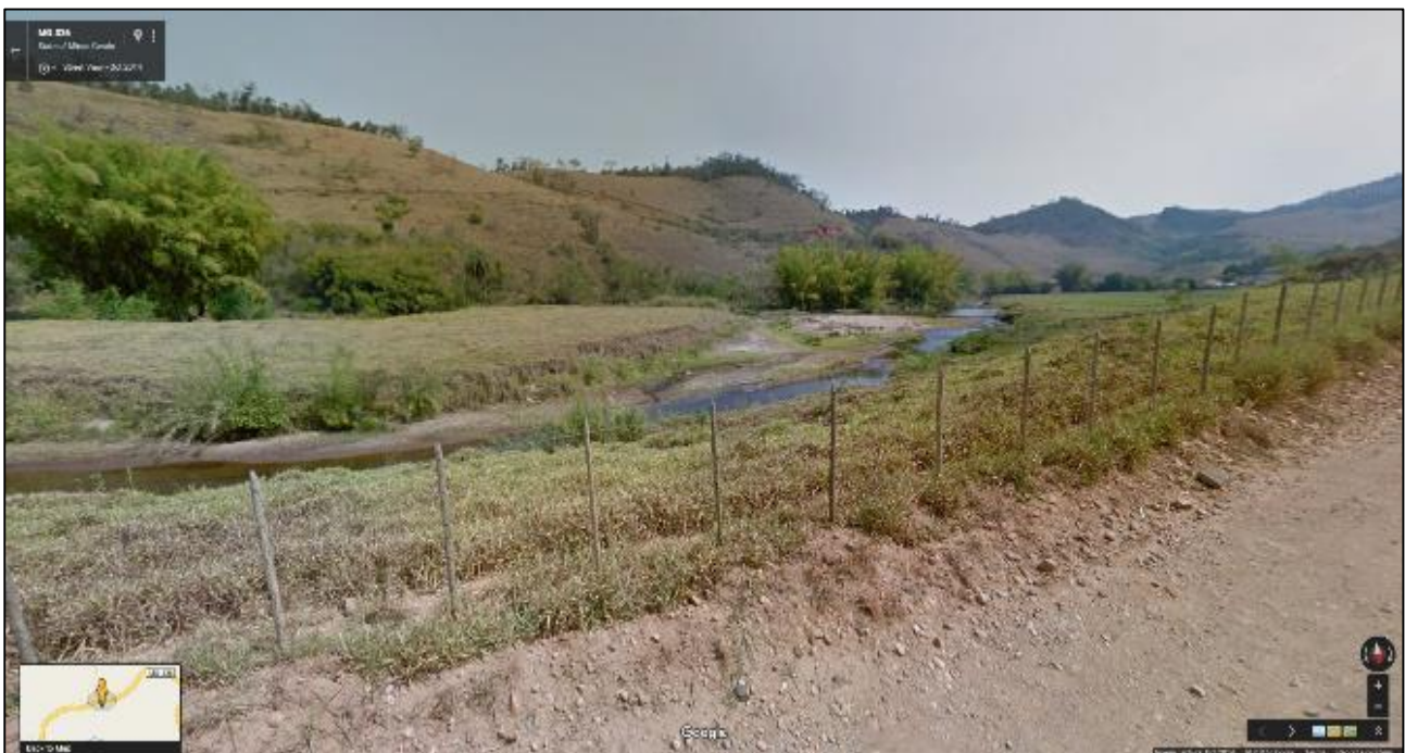
Figura 3.5.6: Condições pré-rompimento no ponto SG_15, vista para montante, a partir da margem esquerda.
