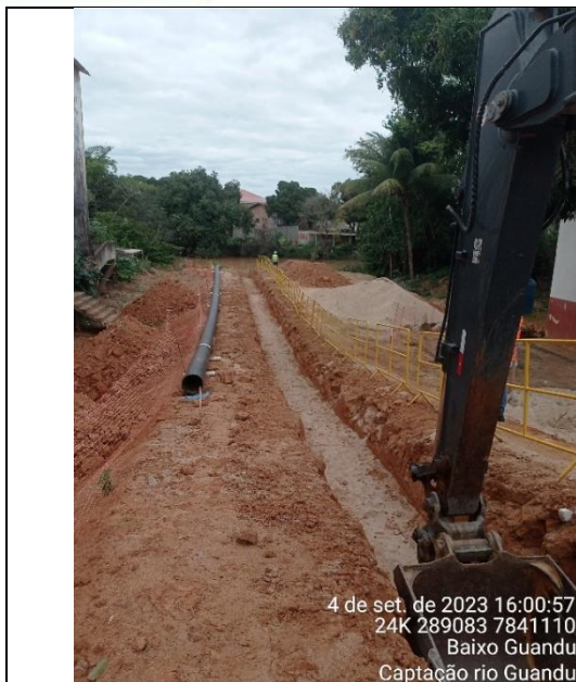
Foto 06: Execução da captação e adução de água no rio Guandu (Set/2023).
