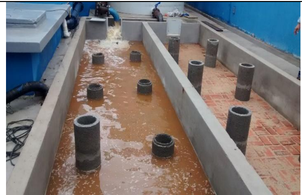
Foto 05: Construção de Unidade de Tratamento de Resíduo - UTR na ETA de Regência, Linhares/ES (Nov/2017).
