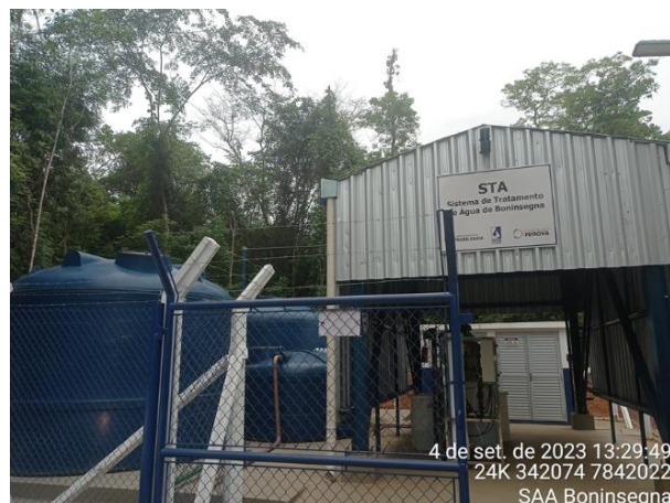
Foto 07: Implantação do Sistema de Tratamento de Água de Boninsegna, Marilândia/ES (Set/2023).
