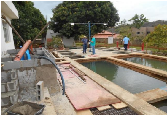
Foto 04: Reforma de unidades da ETA IV, Colatina/ES.
