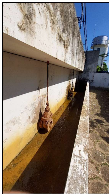
Figura 52 – Descarga dos Filtros – Bateria Sul a Esquerda e Bateria Norte a Direita
