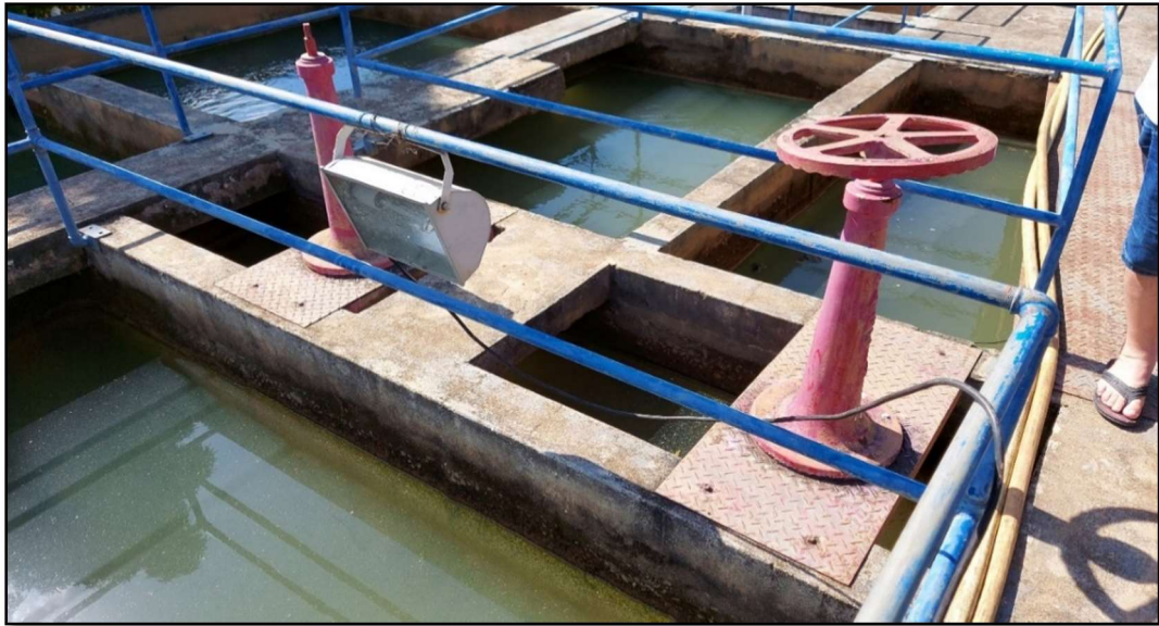
Figura 39 – Câmaras Antigas do Floculador ao Fundo
