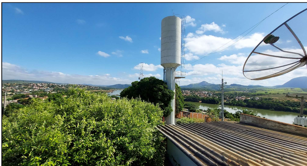
Figura 83 – Reservatório Elevado – Vista Geral
