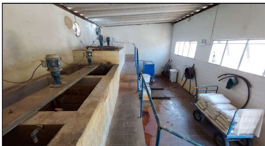
Figura 53 – Vista Interna da Casa de Química
