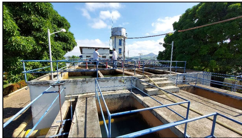
Figura 48 – Vista Superior dos Filtros Novos – Bateria Sul a Esquerda
