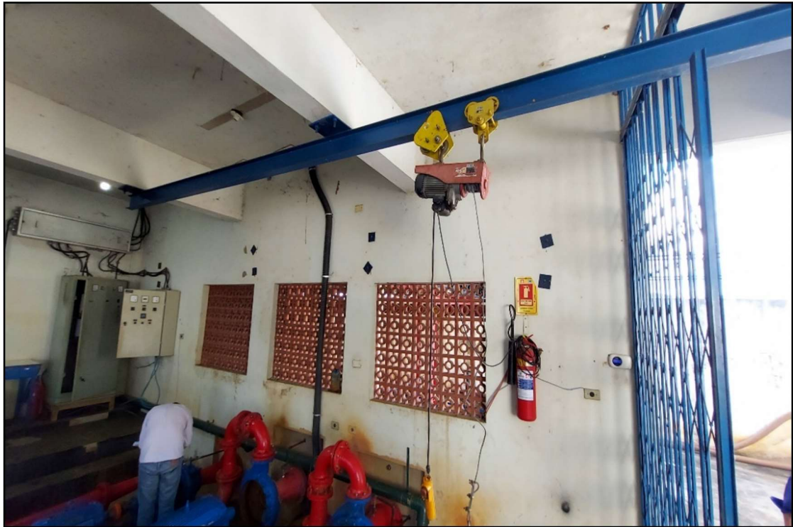
Figura 18 – Casa de bombas – Monóvia
