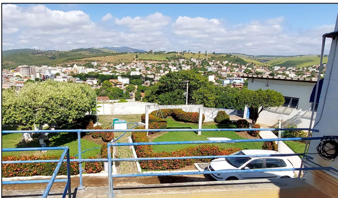
Figura 77 – Vista do Reservatório Enterrado
