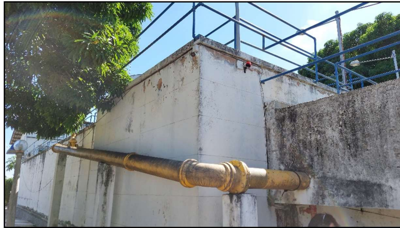
Figura 49 – Detalhe da Tubulação de Água Decantada
