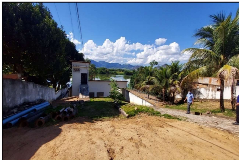
Figura 31 – Vista Frontal da Área da Captação
