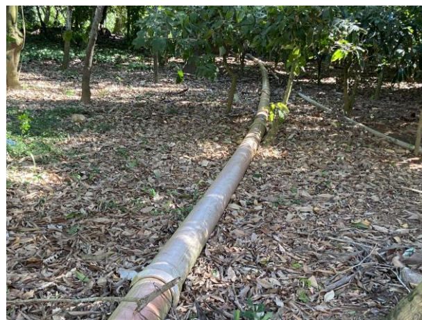
Figura 4 - Linha de descarga de lodo na área 1 Fonte: HIDROBR, 2024
