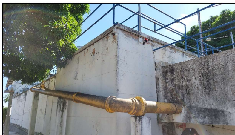
Figura 49 – Detalhe da Tubulação de Água Decantada
