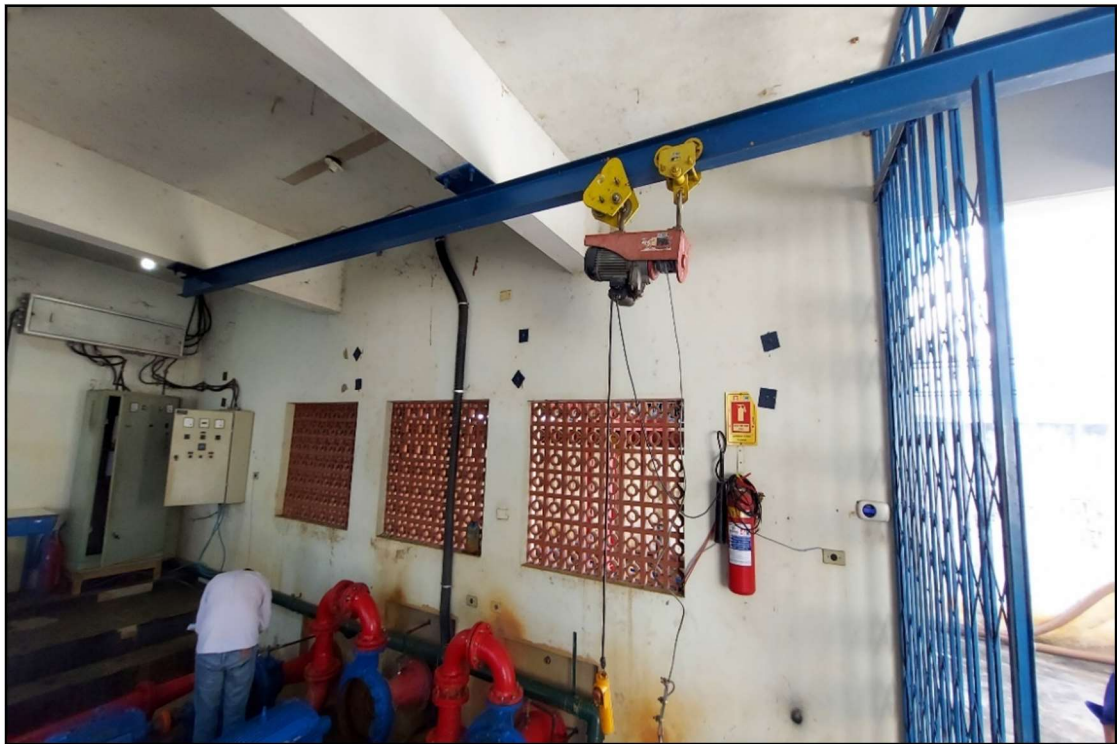
Figura 18 – Casa de bombas – Monóvia
