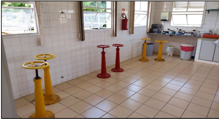
Figura 47 – Volantes de Operação dos Filtros Antigos
