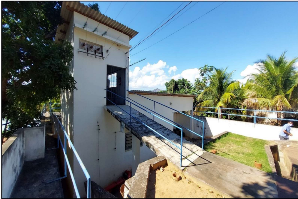
Figura 27 – Rampa de Acesso da Subestação Abrigada
