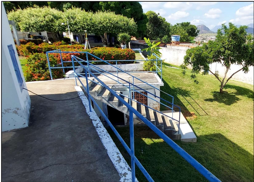
Figura 78 – Vista Exterior da Elevatória de Água Tratada
