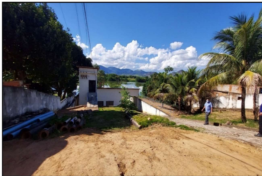
Figura 31 – Vista Frontal da Área da Captação
