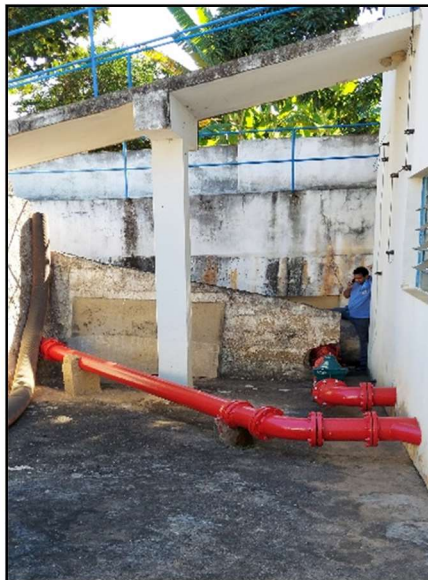
Figura 23 – Detalhe das Duas Adutoras de 200 mm em Paralelo
