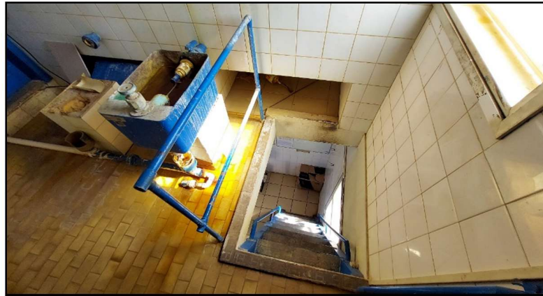
Figura 60 – Sala do Tanque de Nível Constante do Sulfato
