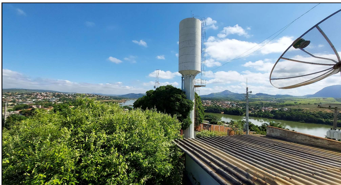
Figura 83 – Reservatório Elevado – Vista Geral
