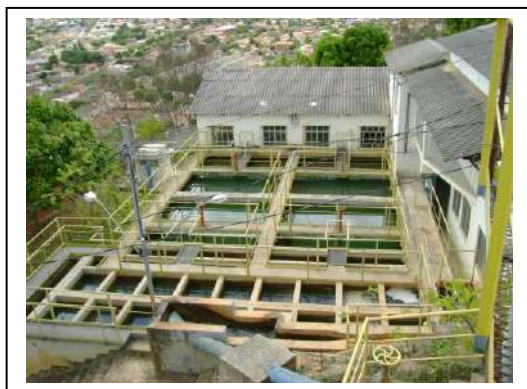
Foto 2.1 – Vista superior da ETA em concreto armado, construída originalmente na década de quarenta e melhorada ao longo dos anos. Opera continuamente ao longo dos anos.
