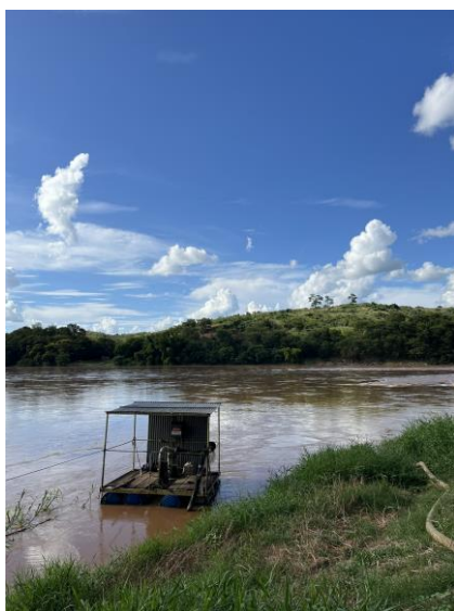
Figura 3 - Balsa flutuante para captação Fonte: HIDROBR (2024)
