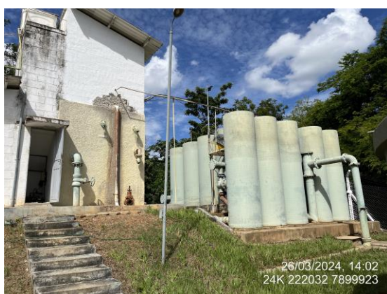
Figura 7 - Unidades de filtração Fonte: HIDROBR (2024)
