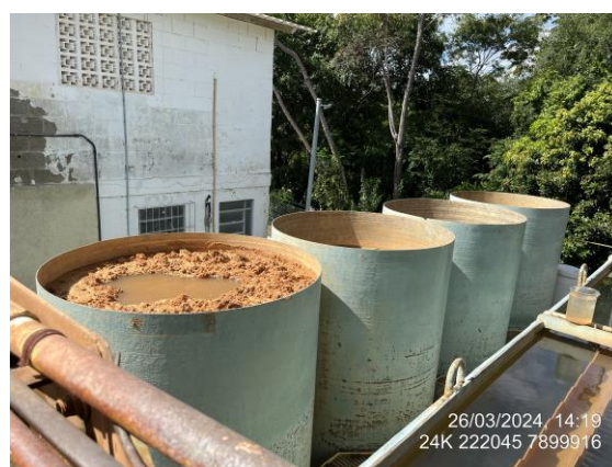
Figura 9 – Floculadores Fonte: HIDROBR (2024)
