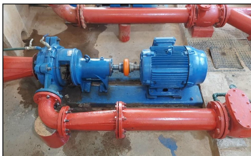
Figura 21 – Detalhe do Conjunto de 40 cv
