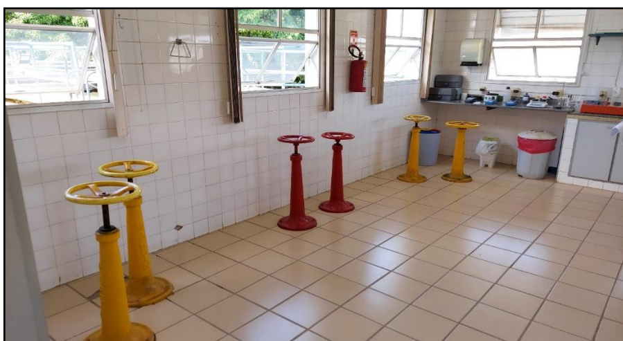
Figura 47 – Volantes de Operação dos Filtros Antigos
