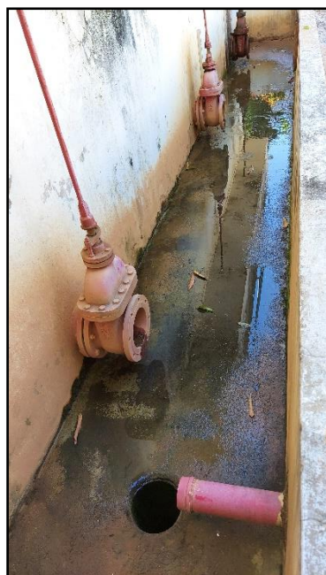
Figura 52 – Descarga dos Filtros – Bateria Sul a Esquerda e Bateria Norte a Direita
