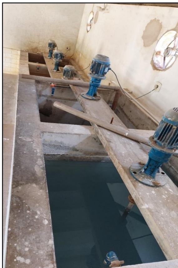
Figura 58 – Tanques de Preparo de Flúor a Frente e de Sulfato no Fundo – Painel Elétrico na Direita
