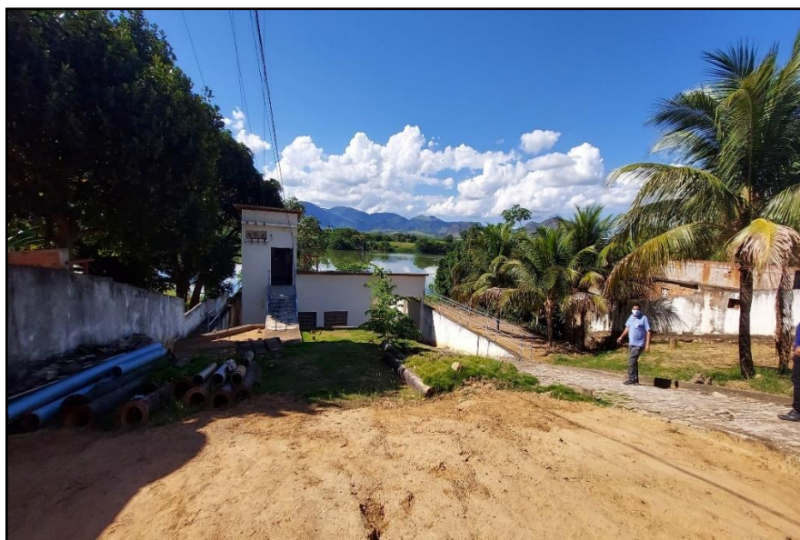
Figura 31 – Vista Frontal da Área da Captação
