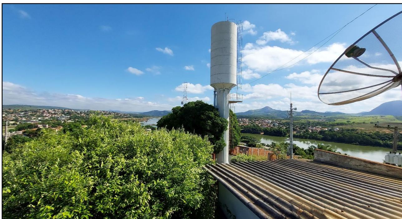
Figura 83 – Reservatório Elevado – Vista Geral
