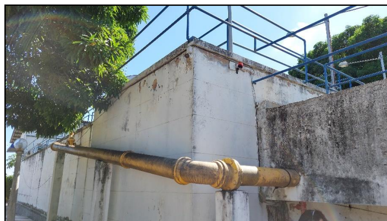
Figura 49 – Detalhe da Tubulação de Água Decantada
