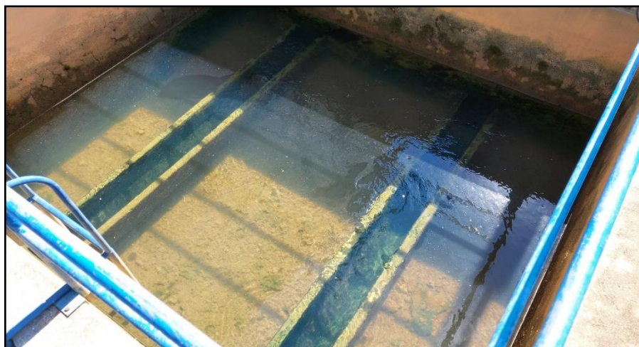
Figura 45 – Detalhe de um Filtro Antigo
