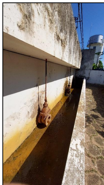
Figura 52 – Descarga dos Filtros – Bateria Sul a Esquerda e Bateria Norte a Direita
