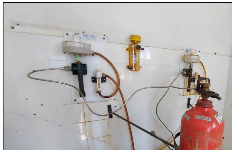
Figura 65 – Detalhe do Barrilete do Ejetor de Cloro e seus Ac
