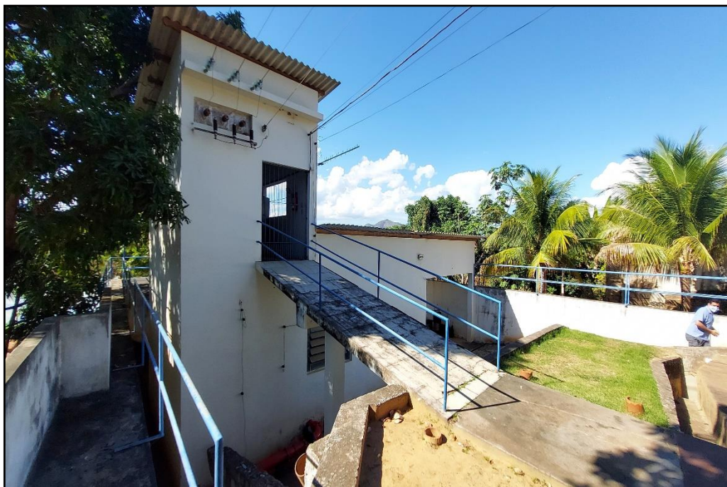
Figura 27 – Rampa de Acesso da Subestação Abrigada
