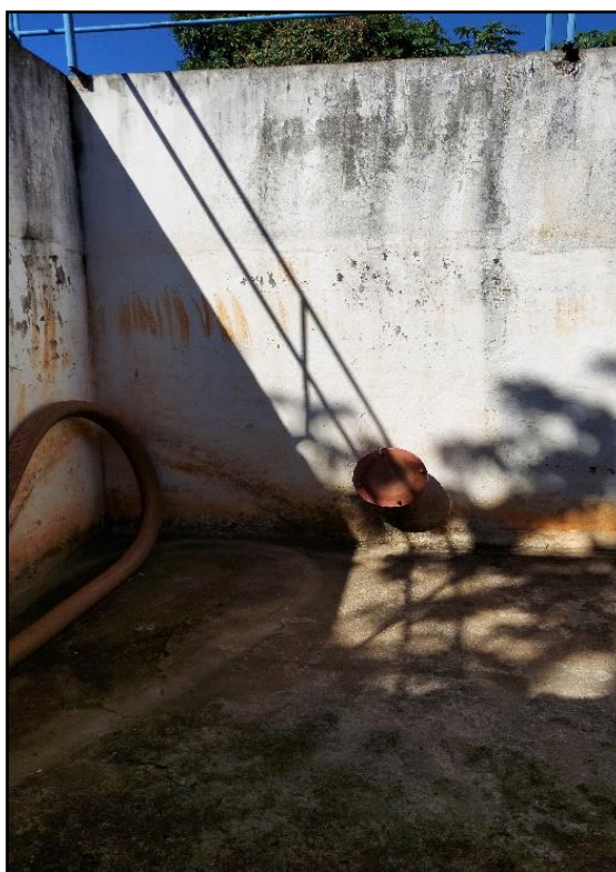
Figura 26 – Detalhe do Muro de Contenção de Enchente
