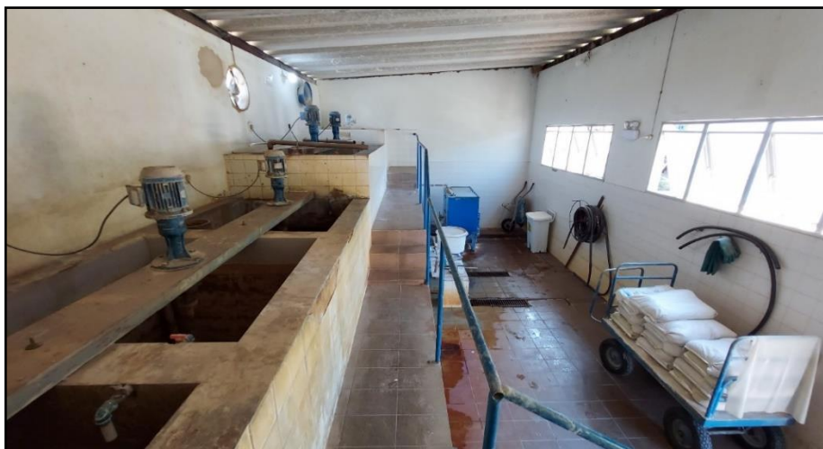
Figura 53 – Vista Interna da Casa de Química
