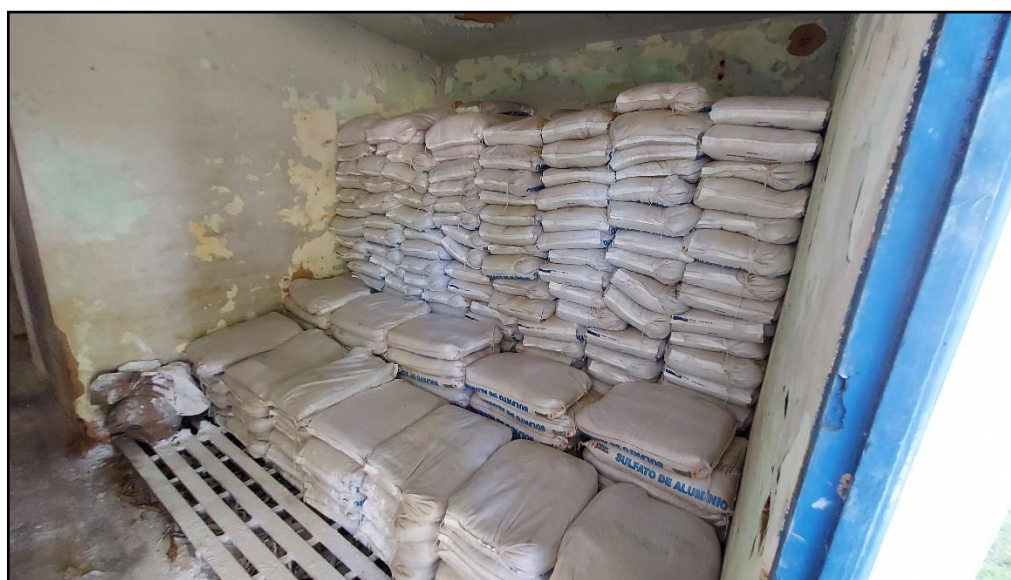
Figura 69 – Armazenagem de Sulfato
