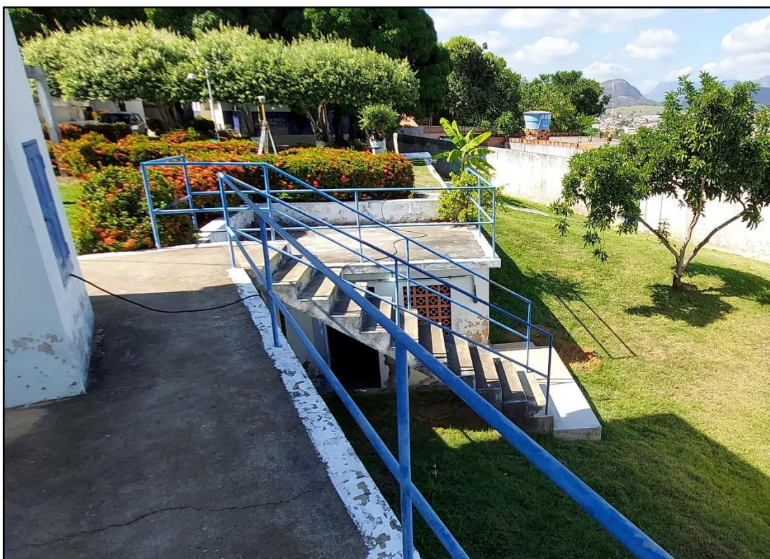
Figura 78 – Vista Exterior da Elevatória de Água Tratada
