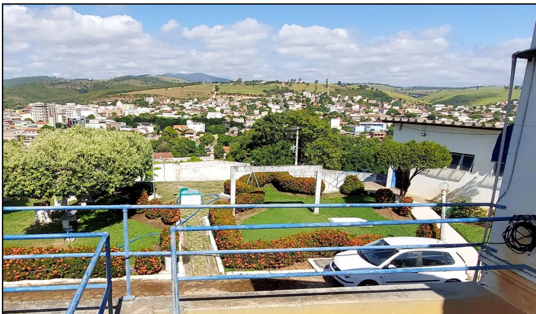
Figura 77 – Vista do Reservatório Enterrado
