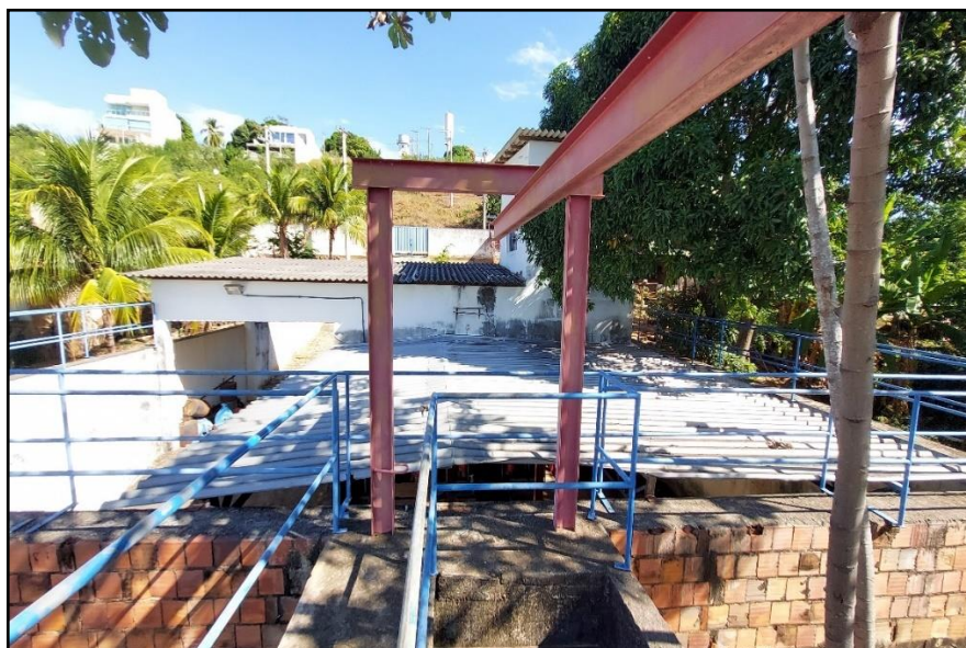
Figura 32 – Vista Posterior da Área da Captação
