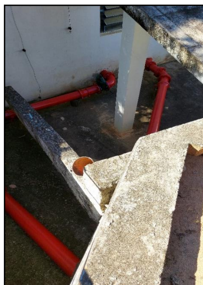
Figura 23 – Detalhe das Duas Adutoras de 200 mm em Paralelo
