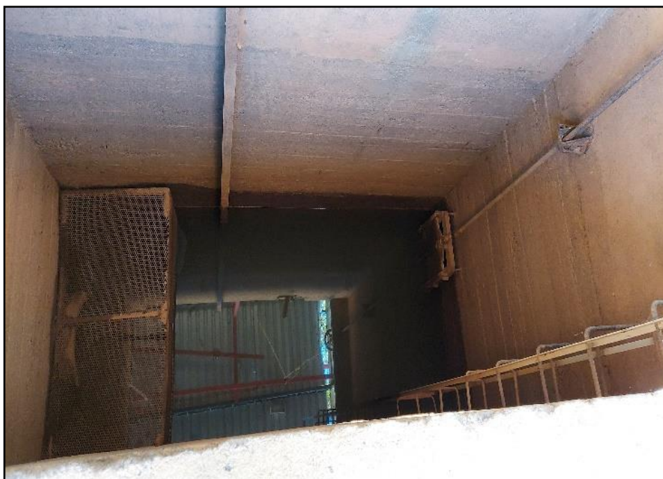
Figura 13 – Interior da Caixa de Captação do Nível Mais Raso
