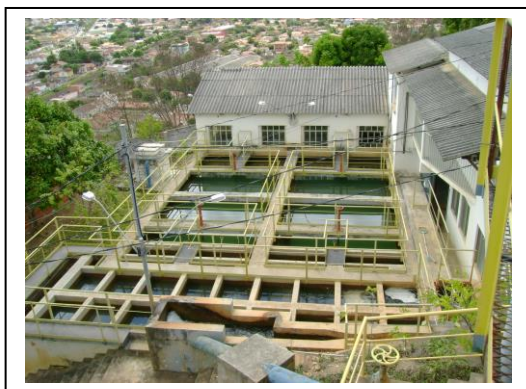
Foto 2.1.5 – Vista superior da ETA em concreto armado, construída originalmente na década de quarenta e melhorada ao longo dos anos. Opera continuamente ao longo dos anos.
