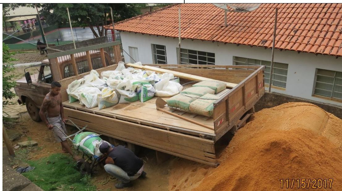
Figura 6 - Material que foi utilizado para fazer a base que suportaria os 02 reservatórios de 5 m 3 cada.
