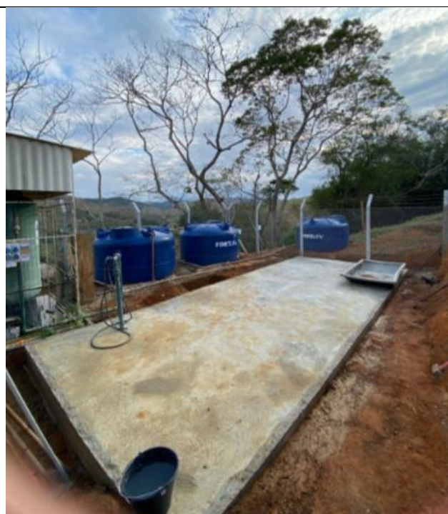
Figura 72: Execução da base dos novo reservatório de 15m 3 e 20m 3 .
