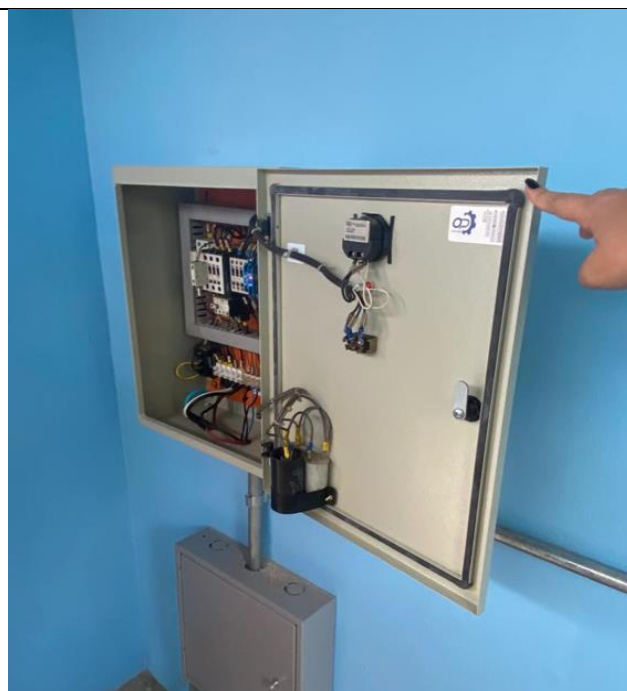
Figura 70: Substituição do painel elétrico do Poço 01 – Posto de Saúde.
