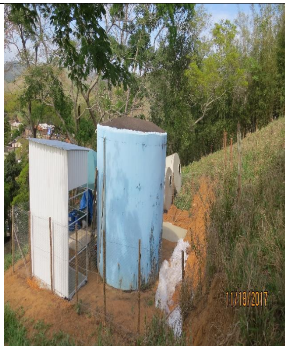
Figura 16 - Vista da implantação do abrigo do sistema de tratamento de água
