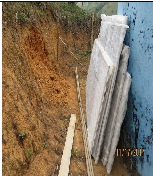
Figura 13 - Material referente ao abrigo do sistema de tratamento de água.
