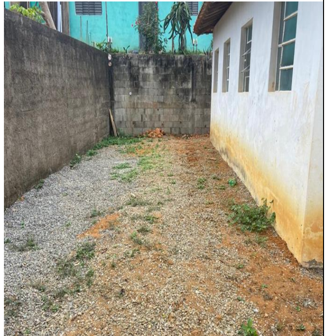
Figura 66: Conclusão da adutora e das melhorias do Poço 02 – Posto de Saúde
