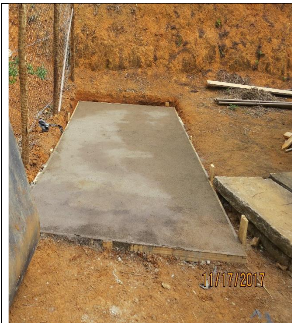
Figura 10 - Construção da base dos reservatórios
