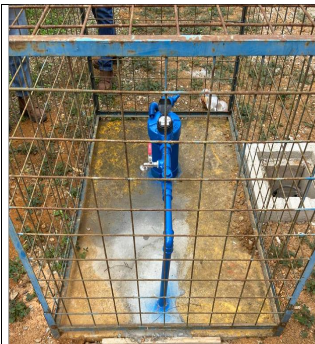
Figura 69: Pintura e adequações do cavalete poço 01 – Posto de saúde
