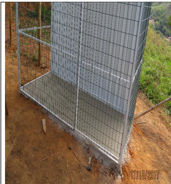
Figura 14 - Montagem do abrigo do sistema de tratamento de água
