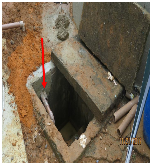
Figura 23 - Adequação da caixa de distribuição de água para comunidade e de descarga, para receber a descarga da retrolavagem do filtro.
