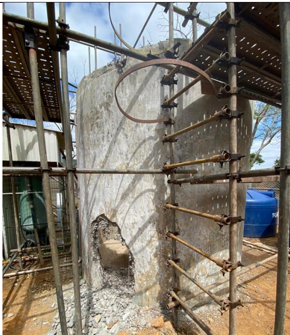
Figura 67: Demolição do reservatório existente a pedido da comunidade
