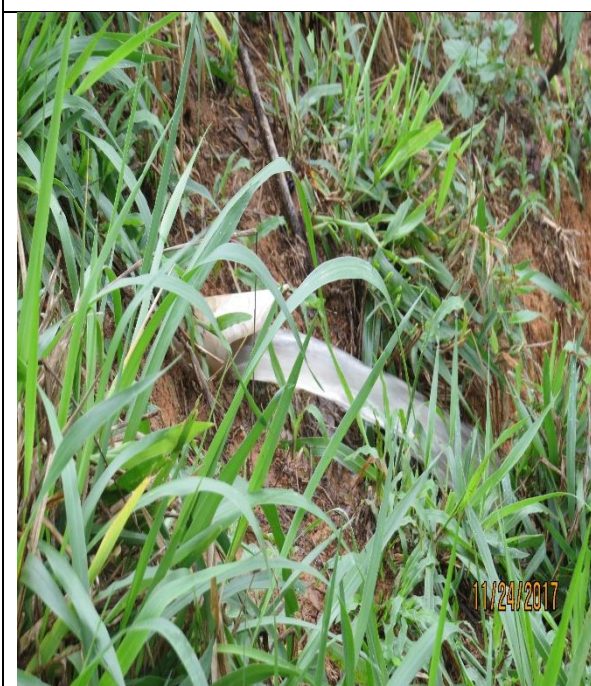
Figura 32 - Saída água de retrolavagem do filtro
