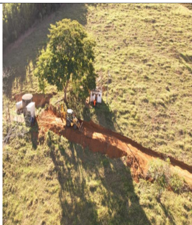
Figura 71: Abertura do acesso ao STA – Gesteira Mutirão
