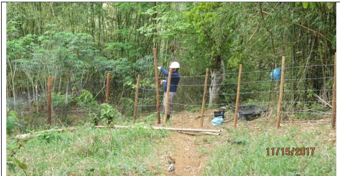
Figura 7 - Abertura de acesso, para transporte do material para a área do Reservatório.
