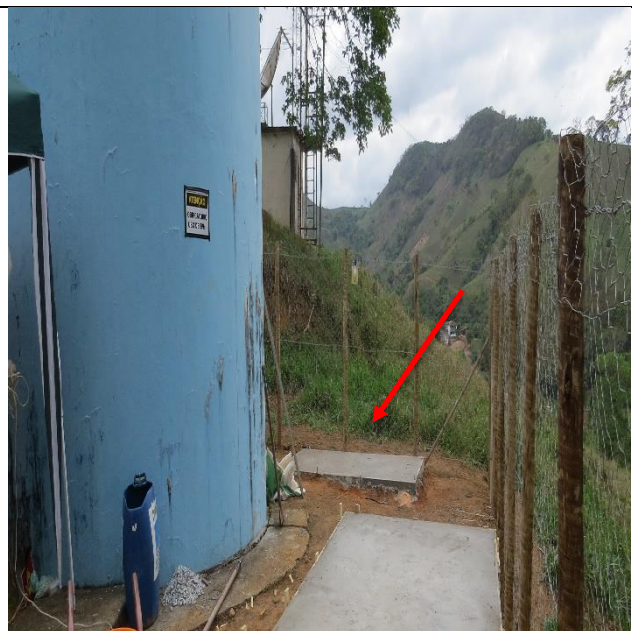
Figura 11 - Construção da base do sistema de tratamento de água
