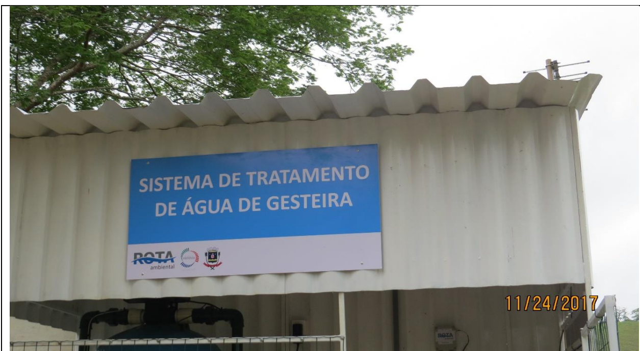
Figura 38 - Placa com a identificação do sistema e distrito.
