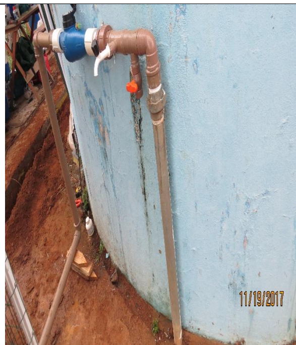
Figura 21 - Início da instalação do barrilete de interligação dos poços e de medição de vazão.
