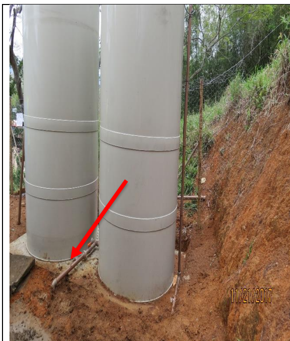
Figura 22 - Colocação dos reservatórios sobre a base. E no Detalhe: Tubulação que levará água tratada para a comunidade.
