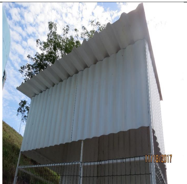
Figura 15 - Montagem do abrigo do sistema de tratamento de água
