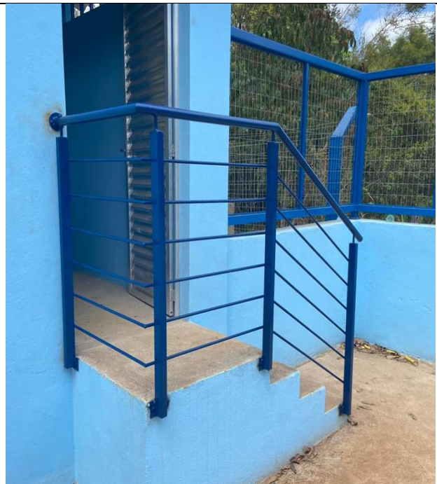
Figura 68: Montagem, instalação e pintura de guarda corpo do Poço 01 – Beira Rio
