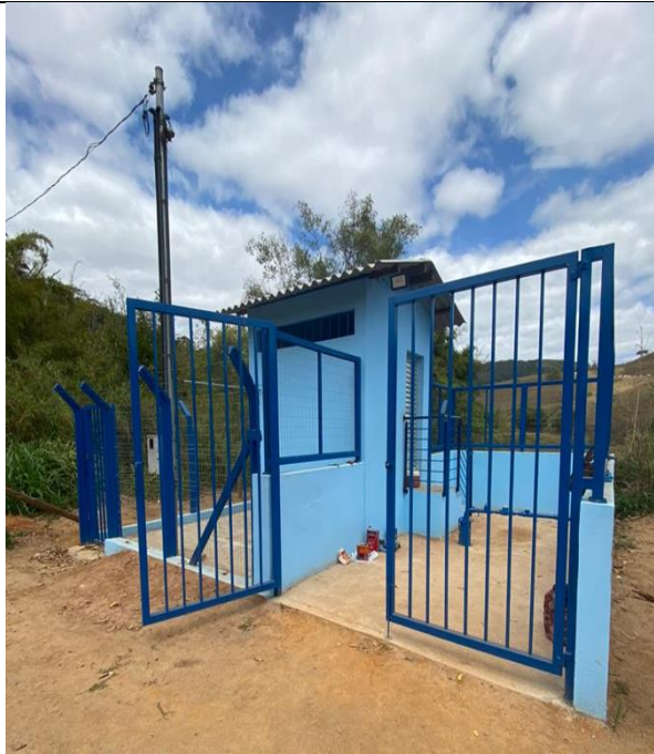
Figura 65: Conclusão das atividades civis, elétricas e mecânicas Poço 01 – Beira Rio
