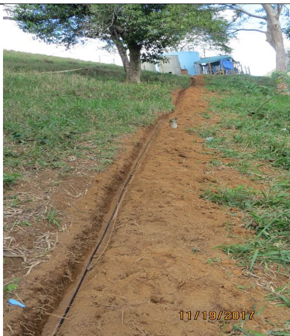
Figura 20- Abertura de vala para encaminhamento do cabo que faz a interligação do poço 02 – posto de saúde com o sistema de tratamento.
