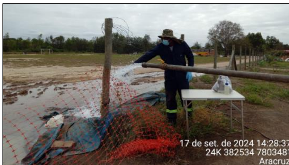
Foto 8 – Teste de vazão do poço construído na comunidade Pau Brasil, em 17.09.24.
