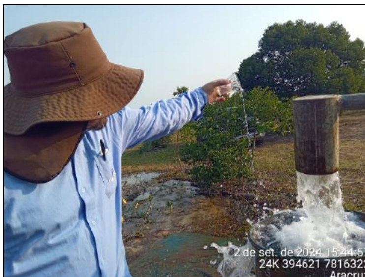
Foto 4 – Teste de vazão no poço construído na Comunidade Comboios.
