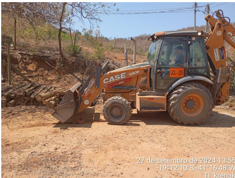
Foto 10 - Carregamento de Estacas
