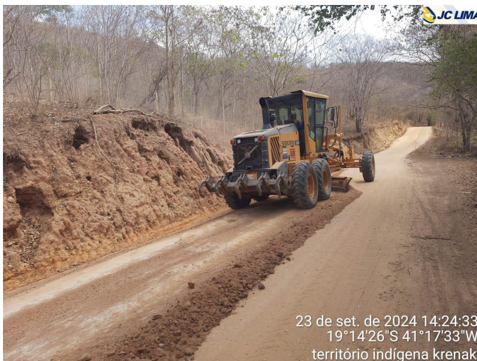
Foto 9 – Área de Manutenção de Vias
