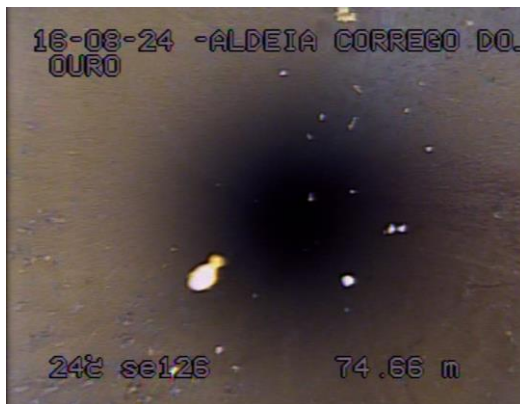
Fotos 24 e 25 – Em visada de fundo aos 74,66 e lateral aos 82,04 observa-se material precipitado na parede do tubo.
