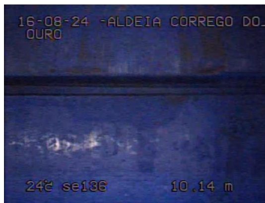
Fotos 12 e 13: Aos 10,14 metros, em visada lateral, observa-se conexão tubo x tubo. Aos 12,52m, em visada de fundo, nota-se o nível da água com um réptil morto, flutuando.
