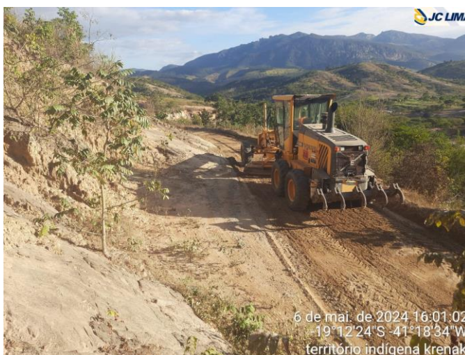
Foto 6 – Área de Manutenção de Vias
