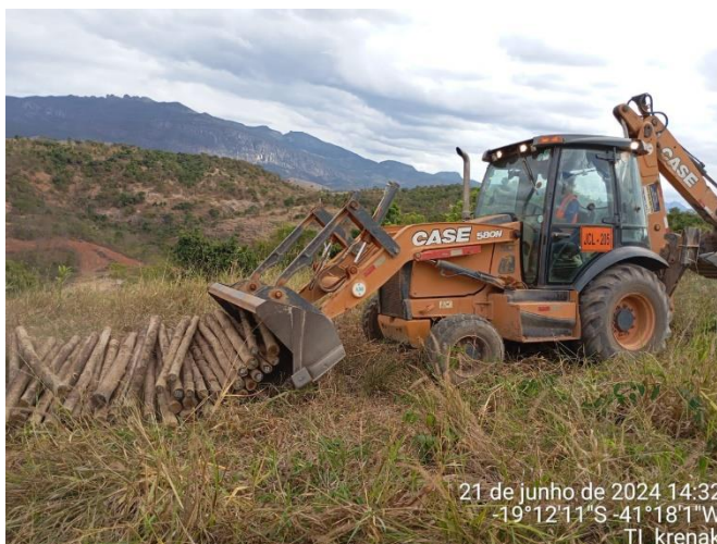
Foto 7 - Carregamento de Estacas
