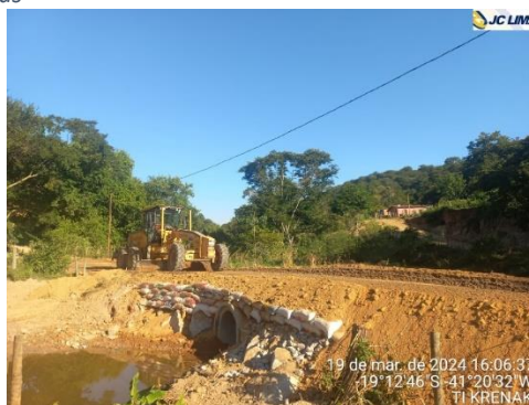
Foto 7 – Área de manutenção de vias
