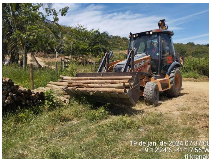
Foto 8 – Carregamento de Estacas
