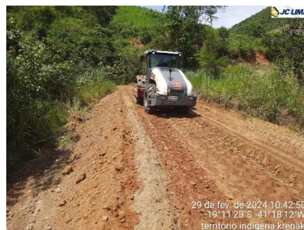
Foto 6 – Área de manutenção de vias
