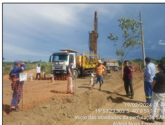
Foto 5 – Visita Integrada para Início do Poço na Comunidade de Nova Esperança
