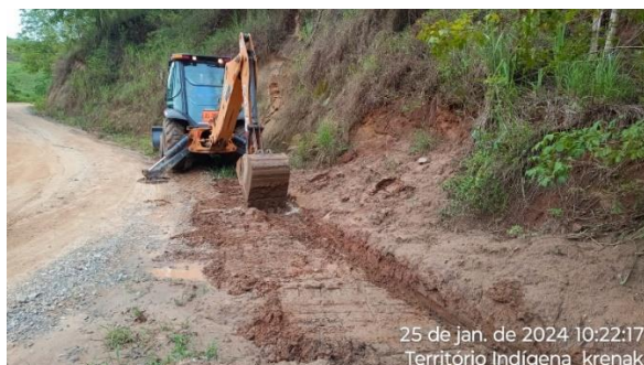
Foto 5 – Área de Manutenção de Vias
