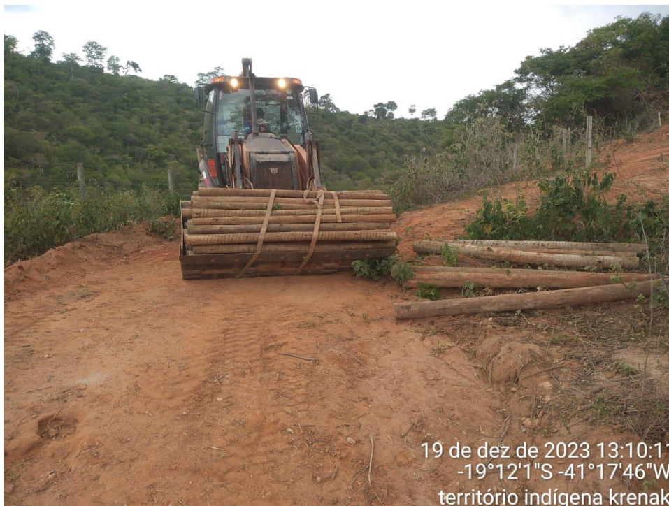
Foto 5– Carregamento de Estacas
