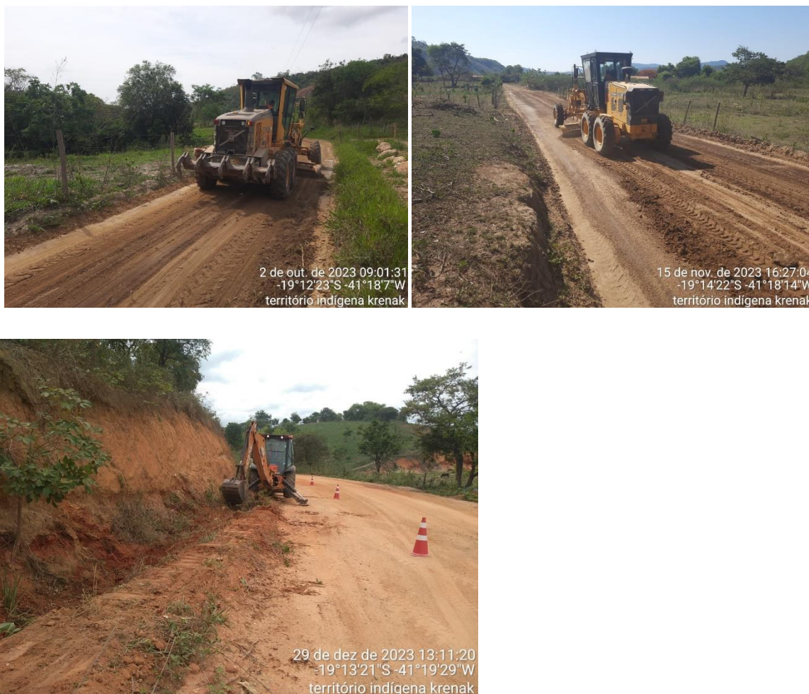
Foto 4 - Ações de Manutenção de Vias
