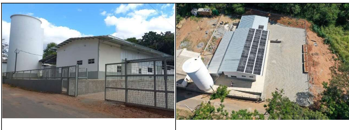
Figura 52 e 53 - Construção finalizada da Agroindústria, teto 60 placas fotovoltaicas.
