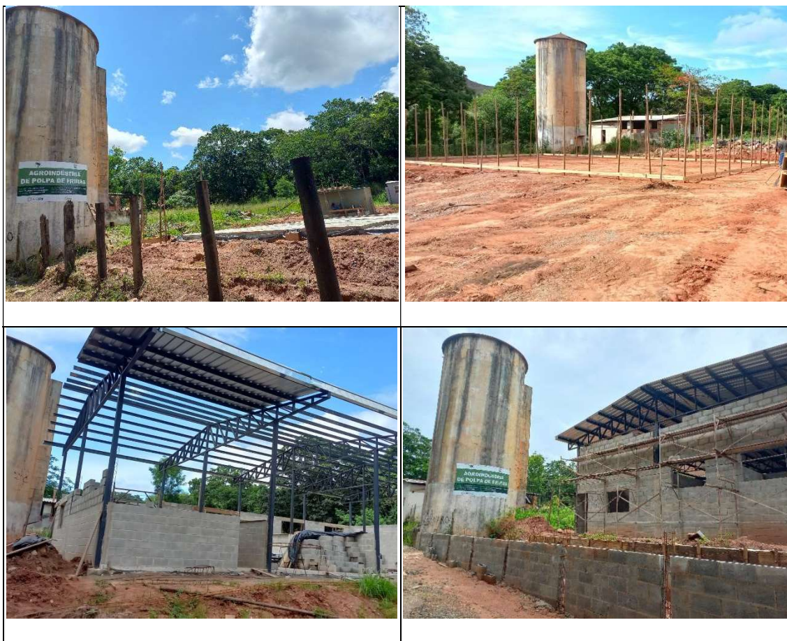
Figura 48 a 51 - Início das obras da Agroindústria.
