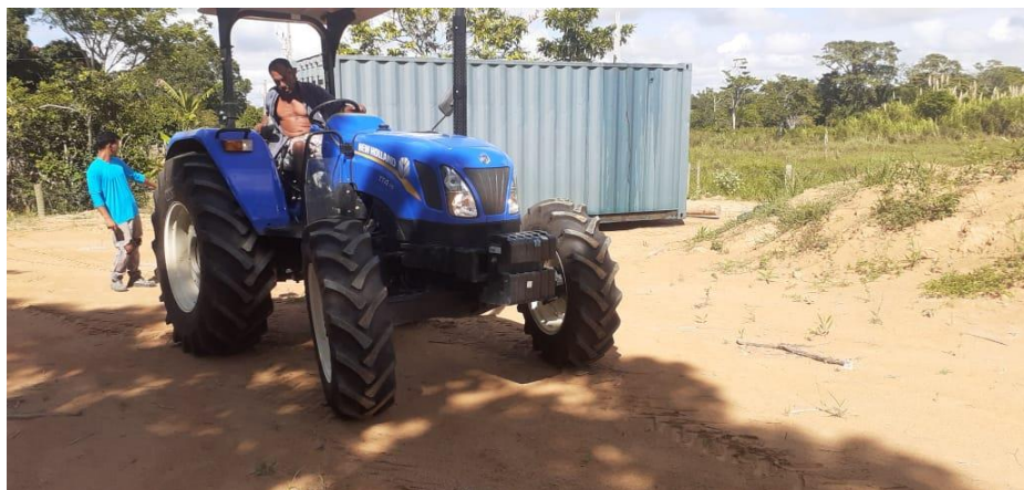
Figura 171. Realocação e instalação do contêiner na comunidade de Entre Rios.
