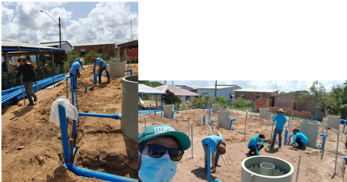
Figura 58. Continuidade das ações de montagem na comunidade de Areal.
