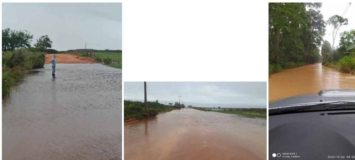
Figura 149. Acessos às comunidades de Entre Rios, Povoação e Areal ainda interditados.
