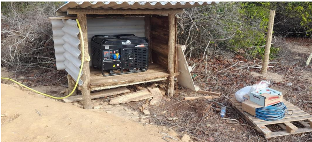
Figura 148. Instalação do sistema elétrico em Regência.
