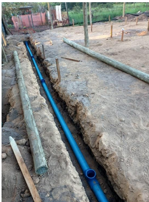
Figura 103. Finalização da montagem da estufa pelo fornecedor e início do preparo das canaletas para a implantação da hidroponia.
