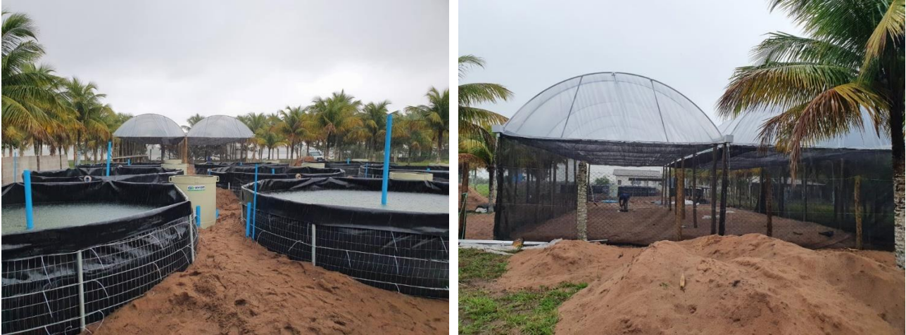
Figura 104. Finalização da montagem das unidades de produção de peixes e da estufa de Povoação.
