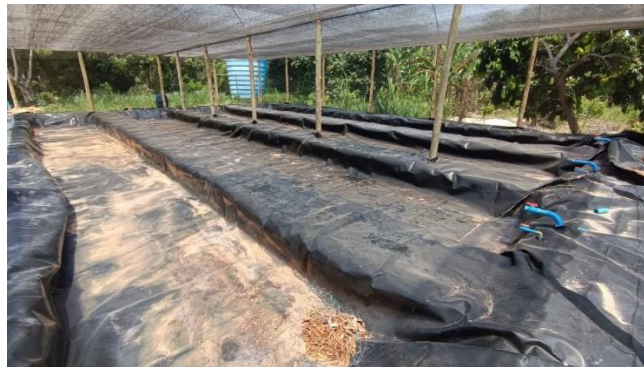
Figura 211. Canaletas finalizadas em Entre Rios e prontas para a recepção das mudas.
