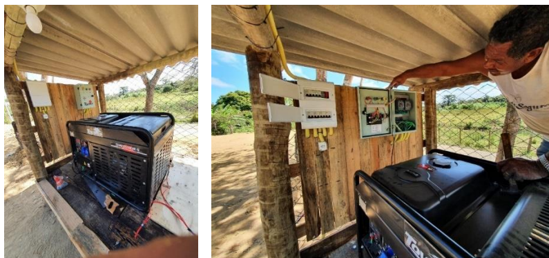
Figura 129. Instalação do sistema elétrico em Entre Rios.
