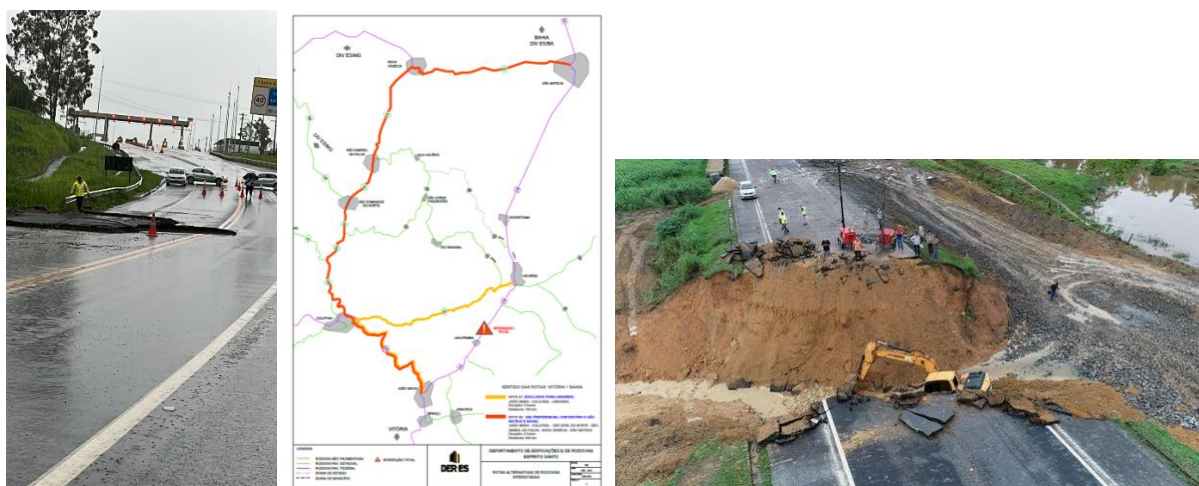
Figura 151. Desvio realizado na BR 101 após o rompimento total do acesso a Linhares por Vitória.
