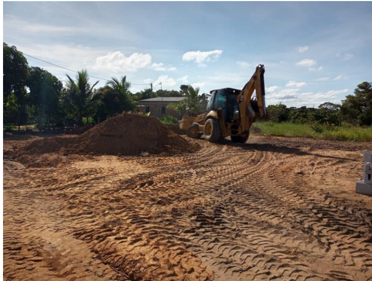
Figura 80. Finalização da preparação da área da instalação da estufa em Areal.
