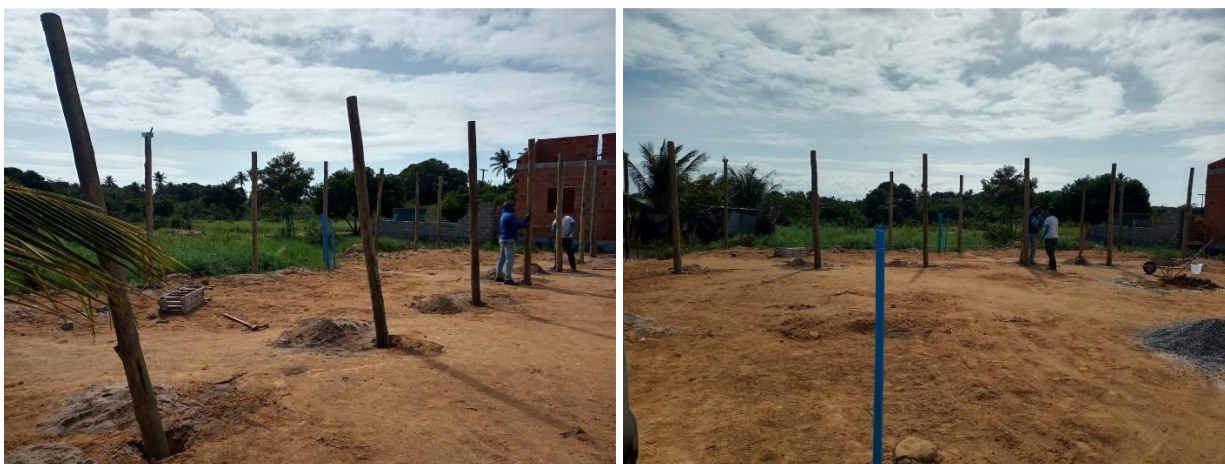
Figura 89. Início da montagem da estufa em Areal.
