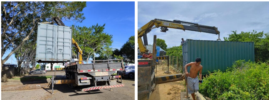
Figura 170. Traslado do contêiner do Ifes - Linhares para a instalação na unidade produtiva de Regência.
