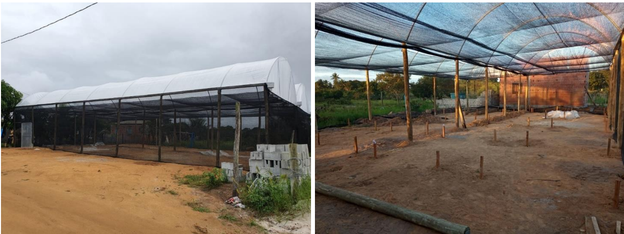
Figura 102. Finalização da montagem da estufa em Areal e início do preparo das canaletas para a implantação da hidroponia.
