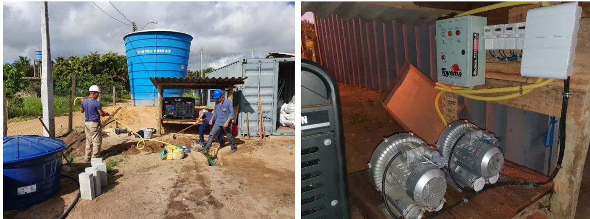
Figura 88. Finalização da montagem do sistema elétrico de Areal.
