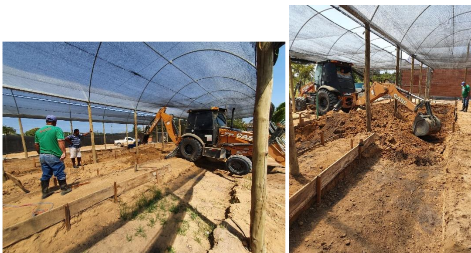
Figura 121. Finalização da escavação das canaletas da hidroponia em Areal.
