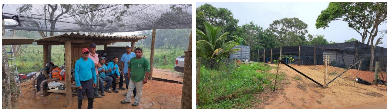
Figura 213. Equipe de montagem finalizando a unidade de Entre Rios.
