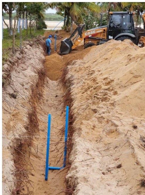
Figura 33. Instalação do sistema hidráulico em Povoação (ainda sem a participação da comunidade).
