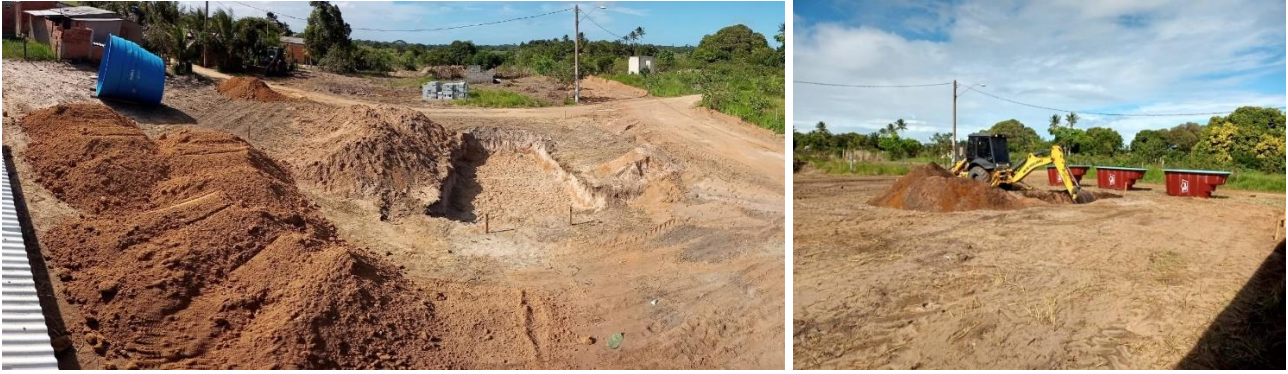
Figura 46. Abertura das valas de instalação dos sistemas de filtragem e hidráulico.
