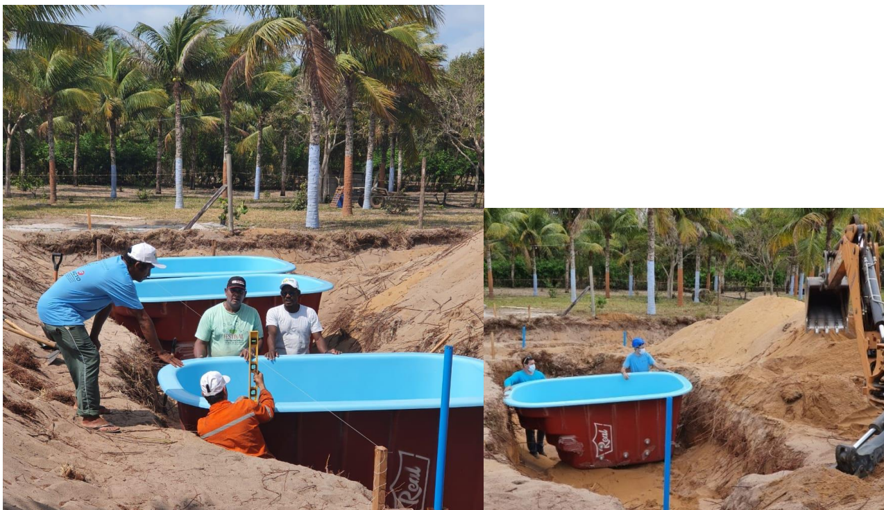
Figura 41. Instalação dos filtros físicos em Povoação.
