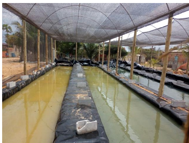
Figura 122. Finalização das canaletas em Areal.
