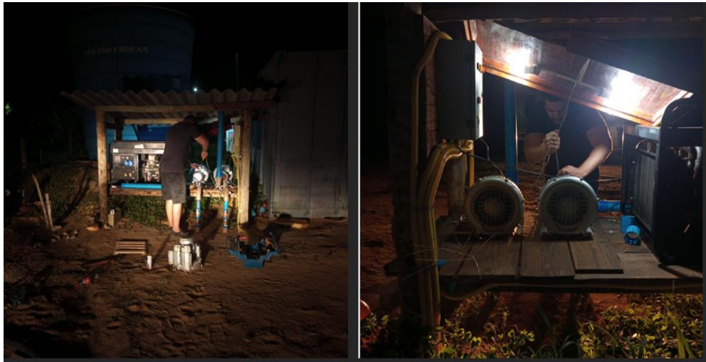
Figura 174. Manutenção corretiva no gerador da comunidade de Areal.
