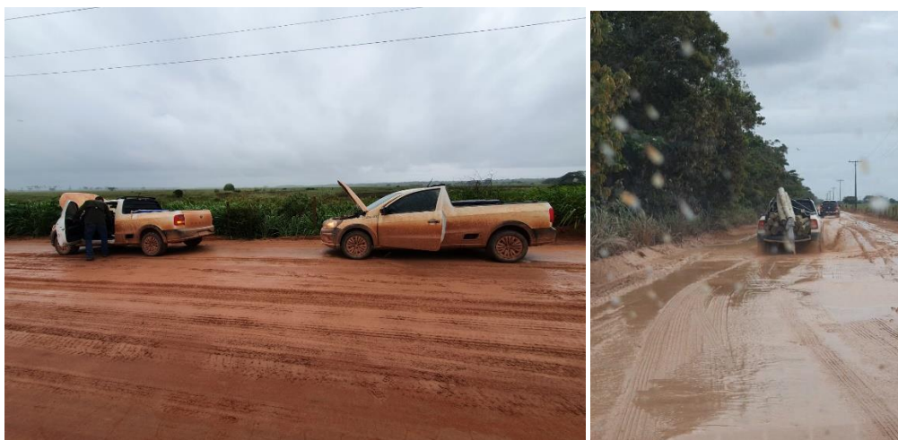
Figura 54. Chuvas intensas na região atrasam a montagem das estruturas nas comunidades.
