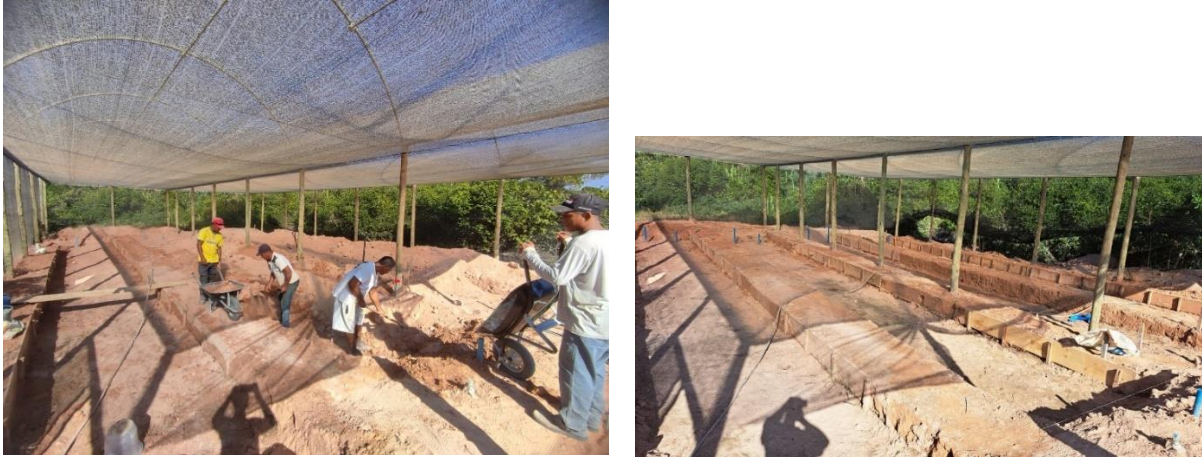
Figura 202. Evolução da montagem das canaletas na estufa de Regência.
