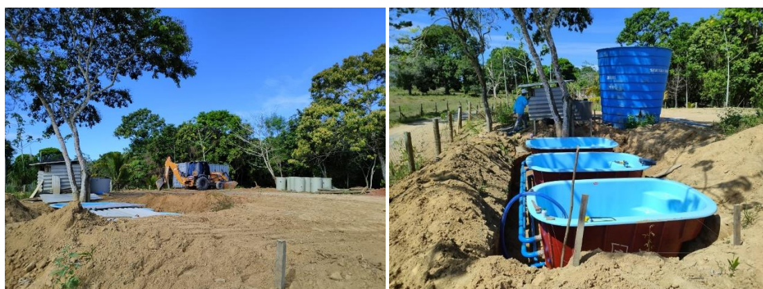
Figura 172. Retroscavadeira realizando o serviço de conserto do aterro e finalização da instalação dos filtros.
