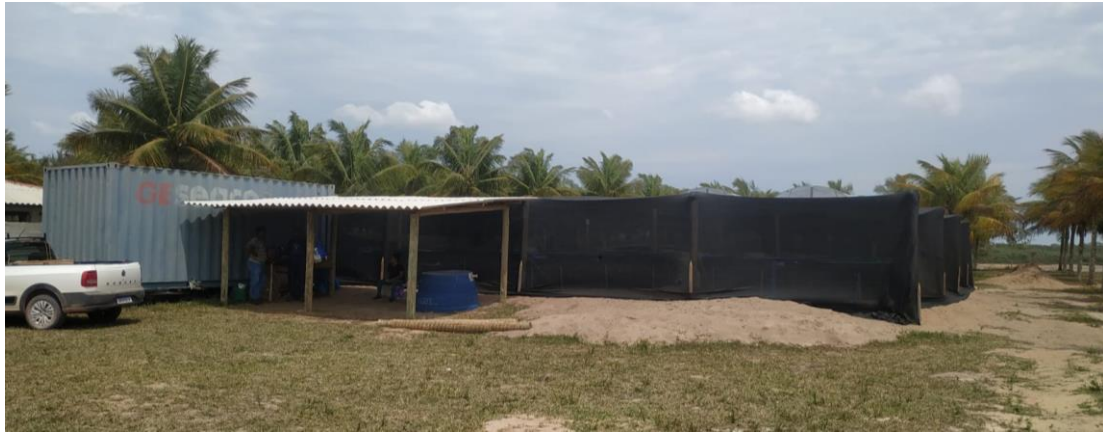
Figura 126. Instalação do sombrite na unidade de Povoação.
