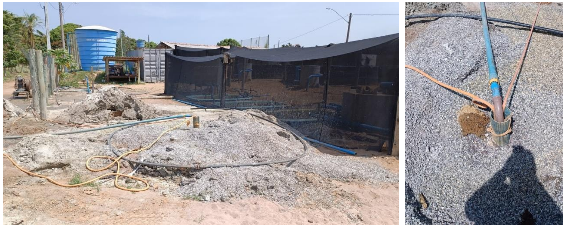
Figura 207. Finalização da perfuração do poço profundo em Areal.
