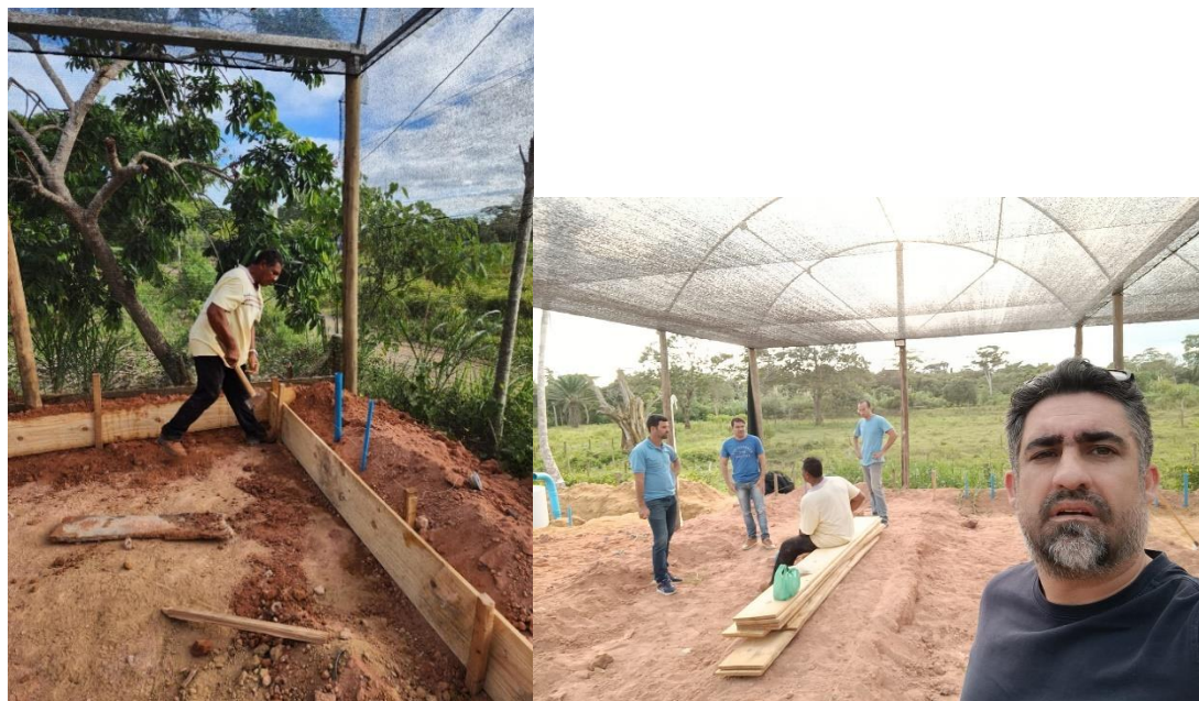
Figura 194. Construção das canaletas da hidroponia em Entre Rios.
