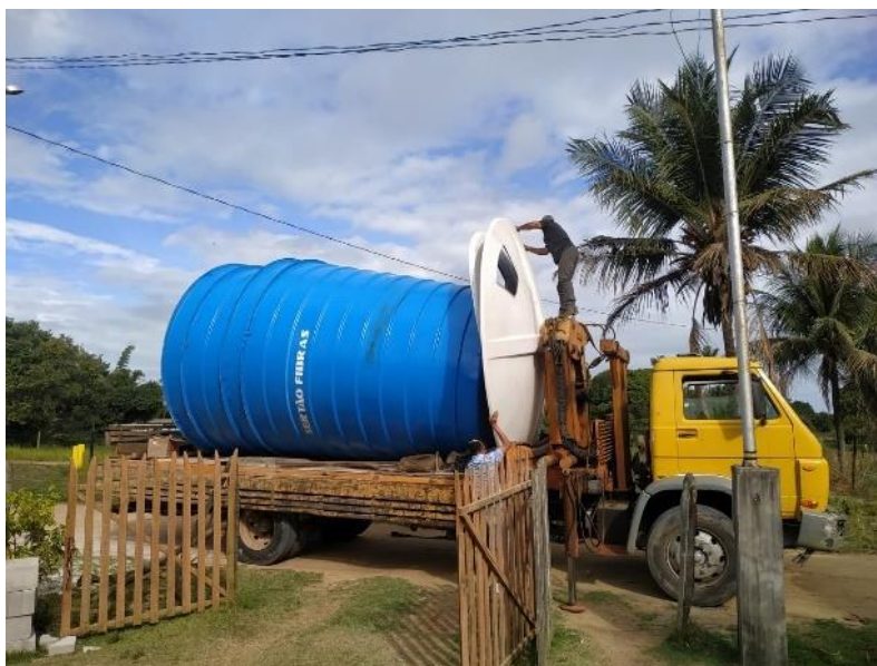
Figura 2. Entrega das caixas d'água de grande volume nas comunidades.
