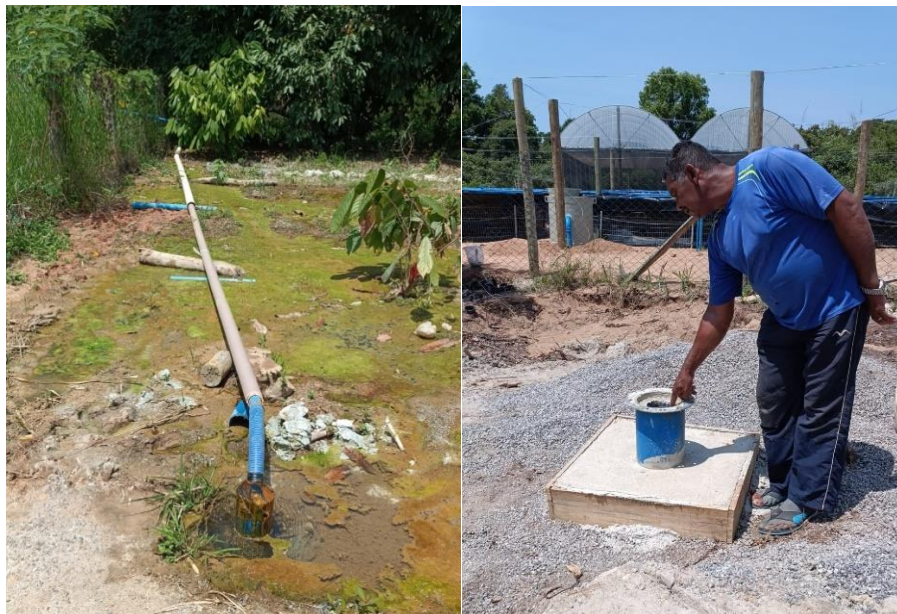
Figura 208. Poço finalizado em Entre Rios (esquerda) e Regência (direita).
