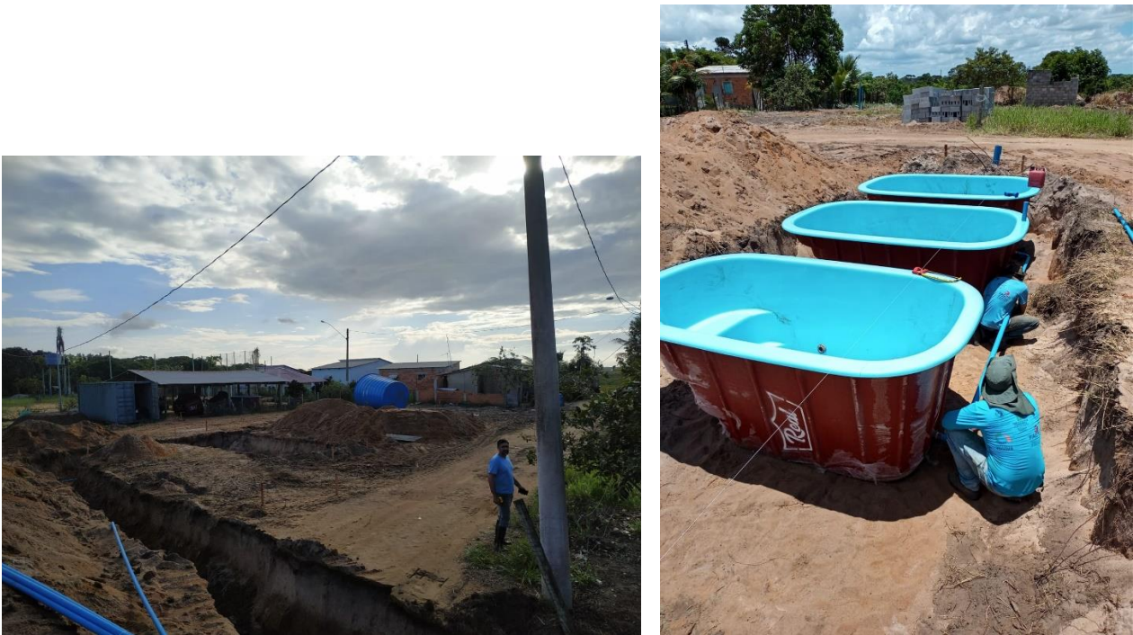
Figura 47. Instalação dos filtros em Areal.
