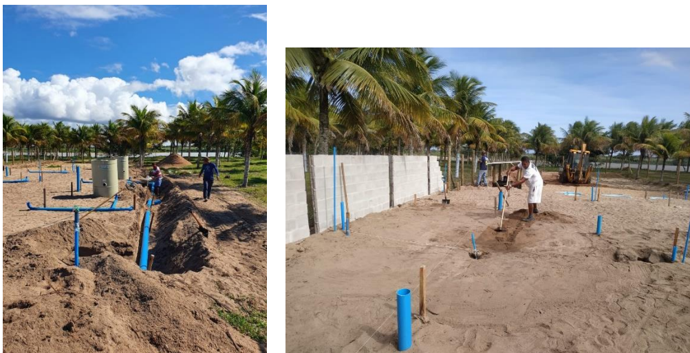
Figura 91. Finalização da implantação do sistema hidráulico em Povoação.
