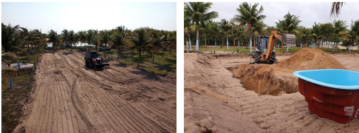
Figura 32. Preparação do terreno em Povoação e abertura das valas para alocação dos filtros físicos (ainda sem a participação da comunidade).
