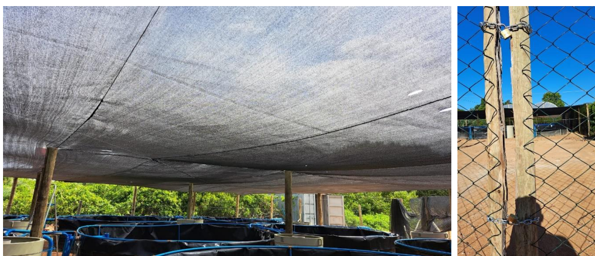
Figura 214. Finalização da montagem de Regência.
