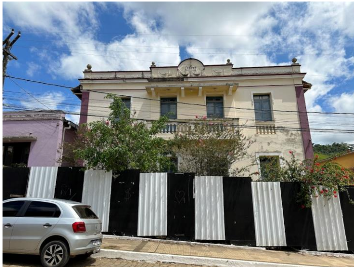
Foto 20: Fachada Frontal da Residência José Lanna. Fundação Renova.
