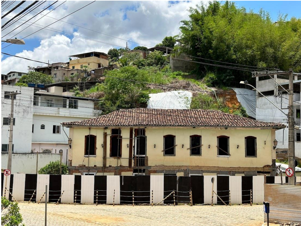
Foto 19: Fachada Frontal Hotel Xavier de Barra Longa. Fundação Renova: 12/2023.
