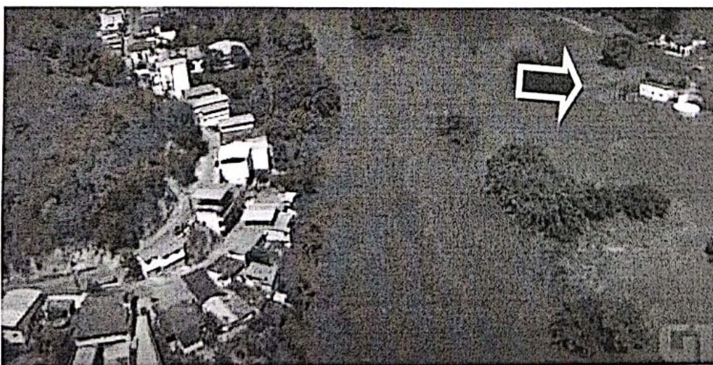
Figura 2: Imagem retirada do site do portal de notícias G1, da TV globo, o qual mostra a imagem aérea da sede da copasa em Barra Longa/MG atingida pela lama
