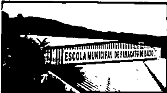
Troca do telhado por telhas com isolamento térmico e instalação de placa com nome da escola
