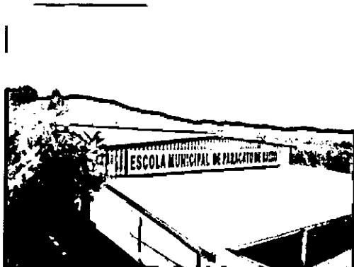
Troca do telhado com isolamento térmico
