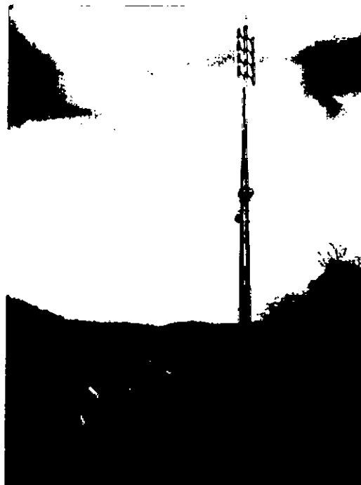
Sirene instalada em Ponte do Gama (120) – 06/09/16
