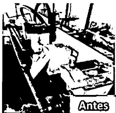
Reforma nos Tanques (Revestimento com Fibra de Vidro) de Produtos Químicos Reforma Caixas Dosadoras de Produtos Químicos
