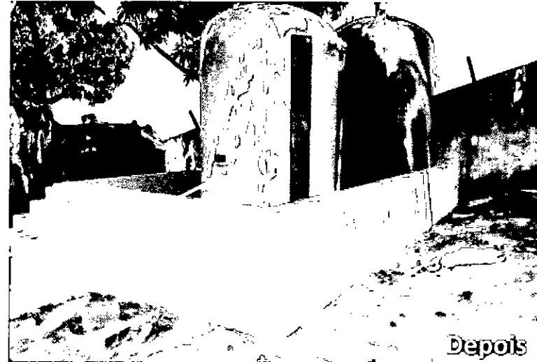
Instalação de Tanque de Tanfloc de 15.000l Construção de Caixa de Contenção para Tanfloc e Sulfato de Alumínio
