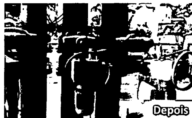
Instalação de 12 válvulas Automáticas nos Drenos dos Decantadores (Novembro/2016)
