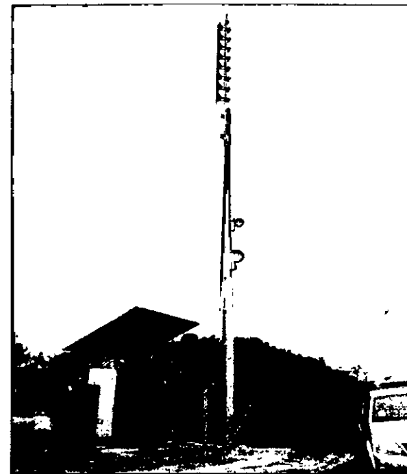
Sirene instalada em Paracatu de Baixo (140)- 03/10/16
