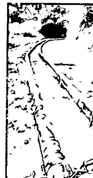
Andamento das obras Pancas (Colatina): - Início do lançamento da tubulação
