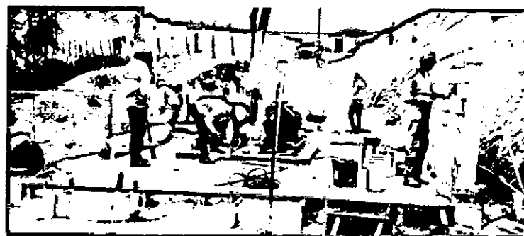
Andamento das obras Santa Maria (Colatina): - Início da base civil e estrutura civil estação de bombeamento
