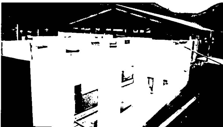
Finalização da montagem e concretagem das placas de PVC
