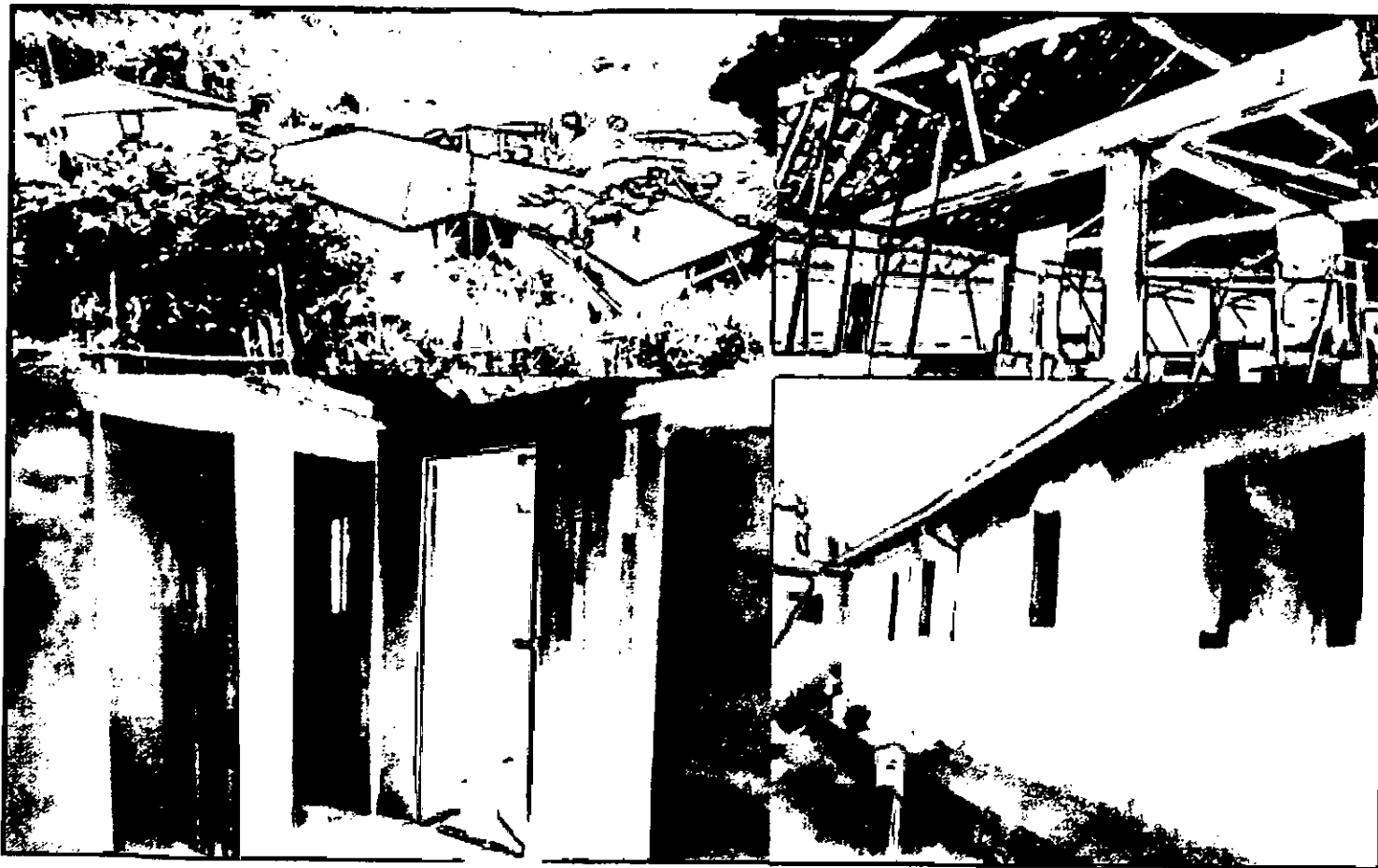
Obra em andamento - MAINART
