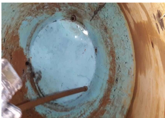
Jateamento do interior da torre de armazenamento d'água durante a reforma (à esquerda) e resultado da pintura no mesmo interior (à direita). (Crédito: Divulgação)
