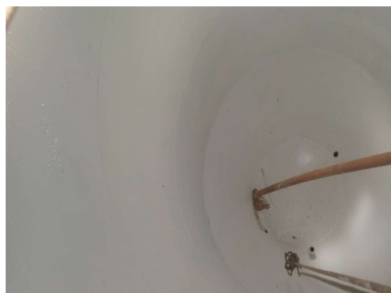
Jateamento do interior da torre de armazenamento d'água durante a reforma (à esquerda) e resultado da pintura no mesmo interior (à direita). (Crédito: Divulgação)
