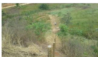
Galiléia/MG Verificação de cerca concluída
