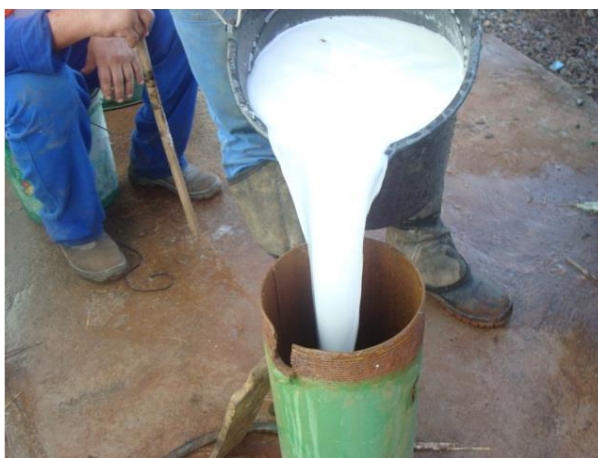
Limpeza e desinfecção do poço em Barra Longa – Gesteira – Junho/2018 (Crédito: Divulgação Fundação Renova)
