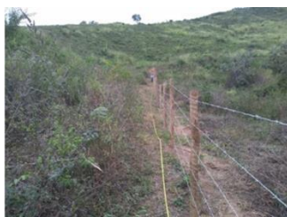
Periquito/MG Verificação de cerca concluída
