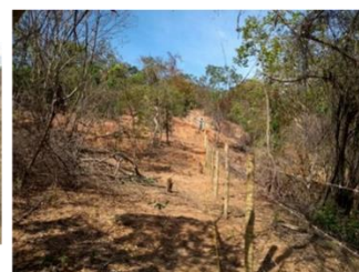
Galiléia/MG Verificação de cerca concluída
