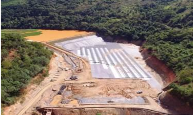
Preparação da fundação à jusante do setor 4A para recebimento dos ecobags
