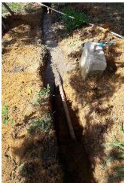
Envelopamento de tubulação de Rede Hidráulica para Interligação do Poço até a Caixa D'água - Sr. Ivaldil, em Mariana – dezembro/2017 (Crédito: Divulgação Fundação Renova)
