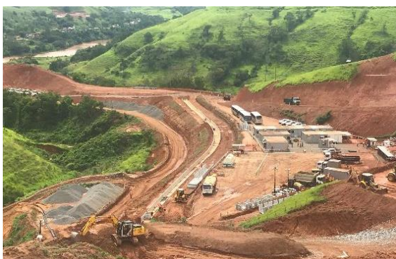
Drenagem superficial diques FF – dezembro/2017 (Crédito: Divulgação Fundação Renova)
