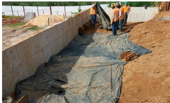
Execução de concreto magro para complemento do muro de contenção na reconstrução de residência em propriedade rural do Sr. Arlindo, em Mariana – dezembro/2017 (Crédito: Divulgação Fundação Renova)
