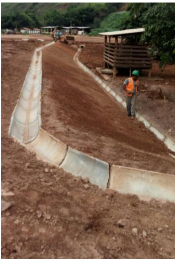
Meia cana DN 500mm na rede de drenagem no campo Barralonguense, em Barra Longa – dezembro/2017 (Crédito: Divulgação Fundação Renova)
