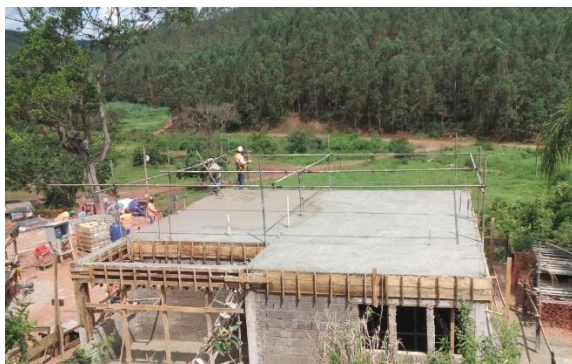
Concretagem de laje e vigas na reconstrução de residência em propriedade rural do Sr. Marcio de Souza, em Mariana – dezembro/2017 (Crédito: Divulgação Fundação Renova)
