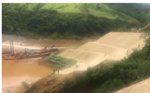
Hidrossemeadura Ponto P2 – recuperação das margens do Reservatório – dezembro/2017 (Crédito: Divulgação Fundação Renova)
