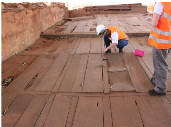
Remoção do rejeito debaixo das campas da Capela de São Bento (Crédito: Divulgação Fundação Renova)
