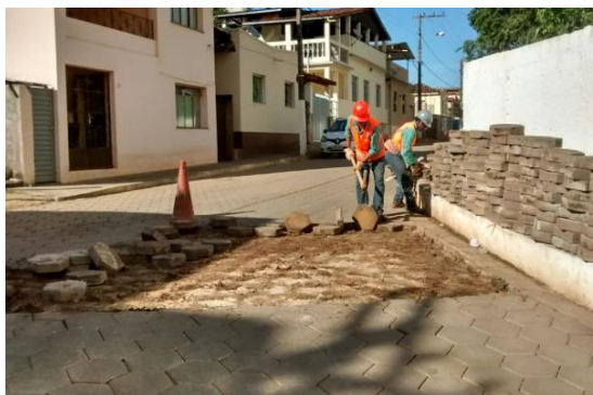
Execução de recuperação de piso de concreto intertravado sextavado (com reaproveitamento de blocos existentes), na Rua 1º de Janeiro, em Barra Longa – dezembro/2017 (Crédito: Divulgação Fundação Renova)
