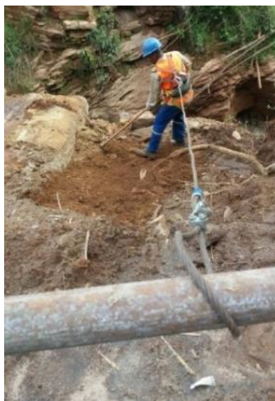
Escavação/demolição de rocha na reforma da ponte de Bento x Camargos, em Mariana – dezembro/2017 (Crédito: Divulgação Fundação Renova)
