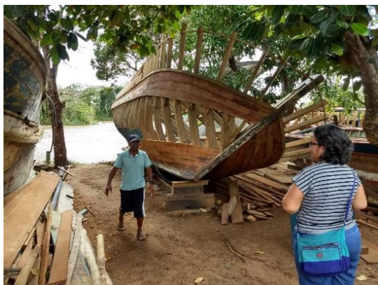
Demanda por construção de rampa de acesso e estaleiro em Regência (ES) - novembro/2017 (Crédito: Divulgação Fundação Renova)
